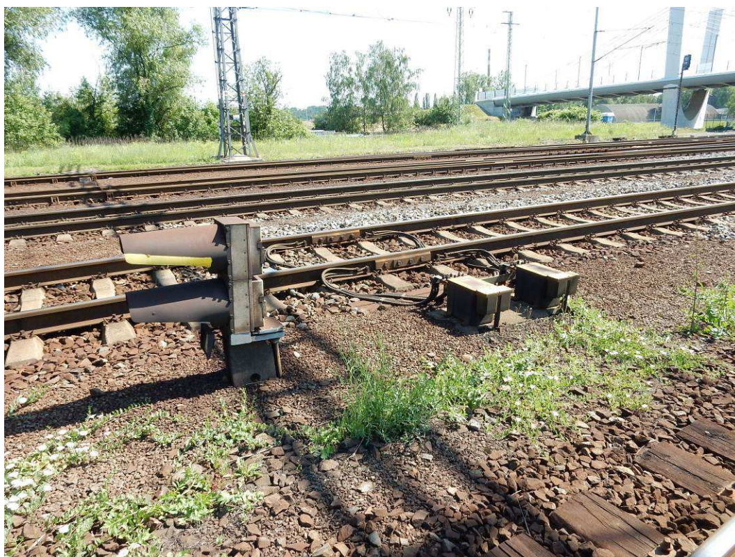
Obrázek 1: Obnovovaný izolovaný styk u návěstidla Se7
