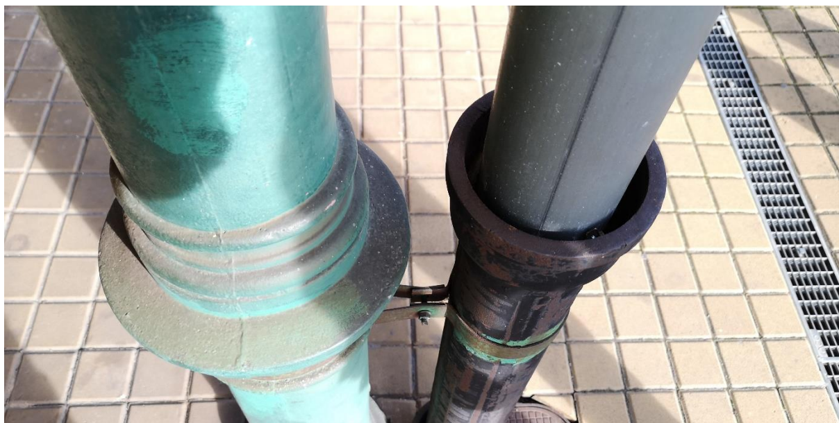
Chybějící či vytahaná kovová vata
