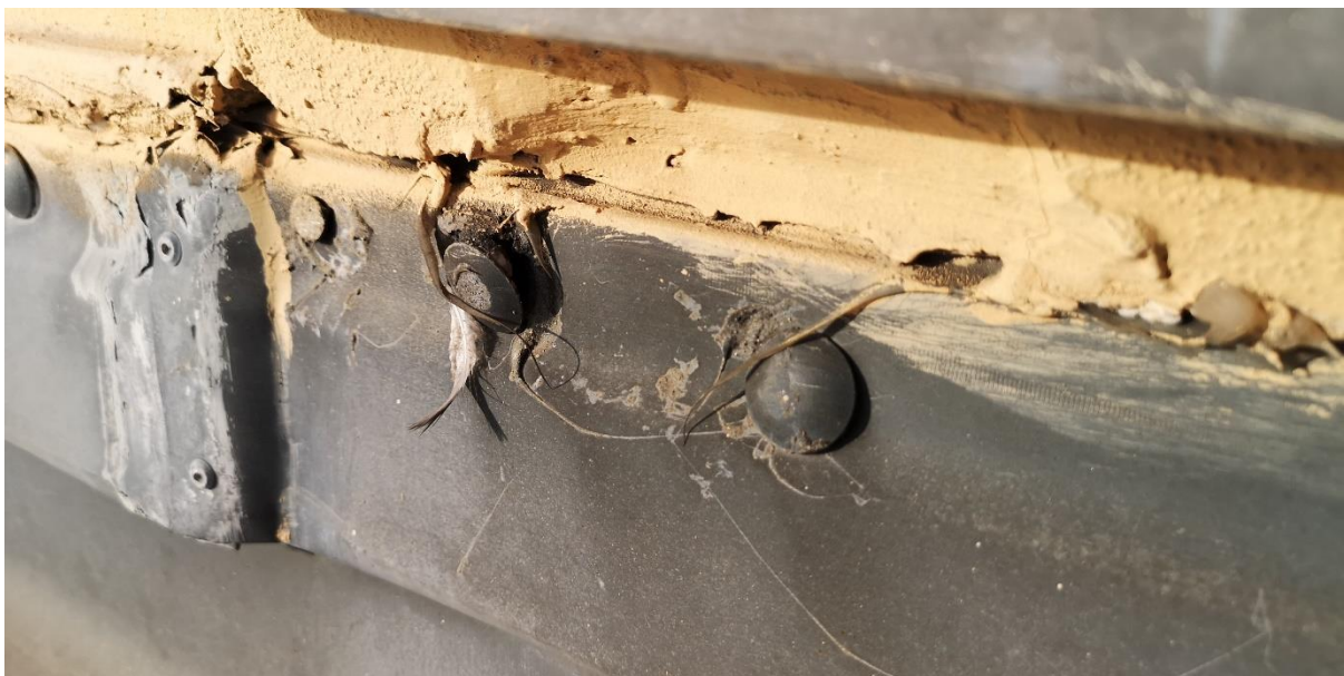
Lokální netěsnosti, uvolněné krycí čepičky krytiny
