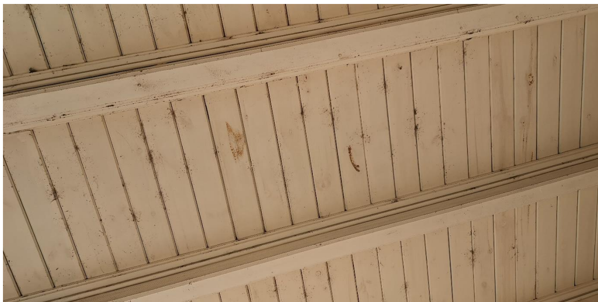
Stav ochranného nátěru dřevěných konstrukcí
