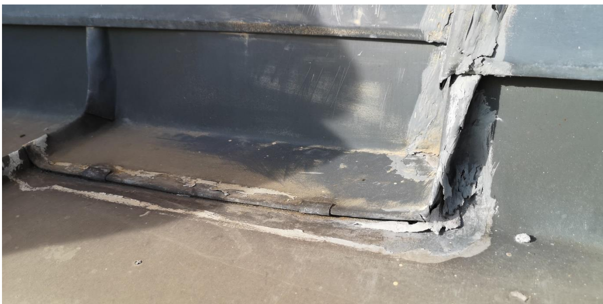
Vypraskaný a odtržený tmel ve sparách
