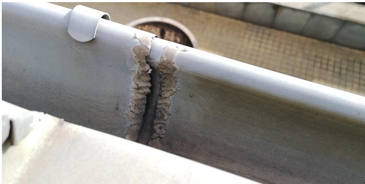
Roztržený žlab z důvodu dilatace/tepelné roztažnosti
