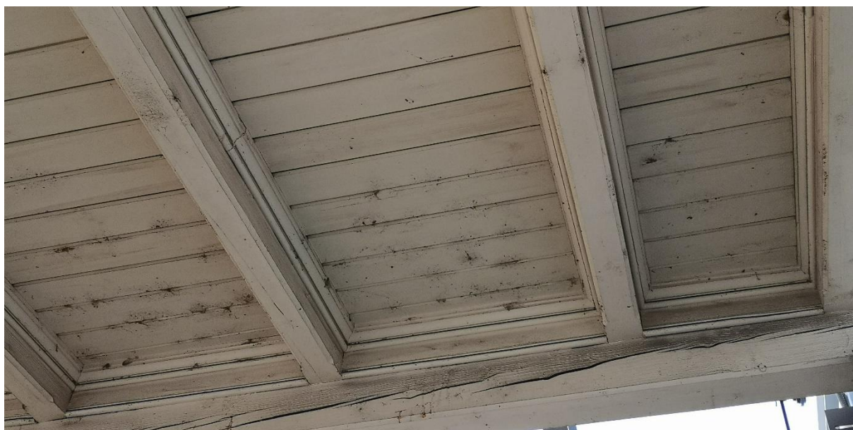
Stav ochranného nátěru dřevěných konstrukcí
