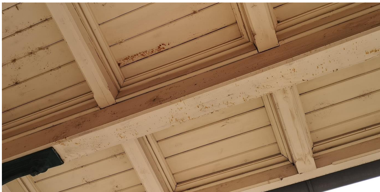
Stav ochranného nátěru dřevěných konstrukcí
