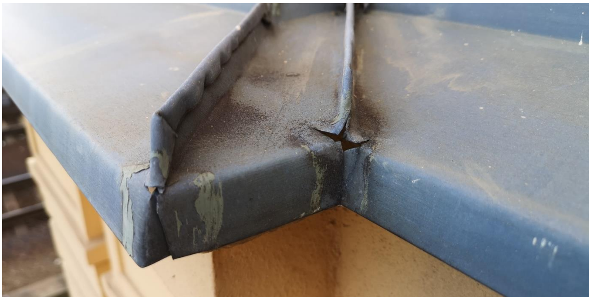
Trhliny titanzinkového plechu v mechanicky exponovaných místech
