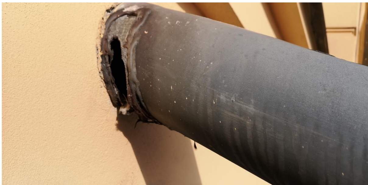
Děravé vývody zaatikového žlabu
