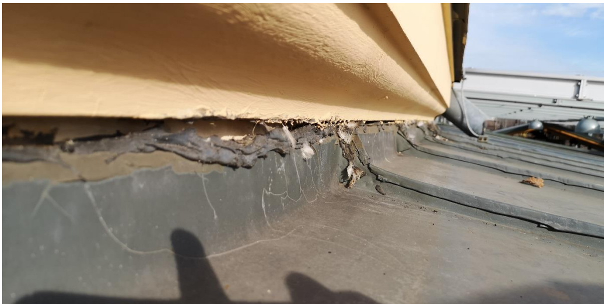
Netěsná spára mezi krytinou a římsou VB
