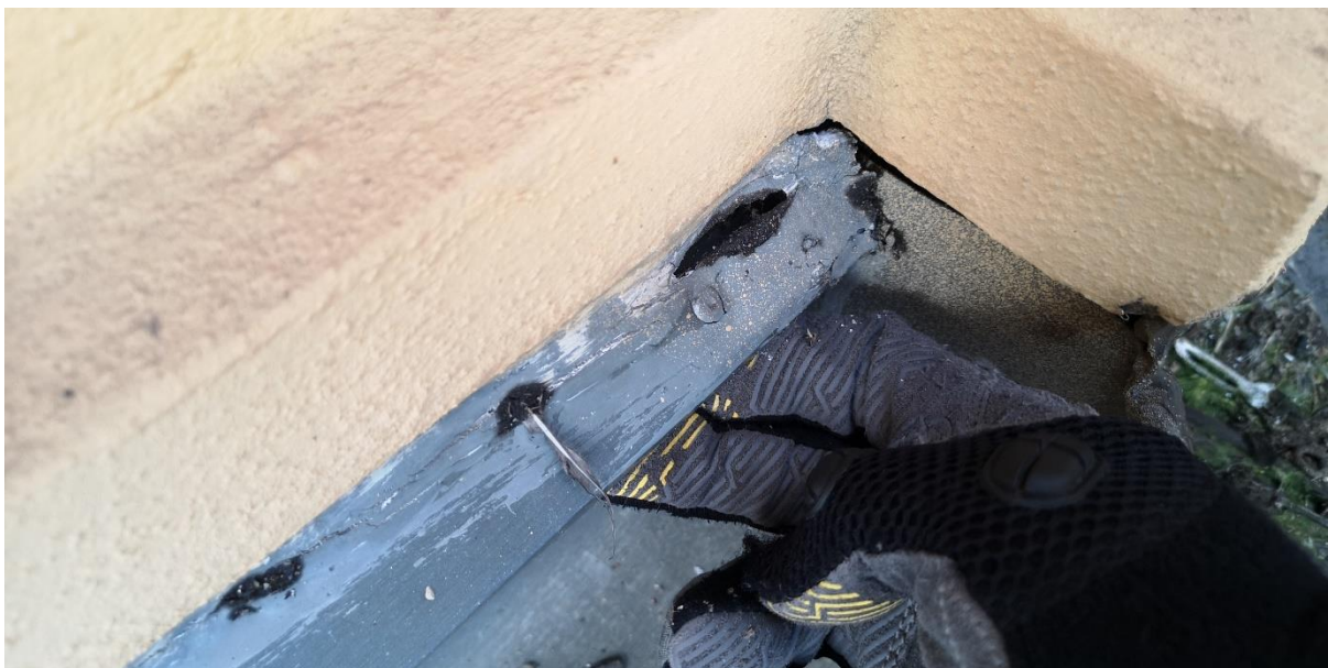
Lokální netěsnosti pláště
