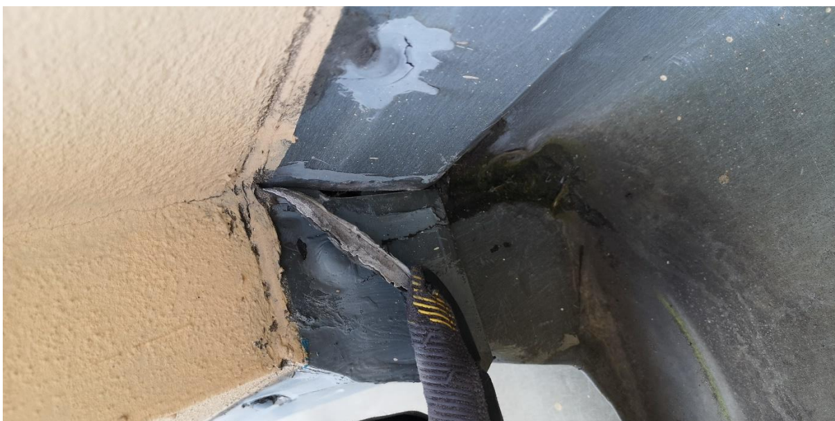
Lokální netěsnosti pláště
