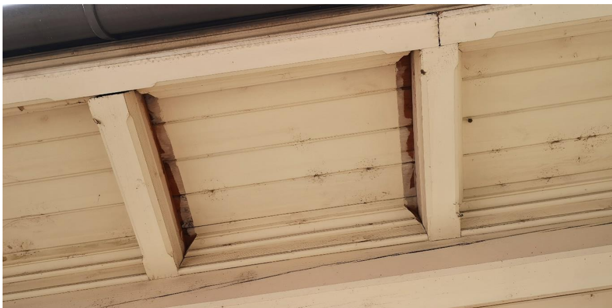
Chybějící ozdobné laťování podhledu
