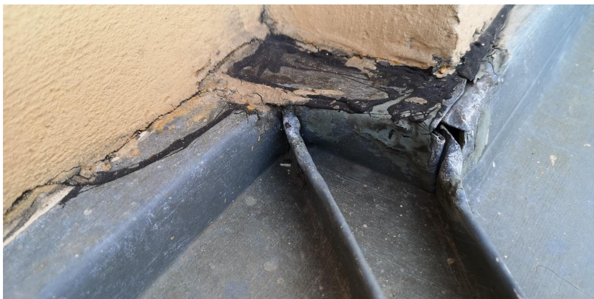
Lokální netěsnosti pláště
