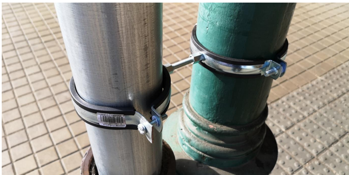
Provedení úchytu svodu neslučitelné s historicky ceněnou chráněnou konstrukcí
