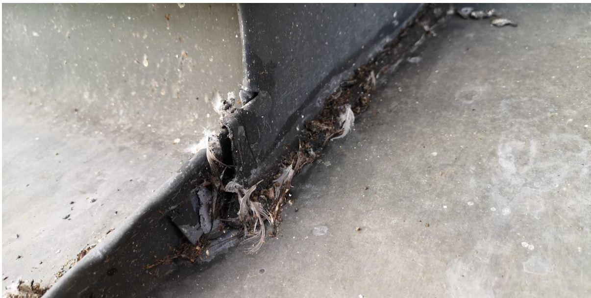
Lokální poruchy krytiny a nečistoty
