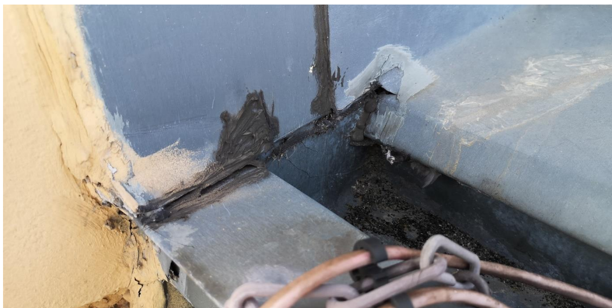
Netěsnosti zaatikového žlabu
