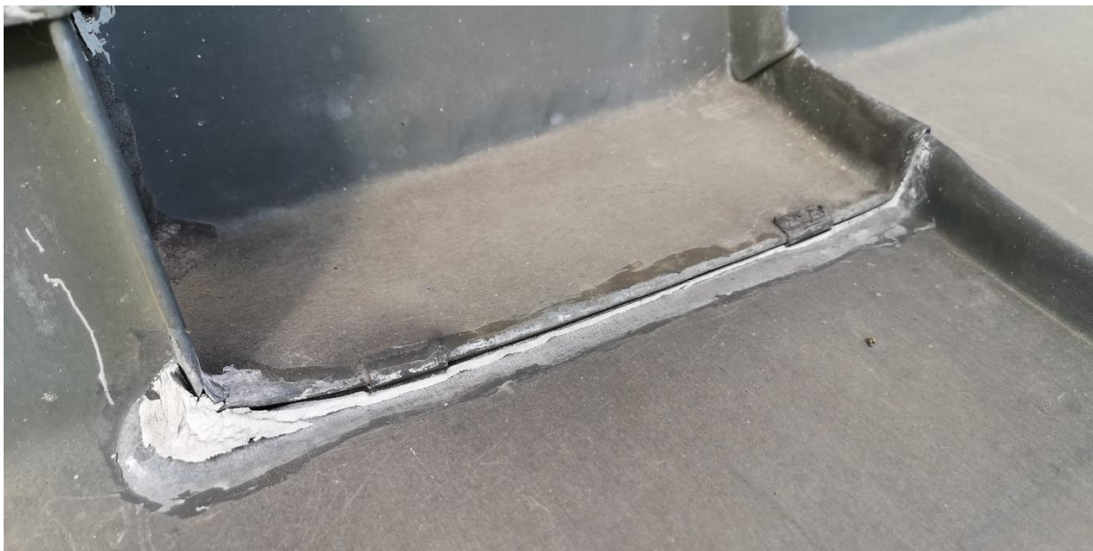
Vypraskaný a odtržený tmel ve sparách
