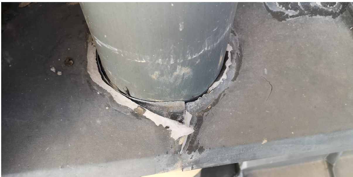
Vypraskaný a odtržený tmel ve sparách
