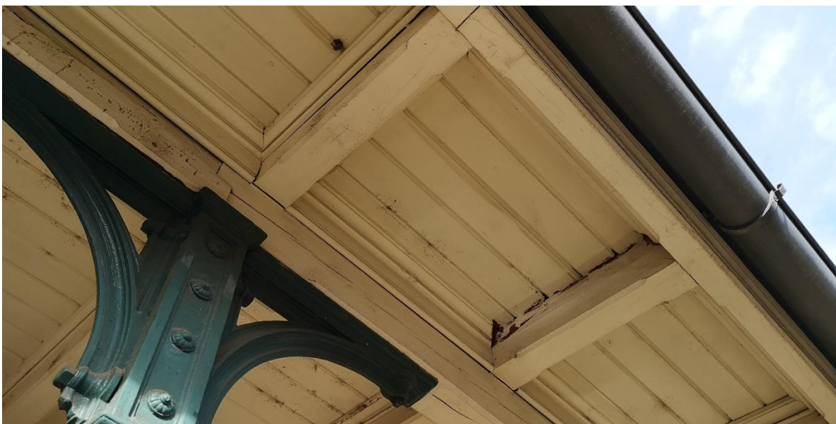
Chybějící ozdobné laťování podhledu
