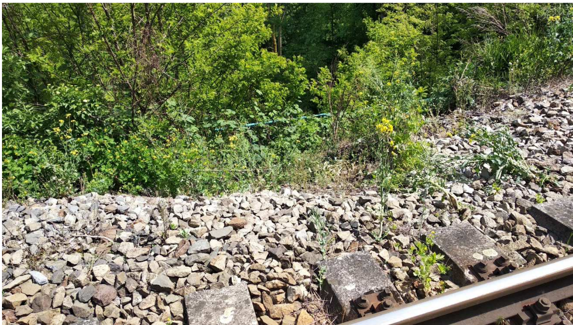
Obr. 1: Detail povrchového sesuvu zasahujícího částečně i pod kolejové lože nad propustkem v kilometrické poloze 66,482
