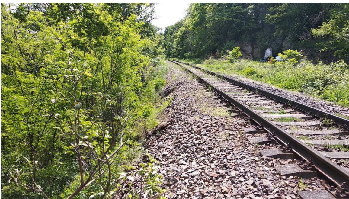
Obr. 2: Povrchové sesuvy strmého svahu náspu u propustku v kilometrické poloze 66,482
