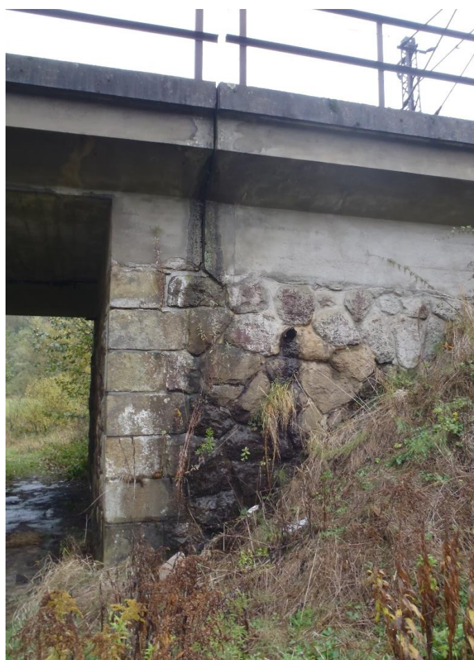
Foto 4: Mokrý stopy po zatékání z dilatační spáry
