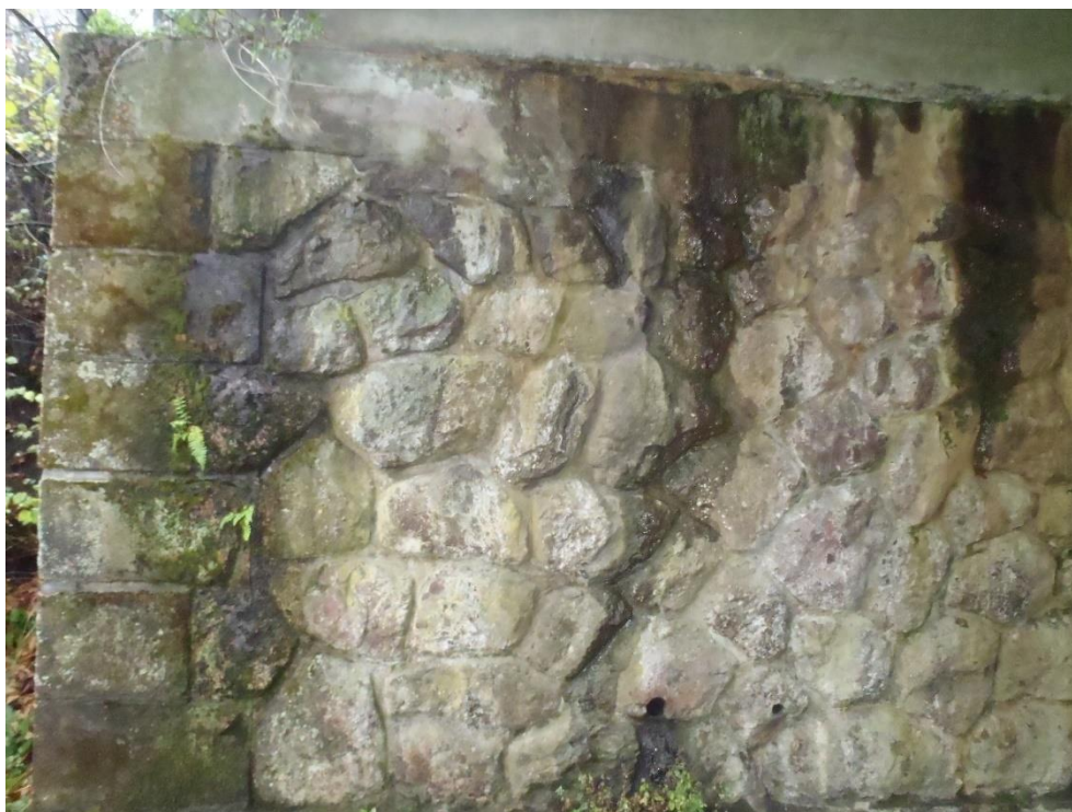
Foto 3: Masivní průsaky vody
