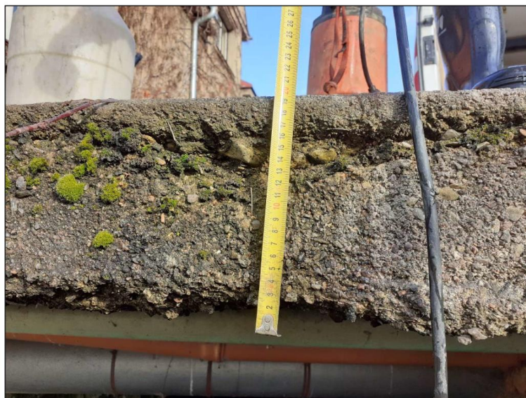
Foto 1: tloušťka stropní betonové desky propustku
