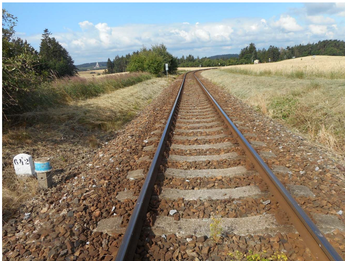
Obr. 3: Chybějící odvodnění v km 64,200
