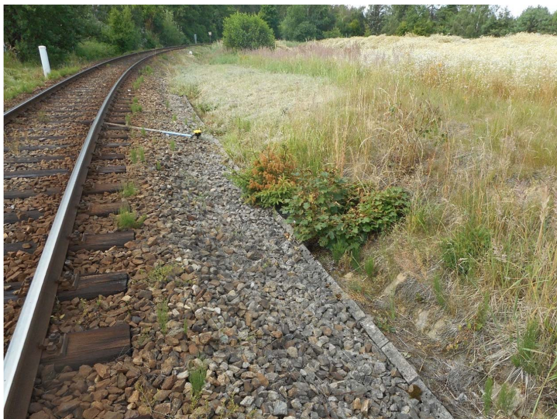
Obr. 2: Stávající příkopové tvárnice v km 63,750
