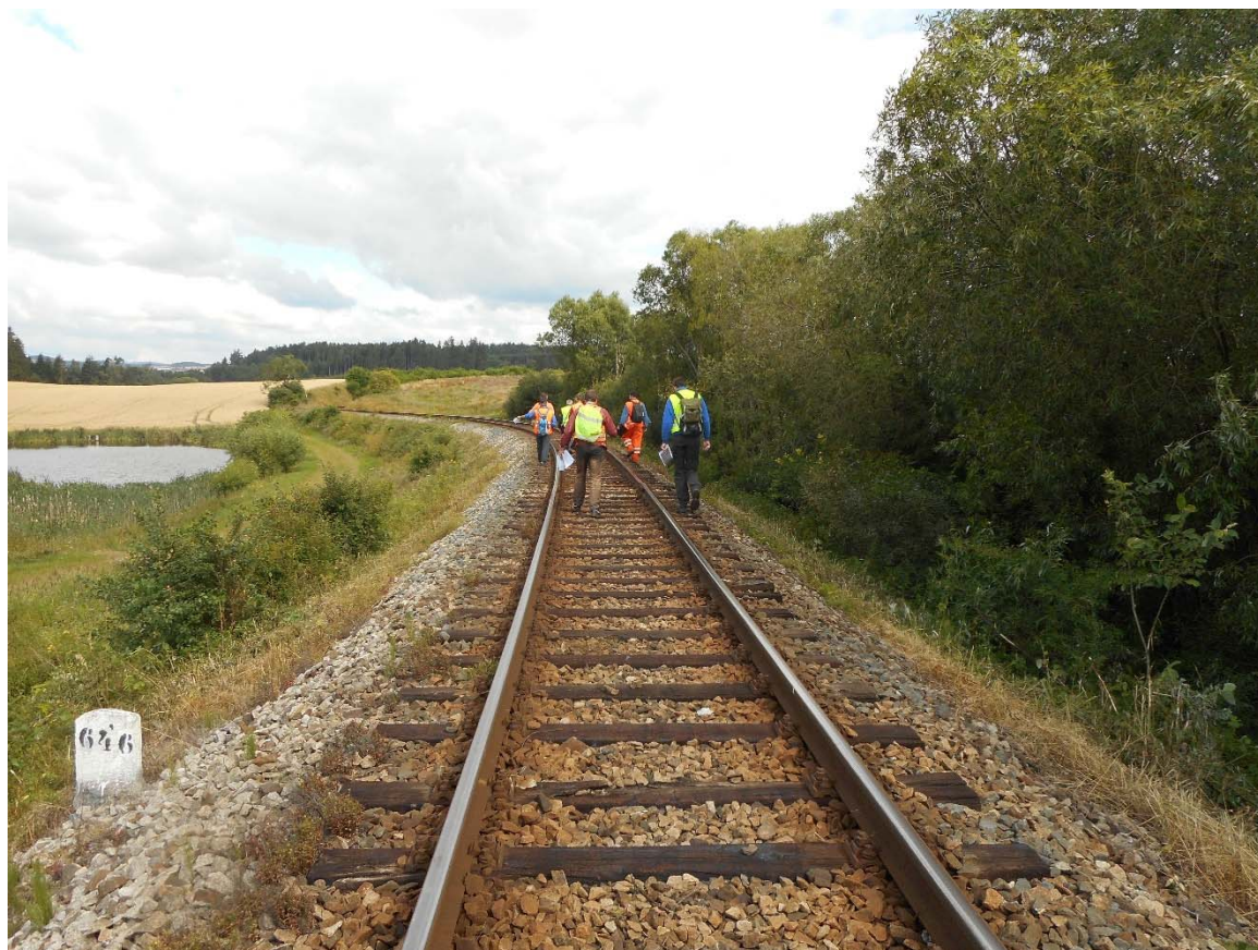
Obr. 4: Šířkově nevyhovující těleso náspu v km 64,650
