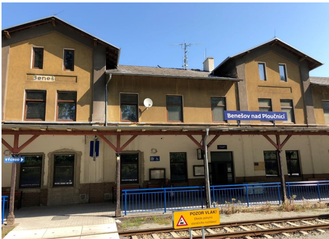
Obrázek 1 Pohled na výpravní budovu z kolejiště
