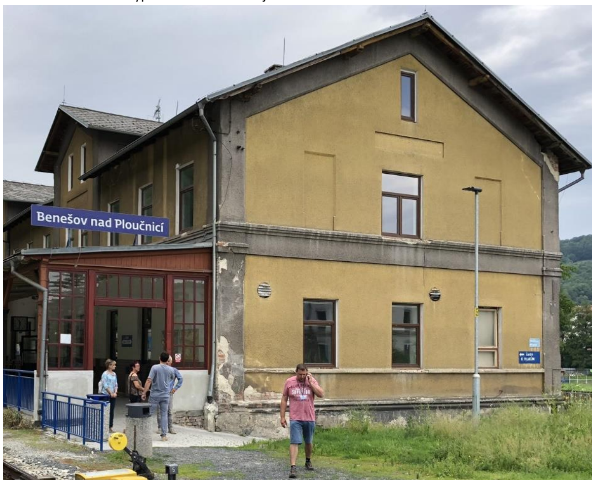
Obrázek 8 Pohled na výpravní budovu z kolejiště
