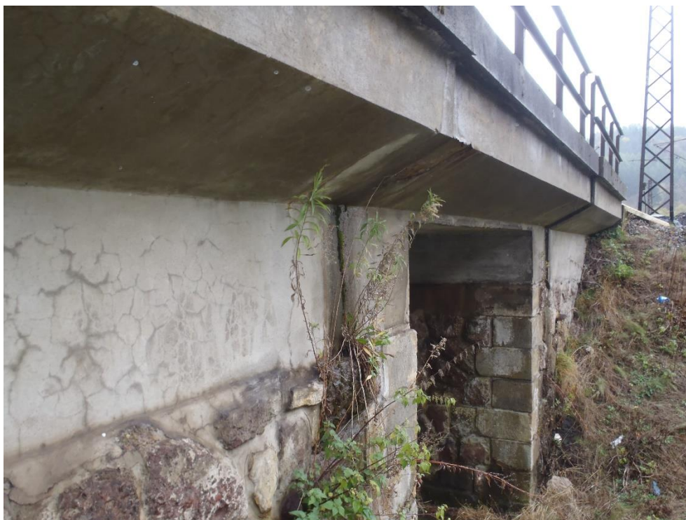
Foto 5: Porušené zdivo, průsaky vody v dilatačních spárách
