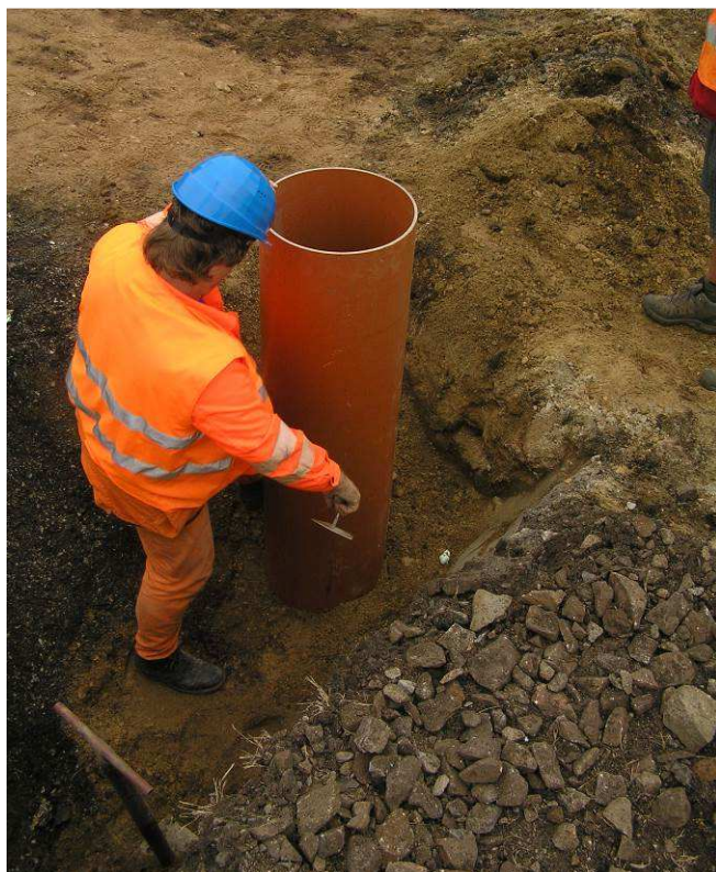
foto. č. 3 – Šachta pro umístění táhla zařízení pro snímání absolutního svislého pohybu kolejnice
