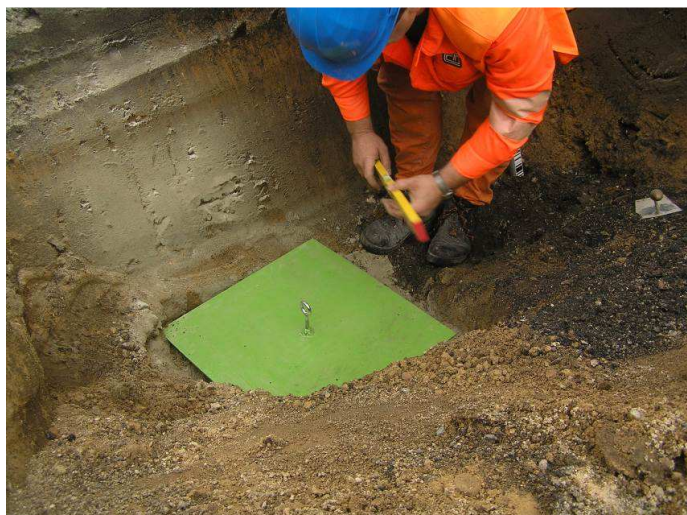
foto. č. 2 – pevná deska s hákem pro připojení táhla zařízení pro snímání absolutního svislého pohybu kolejnice
