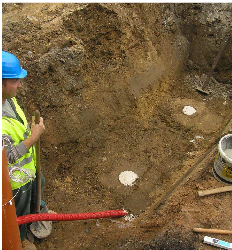
foto. č. 1 - uložení snímačů v tělese železničního spodku, nejnižší úroveň
