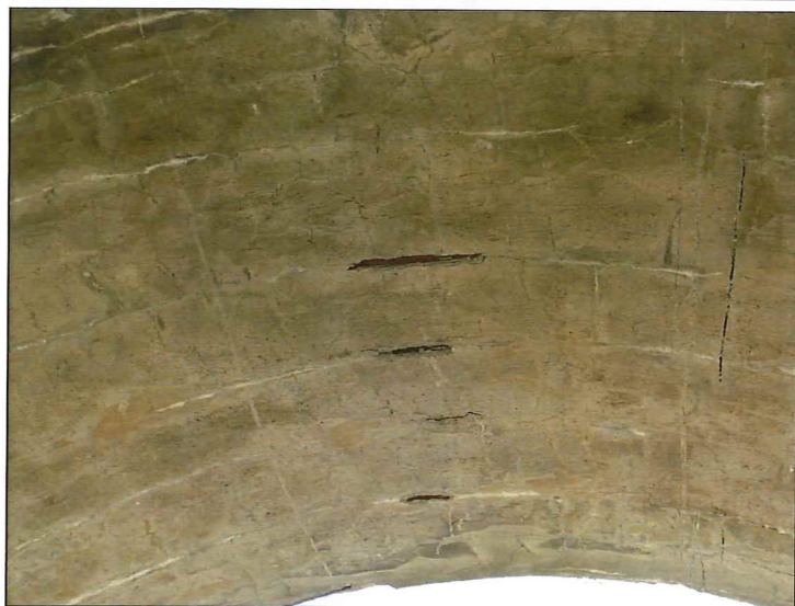
Foto č. 3 - Konstrukce K 02 – podhled vpravo, ve vrcholu obnažená výztuž s korozí
