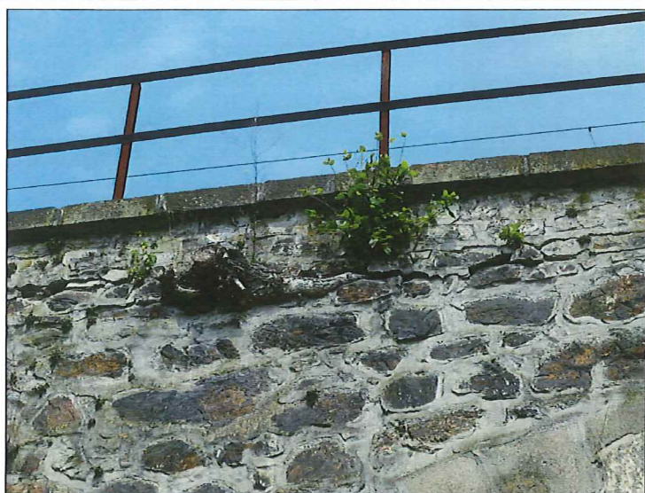
Foto č. 4 – Konstrukce K 02 – čelní zed' vpravo, vodorovná trhлина, zdivo vytlačené
