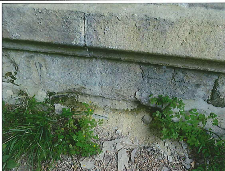
Foto č. 11 – Opěra O 02 – vpravo, vydrolený kameny
