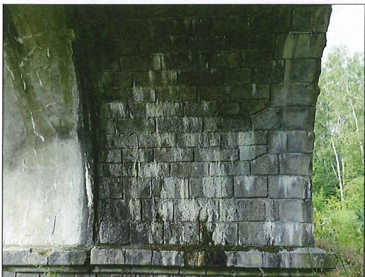
Foto č. 5 – Konstrukce K 03 – podhled vlevo, průsaky s výluhy
