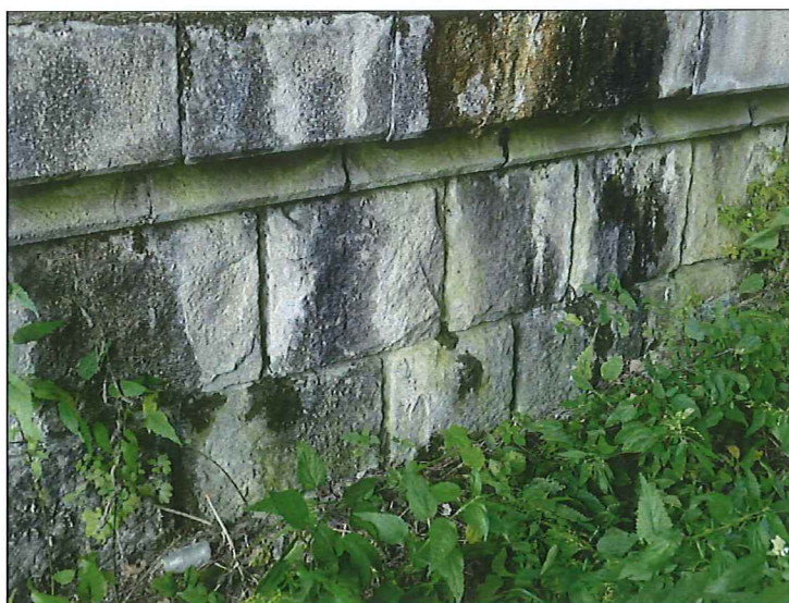
Foto č. 10 – Pilíř P 02 – v otvoru č. 3, vlevo průsaky s výluhy pojiva
