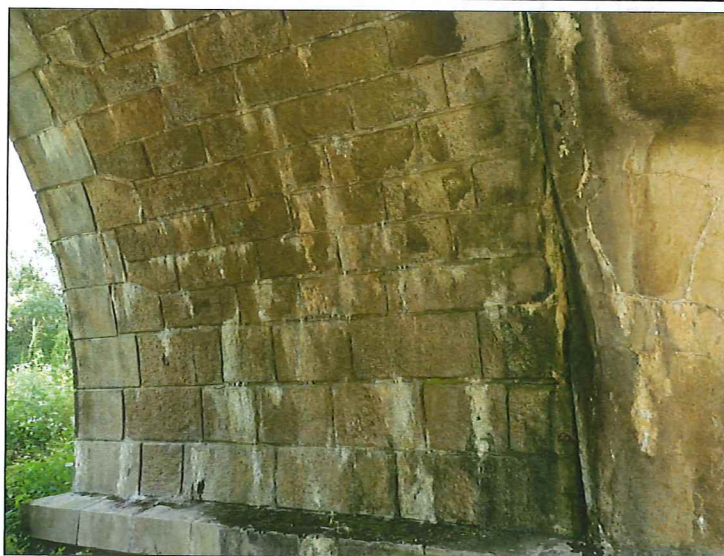
Foto č. 1 – Konstrukce K 01 – podhled vlevo, průsaky s výluhy pojiva
