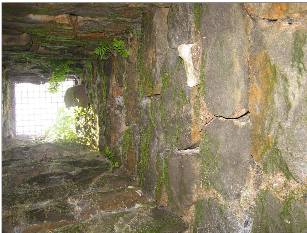
Obr. č. 10 - pohled do šachty u kolejí zdola nahoru. Zdivo stěn je porušené a spáry jsou často do hloubky vypadané.
