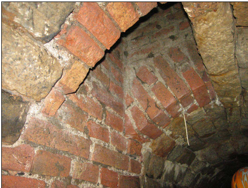
Obr. č. 15 - původní, dnes shora uzavřená šachta v místě přítoku od České Skalice. Šachta malého profilu, její stěny jsou z cihelného zdiva, které je na pohled zachovalé.
