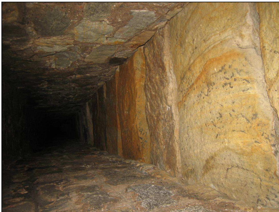
Obr. č. 9 - pohled do přítoku ve směru od HK od výtopy pod šachtou u kolejí. Detailní pohled na kamenné desky NK, které jsou z pevného pískovce.
