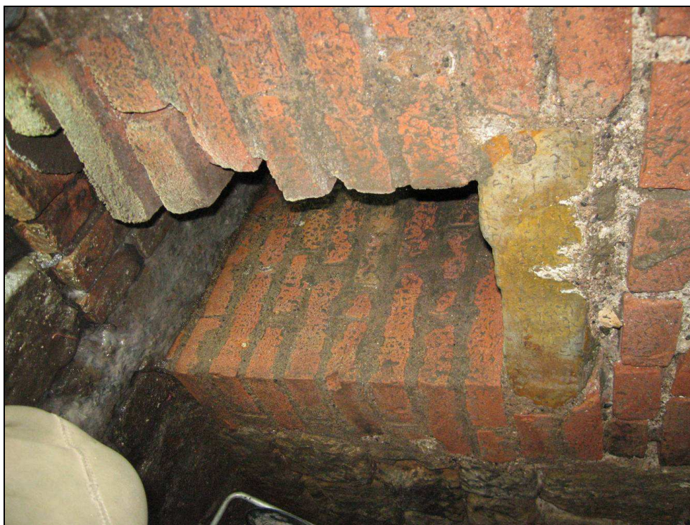
Obr. č. 12 - přítok do propustku ve směru od České Skalice. Štola malého profilu, kde SS je z cihelného zachovalého zdiva z pevných cihel a NK je z kamenných desek pevného pískovce. Spárování a vnitřní malta je na nároží vypadaná.
