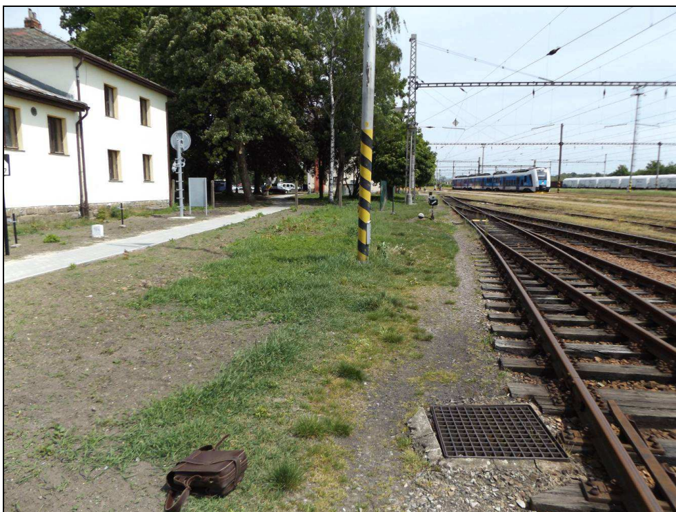
Obr. č. 4 - šachta u levého čela propustku, tzv. šachta u kolejí. Dno propustku je zde 5,10 m pod povrchem mříže poklopu.
