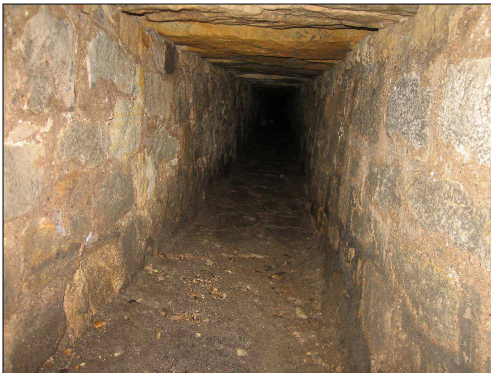
Obr. č. 8 - pohled do přítoku ve směru od HK od výtopy pod šachtou u kolejí. NK je desková.
