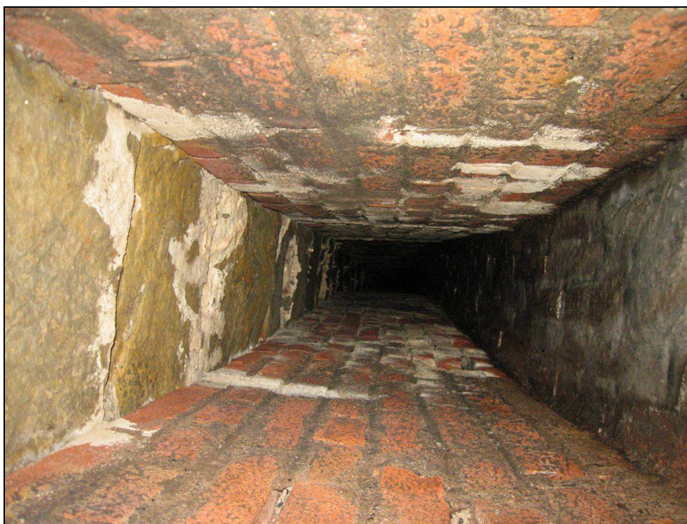
Obr. č. 14 - přítok do propustku ve směru od České Skalice. Pohled na NK, která je z kamenných desek pevného pískovce. Zdivo je mokré.
