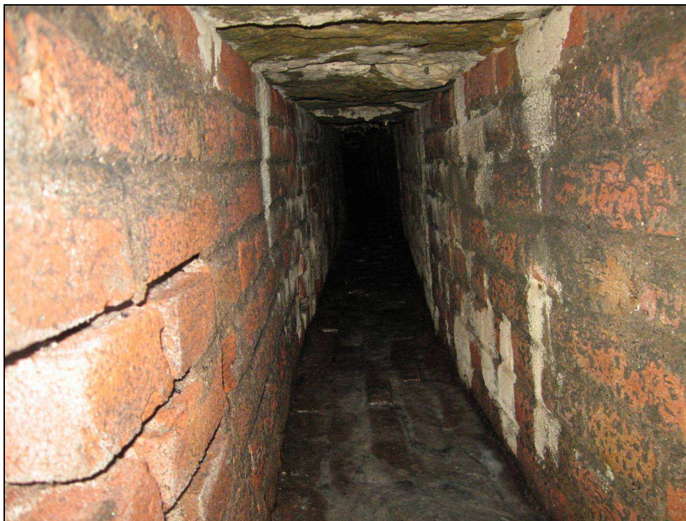
Obr. č. 13 - přítok do propustku ve směru od České Skalice. Pohled do štoly, cihelné zdivo je mokré.
