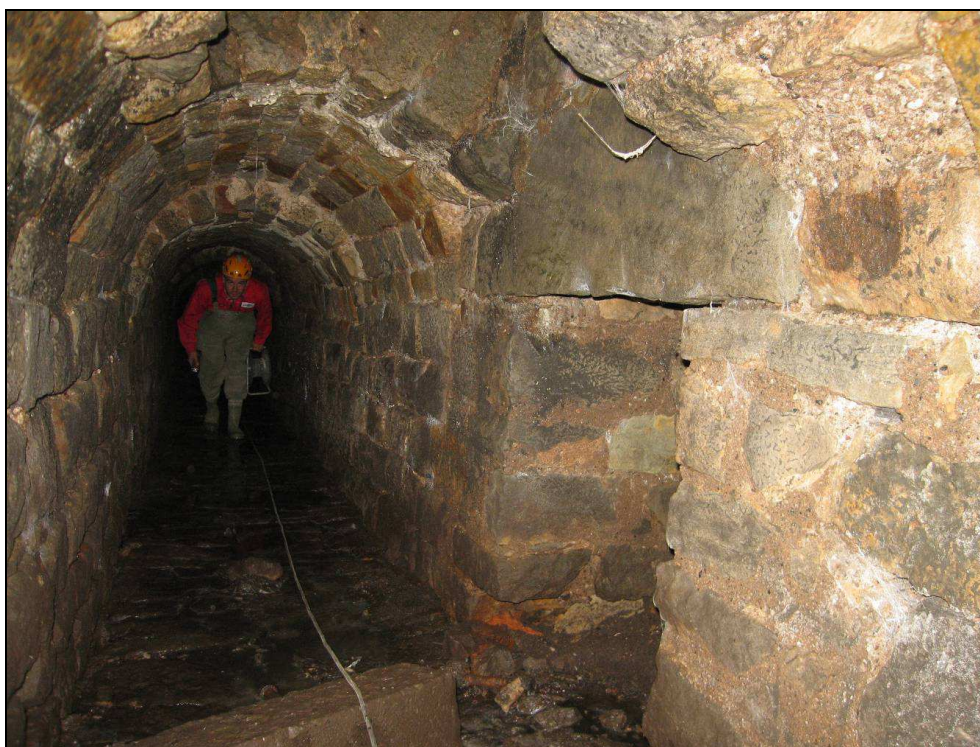
Obr. č. 6 - pohled do propustku. Shora je zaústěna do klenby šachta u kolejí, zprava je zaústěn přítok ve směru od Hradce Králové od výtopny.
