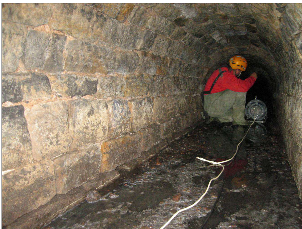
Obr. č. 18 - pohled do propustku - cca 20 m před zazdění pravého čela. Usazeniny na dně jsou zde již mocné a omezují průleznost. Stejný technický stav zdiva jako u levého čela.
