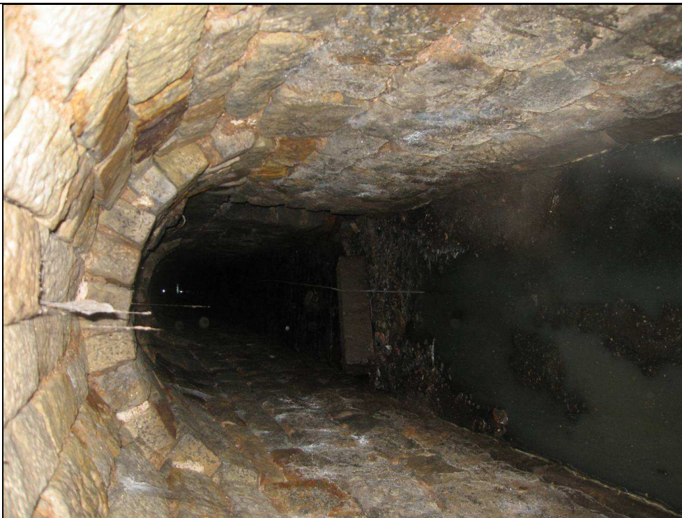
Obr. č. 7 - Pohled do propustku. Nosná konstrukce je klenbová z kamenného zdiva. Spodní stavba je z kamenného zdiva. Kamenné zdivo je zachovalé, kameny jsou pískovce, většinou pevné, avšak proměnlivé pevnosti. Pojivo je silně až zcela degradované, avšak ve spárách dosud drží.
