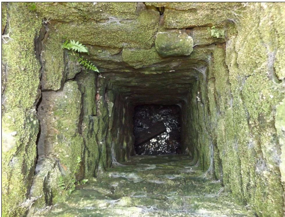
Obr. č. 5 - pohled do šachty u kolejí. Půdorysný rozměr šachty je úzký, cca 67 x 69 cm. Stěny šachty jsou z kamenného zdiva, které je porušené, pojivo je ze spár často vydrolené, kameny nejsou pevně uchycené a vypadávají.
