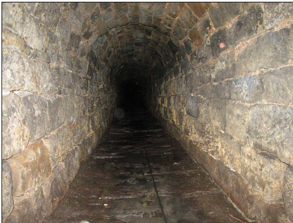
Obr. č. 11 - pohled do propustku směrem k severu v části pod levou skupinou kolejí. Dno je čisté a opevněné kameny, zdivo NK a SS je kamenné, kameny jsou pískovce proměnlivé pevnosti. Spárování je vypadané, vnitřní malta spár je silně degradovaná. Prostředí je silně vlhké až mokré.
