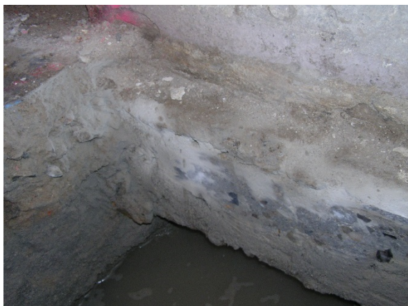
Obrázek 3: Očištěný základový pas s přebroušenými plochami pro zkoušku pevnosti betonu v tlaku
