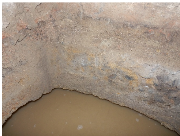
Obrázek 10: Očištěný základový pas včetně pohledu na nesourodý beton základu
