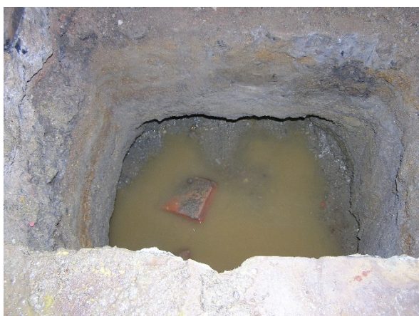
Obrázek 11: Hladina podzemní vody při výkopu sondy
