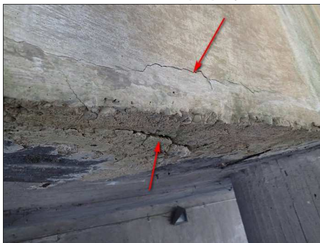
Foto č. 1 - K 01, trhlinka a vzdutý beton u hrany, směrem do 2. otvoru, mezi sloupky č. 2 a 3.
