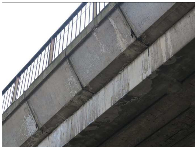
Foto č. 7 – K 05, průsaky mezi římsovými prefabrikáty a levým krajním nosníkem.
