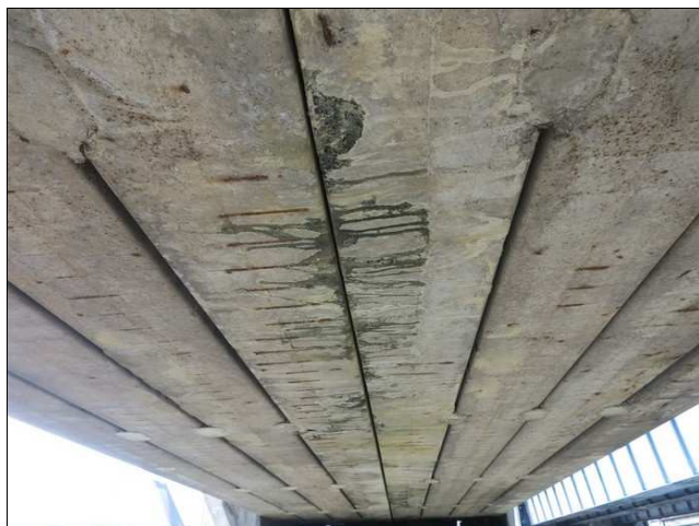
Foto č. 5 – K 03, průsaky z pohledu konstrukce mezi nosníky č. 4 a 5.
