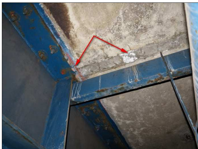
Foto č. 3 – K 03, průsak u levé horní příruby a ve střední části desky, u 2. výztuhy.
