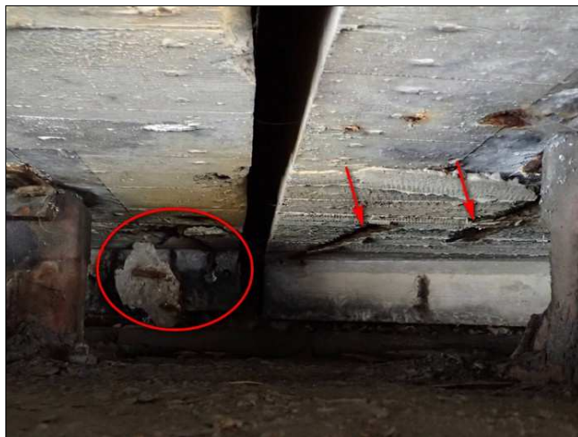
Foto č. 3 - K 02, degradace betonu a slabé krytí nosníků 2 a 3 za ložisky na P 01.
