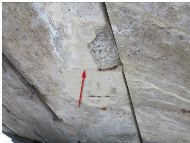
Foto č. 6 – K 03, popraskaná a z části odpadlá betonová plomba nosníku č. 4 nad O 02.
