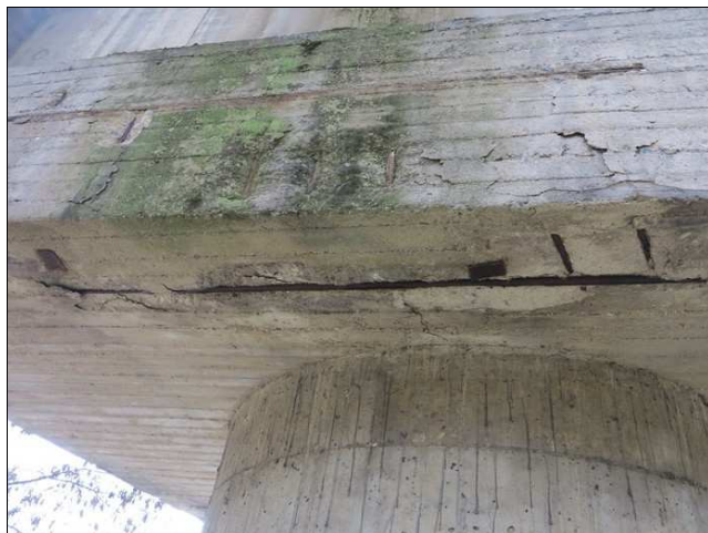
Foto č. 11 – P 02, degradace betonu z podhledu úložného prahu směrem do otvoru č. 3
