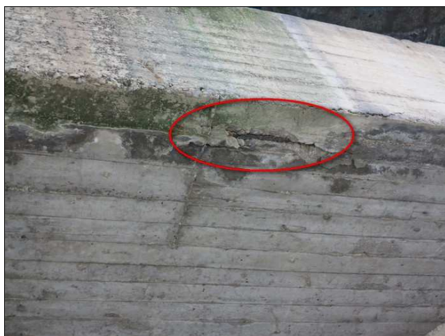
Foto č. 13 – P 02, degradace betonu a nedostatečné krytí výztuže z pohledu úložného prahu.
