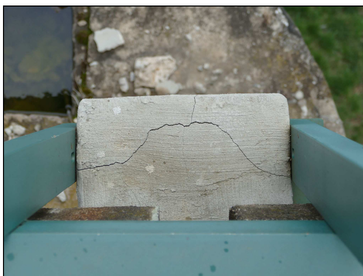
Obr. č. 3 – Konstrukce K 02 – římsová konzola popraskaná
