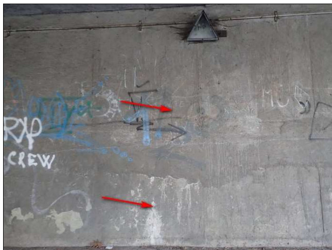
Foto č. 7 - O 01, trhlina ve vzdálenosti 4,50 m zleva.
