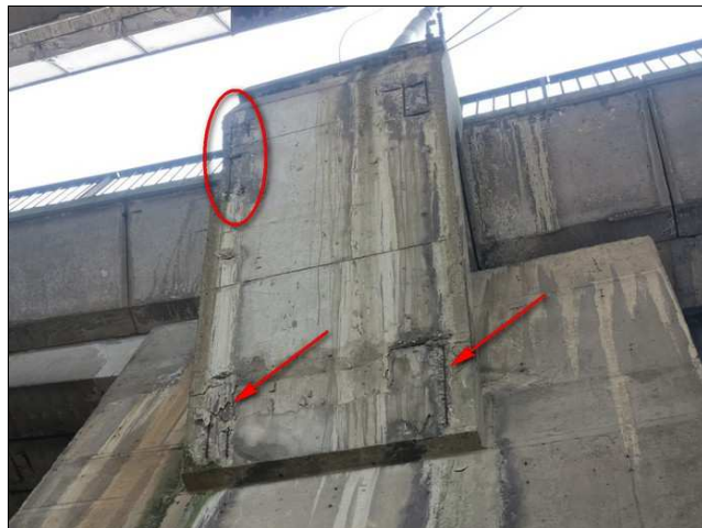
Foto č. 12 – P 01, degradace betonu konzole pro trakční sloup vpravo.
