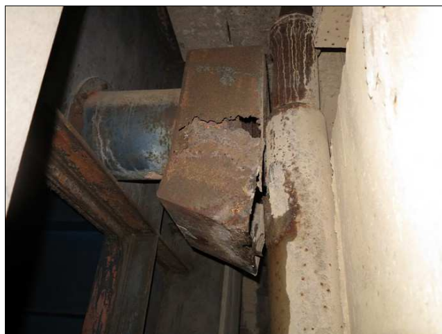
Foto č. 16 – zkorodované odvodnění mezi K 02 a K 03 nad P 01.
