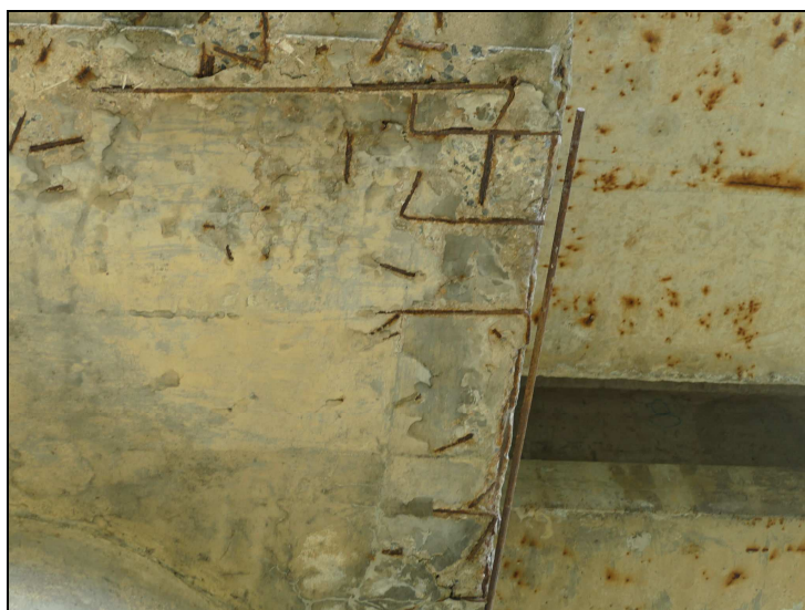
Obr. č. 8 – Píř P 02 – úložný práh – obnažená výztuž s korozí, nespolupůsobení výztuže s betonem
