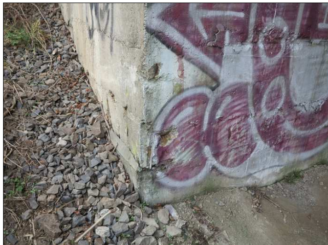
Foto č. 7 – O 01, degradace betonu a nedostatečné krytí výztuže u pravé hrany opěry.
