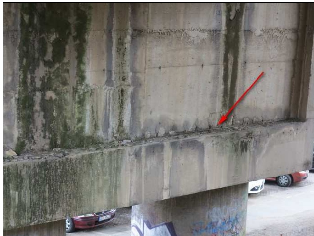
Foto č. 11 – P 01, zvlhnutí závěrné zídky a degradace betonu v dolní části směrem do 1. otv.
