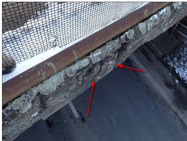
Foto č. 4 - K 02, degradace betonu římsy vlevo a možnost odpadnutí na silnici pod objektem!
