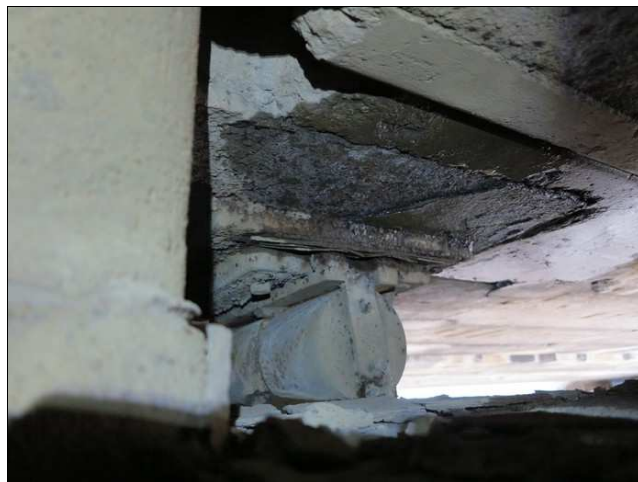
Foto č. 2 – K 01, zavlhnutí nosníku č. 5 nad P 01
