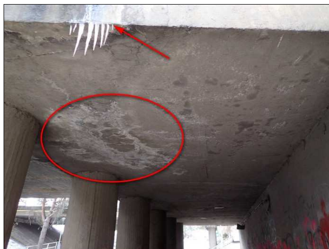
Foto č. 6 - K 03, průsaky z pohledu konstrukce v pravé části a krápníky vzniklé z průsaků v závěru konstrukce vpravo.
