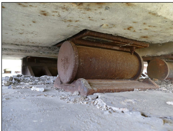
Obr. č. 5 – Konstrukce K 03 – 3. ložisko na pilíři P 02 – chybějící šroub + deformace šroubu
