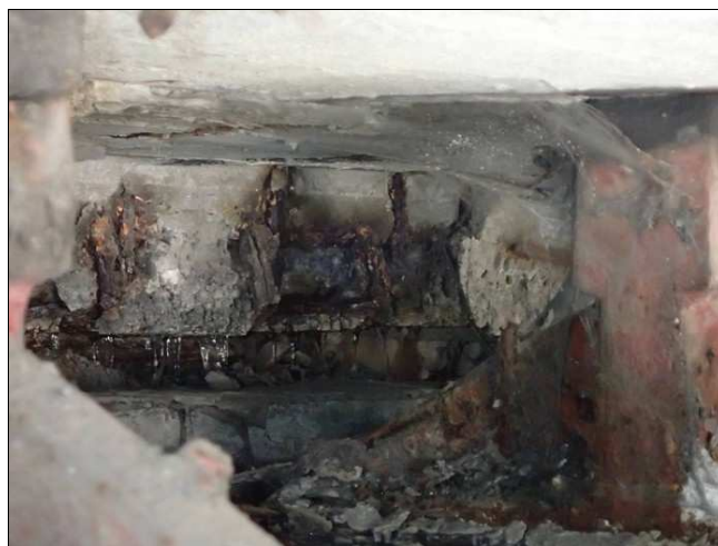
Foto č. 2 - K 01, průsaky v závěru konstrukce mezi K 01 a K 02, směrem do 2. otvoru.
