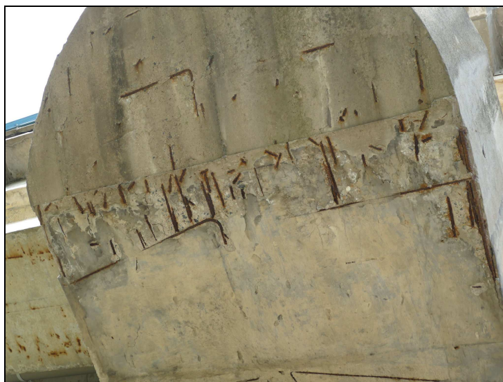
Obr. č. 7 – Píř P 01 – úložný práh – obnažená výztuž s korozí
