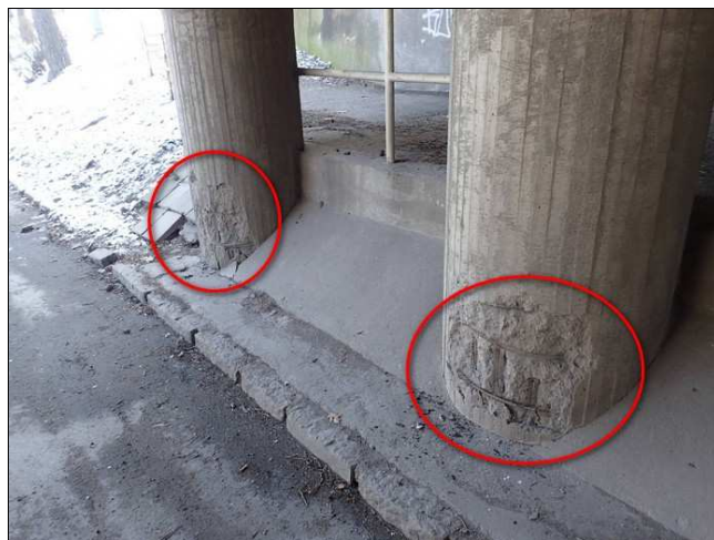
Foto č. 8 - P 01, degradace betonu v dolní části sloupů č. 5 a 6.
