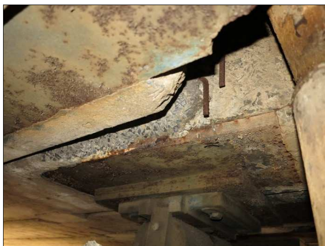
Foto č. 1 – K 01, uražená hrana nosníku č. 4, nad P 01
