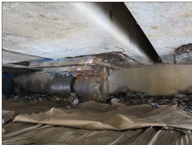
Foto č. 10 – K 05, trhлина a vysunutí části betonu z čela nosníku č. 8 nad P 02.
