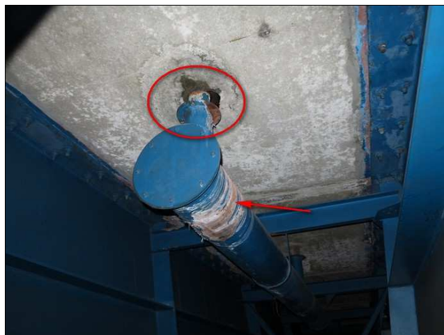
Foto č. 6 – K 04, průsaky okolo odvodnění mezi 8 - 9 výztuhou, koroze svodu odvodnění.
