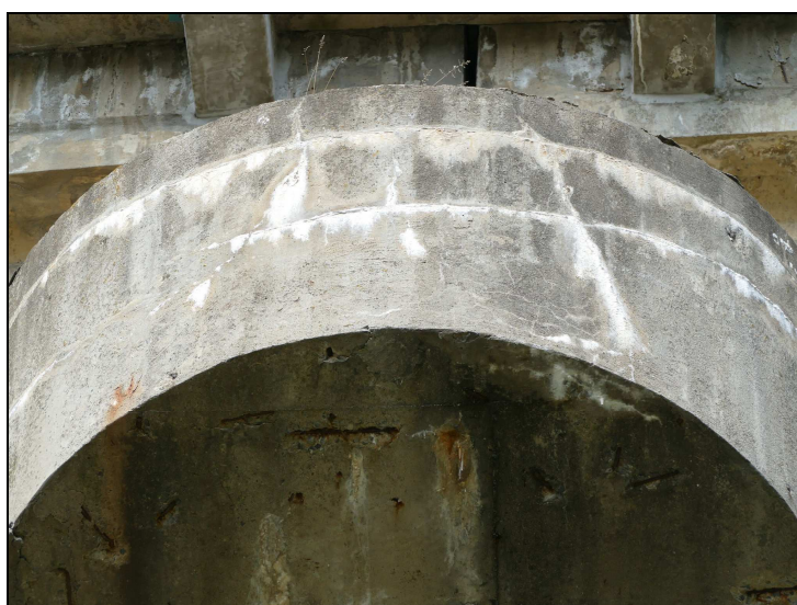
Obr. č. 9 – Píř P 02 – úložný práh – trhliny s průsaky vody a výluhy pojiva
