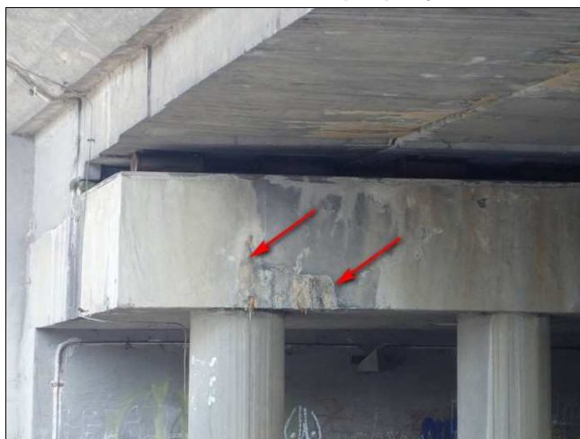
Foto č. 5 - K 03, trhlina a vzdutý beton vlevo z čela směrem do otvoru č. 2.
