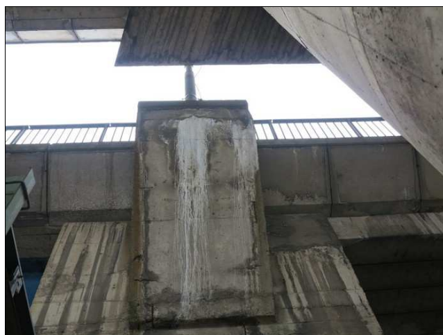
Foto č. 14 – P 02, degradace betonu a silné výluhy konzole pro trakční sloup vpravo.
