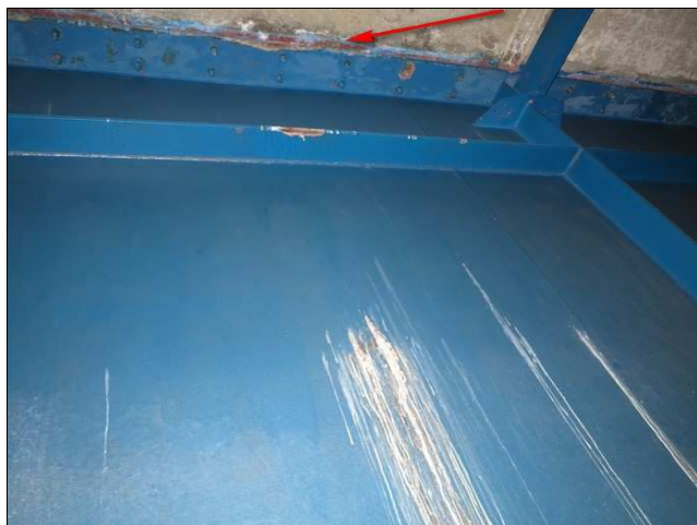
Foto č. 5 – K 04, průsak u levé horní příruby mezi svislými výztuhami č. 7 a 8.
