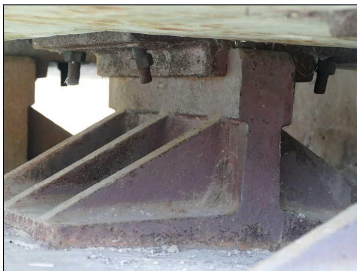
Obr. č. 6 – Konstrukce K 03 – 3. ložisko na opěře O 02 – deformace šroubů
