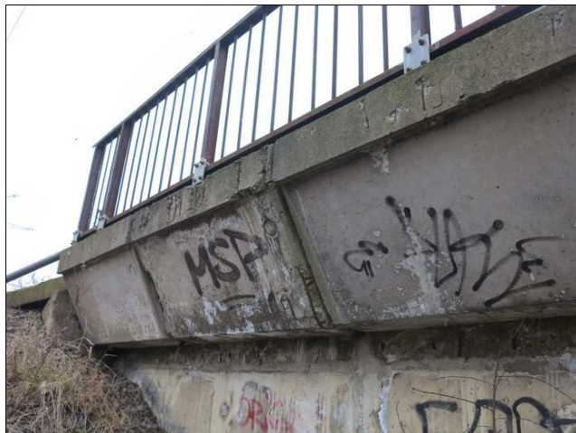
Foto č. 8 – O 01, degradace betonu křídla a římsového prefabrikátu nad křídlem vpravo.
