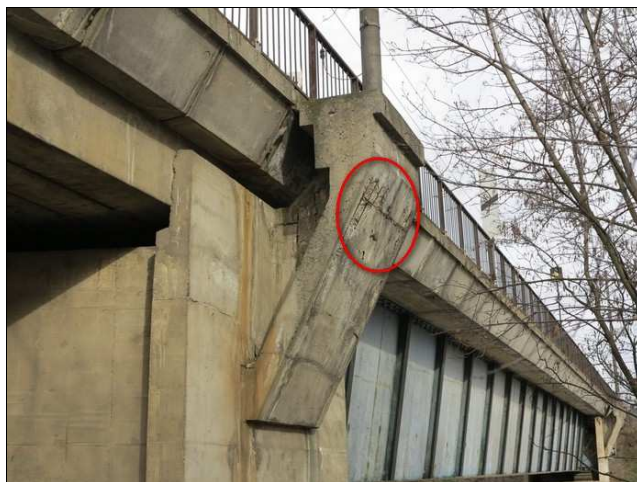
Foto č. 10 – P 01, degradace betonu konzole sloupu trakčního vedení.
