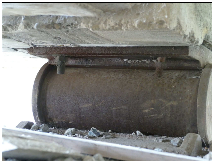
Obr. č. 4 – Konstrukce K 02 – 2. ložisko na pilíři P 01 – deformace šroubu
