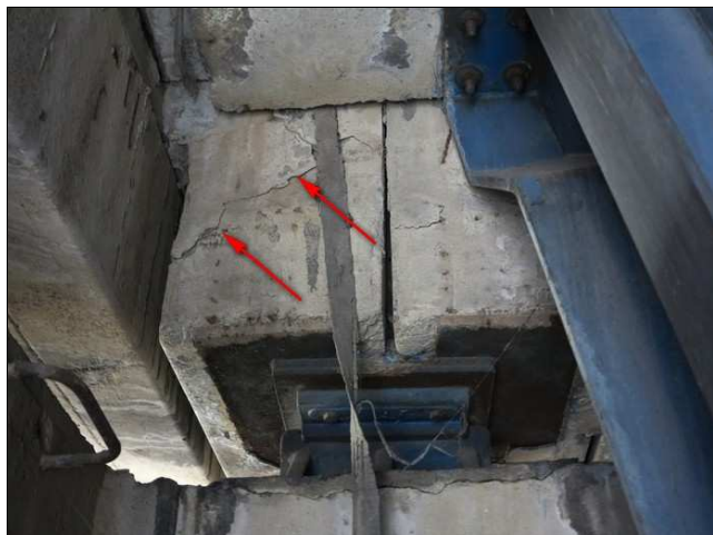
Foto č. 9 – K 05, průsaky mezi římsovými prefabrikáty a levým krajním nosníkem.
