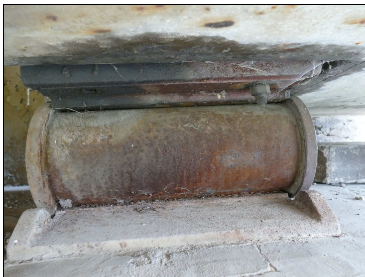
Obr. č. 1 – Konstrukce K 01 – 2. ložisko na opěře O 01 – chybějící šroub
