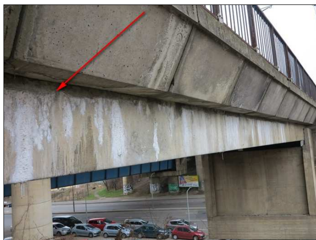
Foto č. 2 – K 01, průsaky v nosníku č. 8 vpravo z líce, nad O 01.
