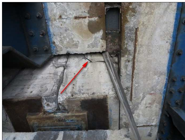
Foto č. 8 – K 05, trhлина a vysunutí části betonu z čela nosníku č. 8 nad P 02.
