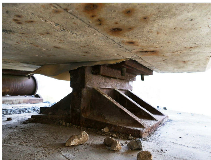
Obr. č. 2 – Konstrukce K 01 – 4. ložisko na pilíři P 01 – chybějící matice šroubů
