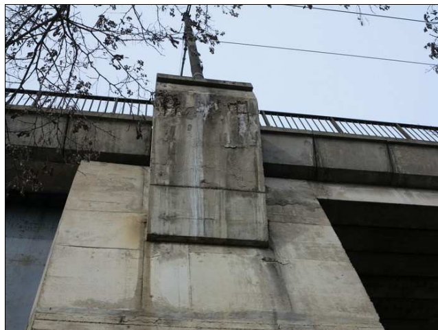
Foto č. 12 – P 02, degradace betonu a průsaky v konzoli sloupu trakčního vedení.
