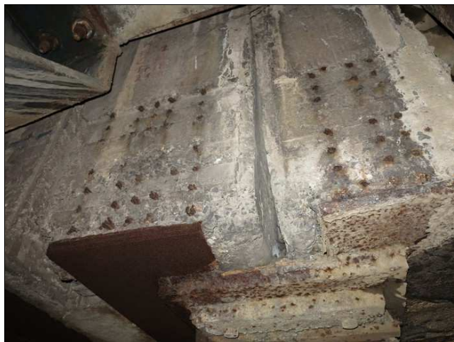
Foto č. 1 – K 01, nedostatečné krytí předpínací výztuže z čel nosníků
