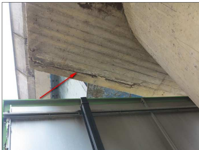
Foto č. 9 – P 01, degradace betonu z podhledu úložného prahu směrem do otvoru č. 2
