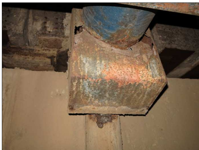
Foto č. 15 – zkorodované odvodnění mezi K 01 a K 03 nad P 01
