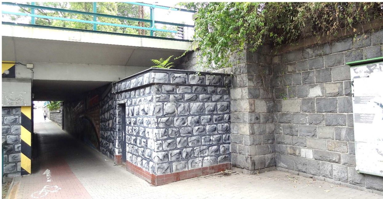
Obr 9. Čerpací stanice s kamennou zárubní zdí v místě budoucí opěry provizorního mostu
