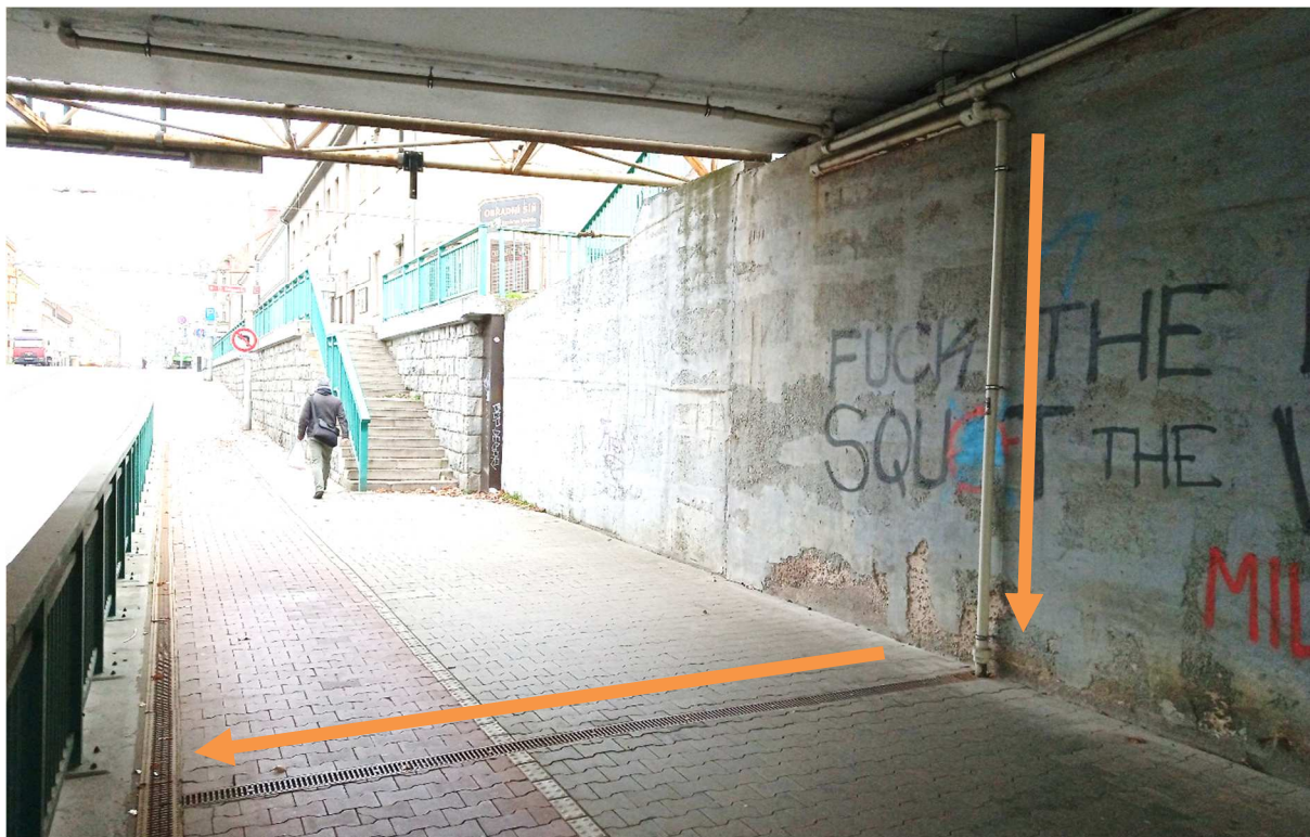
Obr 10. Svod odvodnění na opěře a příčný odvodňovací žlab
