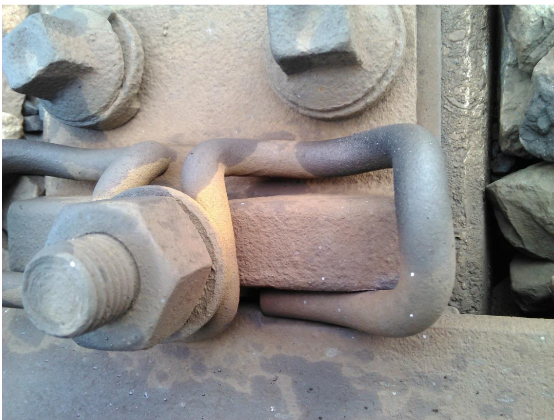
Lovosice – Prackovice, stav a opotřebení upevňovadel
