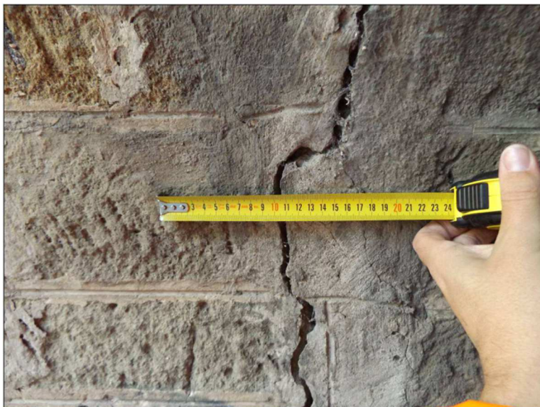
Obr. č. 14 - most v ev. km 91,299, detailní pohled na svislou průběžnou trhlinu cca 1,5 m za levým čelem. Šířka trhliny je cca 2 - 6 mm.
