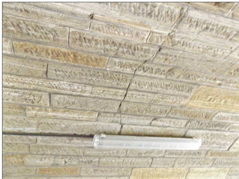
Obr. č. 16 - most v ev. km 91,299, detailní pohled na lícové zdivo NK klenby v polovině délky objektu. Svislá průběžná trhлина v NK klenby rozevírající se směrem do vrchlíku, šířky ve vrchlíku 3 - 4mm.
