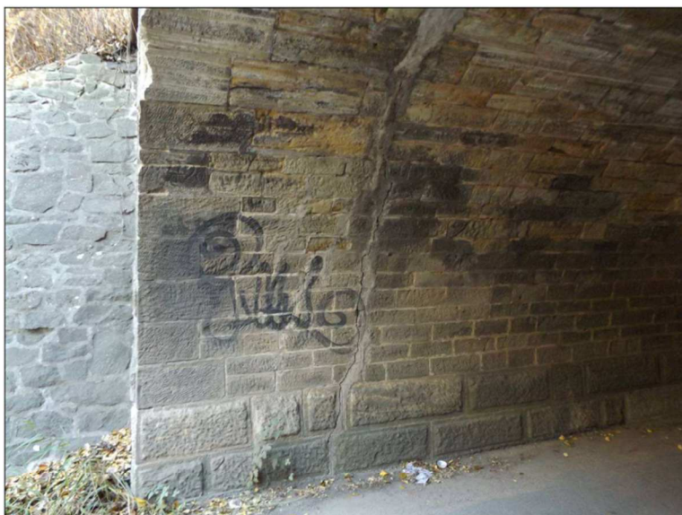
Obr. č. 13 - most v ev. km 91,299, svislá průběžná trhлина cca 1,5 m za levým čelem, která probíhá průběžně přes SS obou opěr a NK klenby. Zde pohled na opěru Hradec. Trhлина byla v minulosti opakovaně sanována maltou, ale je stále aktivní.
