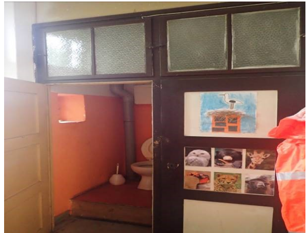
2.NP - sociální zařízení (WC) bytových jednotek
