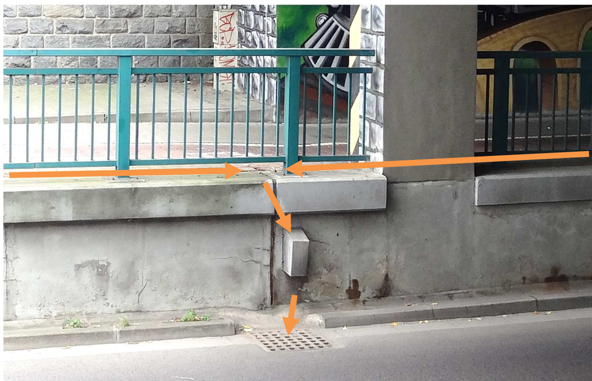
Obr 12. Vyústění odvodnění do uliční vpusti na kraji komunikace
