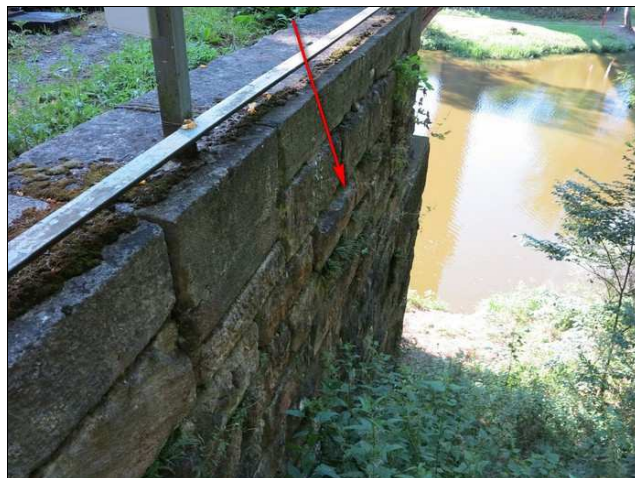
Foto č. 10 – O 01, vysunutí kvádrů křídla vpravo v horní části
