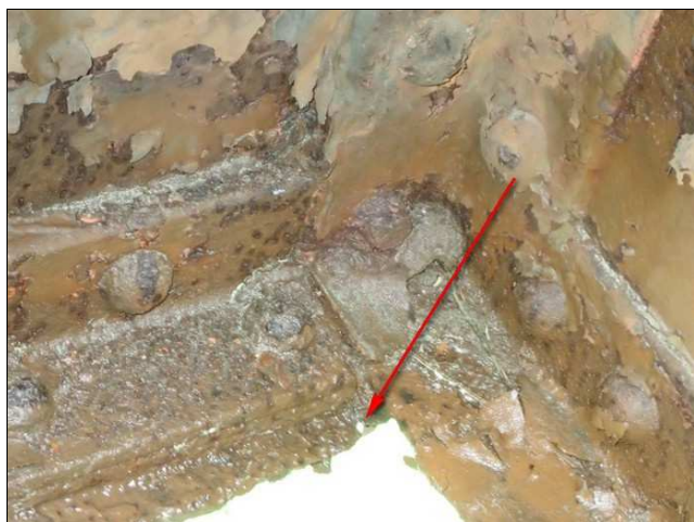
Foto č. 7 – K 01, koroze dolní pásnice příčníku č. 3
