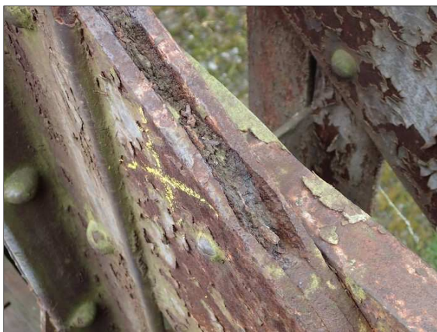
Foto č. 1 – K 01, oslabení diagonál korozí a nárůst štěrbinové koroze.
