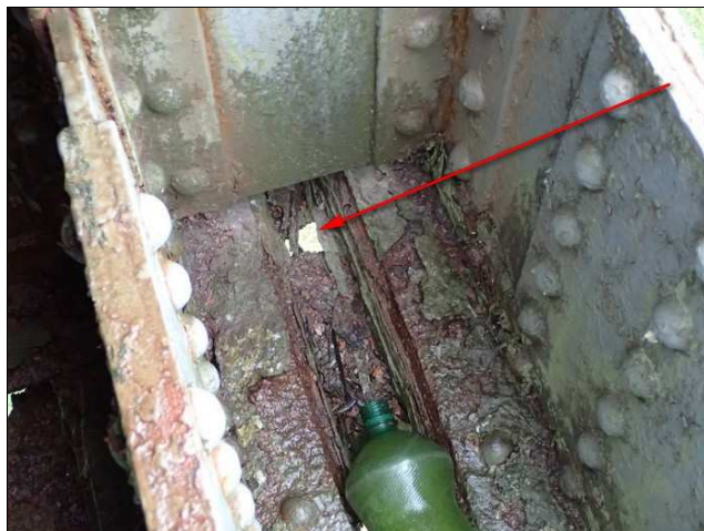
Foto č. 6 – K 01, zkorodovaná přeplátovací deska pravého nosníku pod svislicí č. 6
