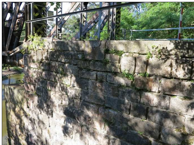
Foto č. 9 – O 01, hloubkově vypadané spárování křídla vlevo
