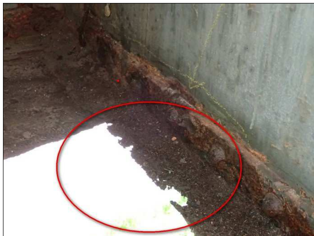
Foto č. 5 – K 01, zkorodovaný dolní pas. úhelník pravého nosníku před 2. svislicí
