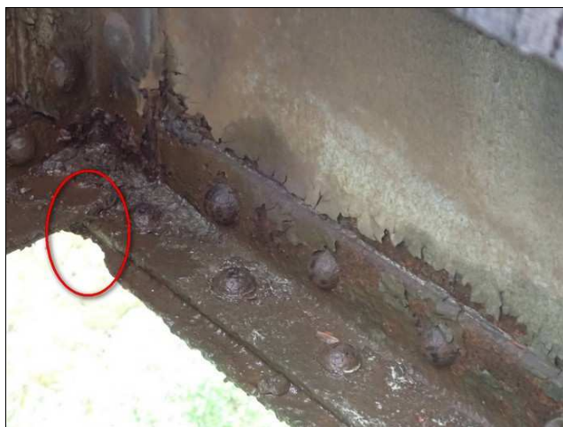
Foto č. 8 – K 01, koroze dolní pásnice příčníku č. 19
