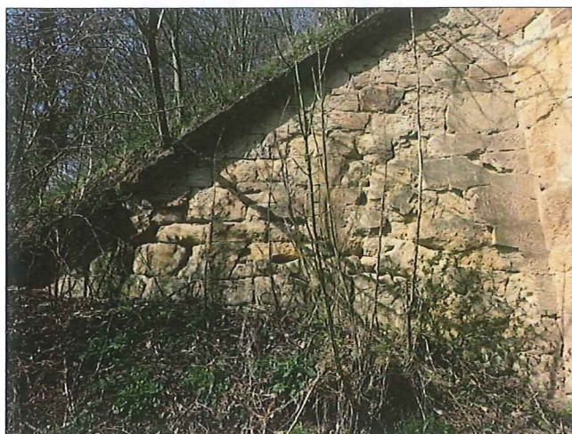
Foto č. 5 - O 02, hloubkově vypadané spárování a hloubková degradace zdí křídla vlevo.
