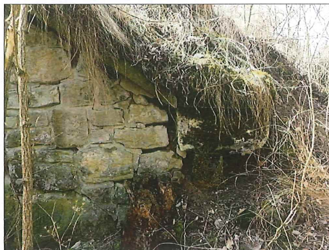
Foto č. 6 - O 02, silně rozvolněný konec křídla vpravo.
