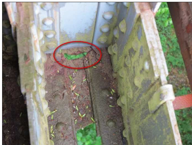
Foto č. 4 – K 01, prokorodovaná přeplátovací deska levého nosníku pod svislicí č. 3
