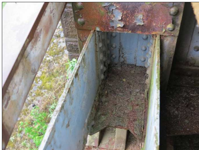
Foto č. 3 – K 01, nárůst plátkové koroze na dolních přeplátovacích deskách
