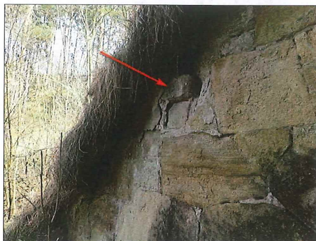
Foto č. 4 - O 01, uvolněné kvádry římsy a křídla vpravo.
