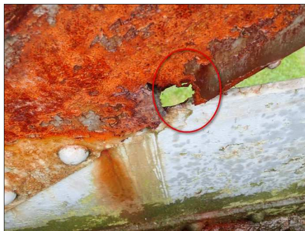
Foto č. 2 – K 01, oslabení korozí diagonály č. 17 vpravo
