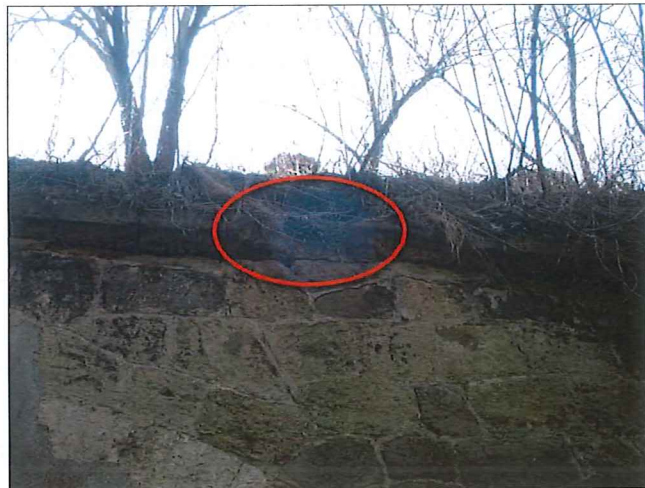
Foto č. 2 - K 01, uražená hrana kvádrů římsy vpravo.
