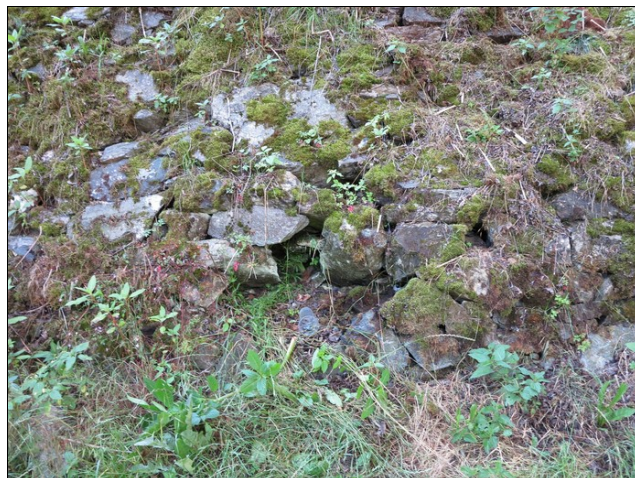
Foto č. 12 – O 02, křídlo vpravo kamenný kužel, kaverna blíž k opěře
