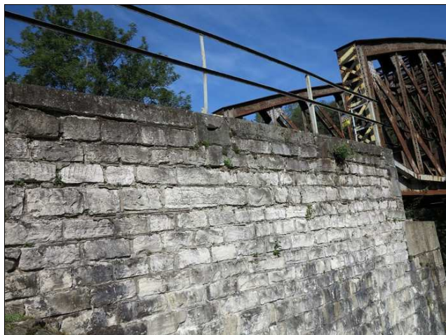
Foto č. 11 – O 02, křídlo vlevo horní část, vypadané spárování s nárůstem vegetace
