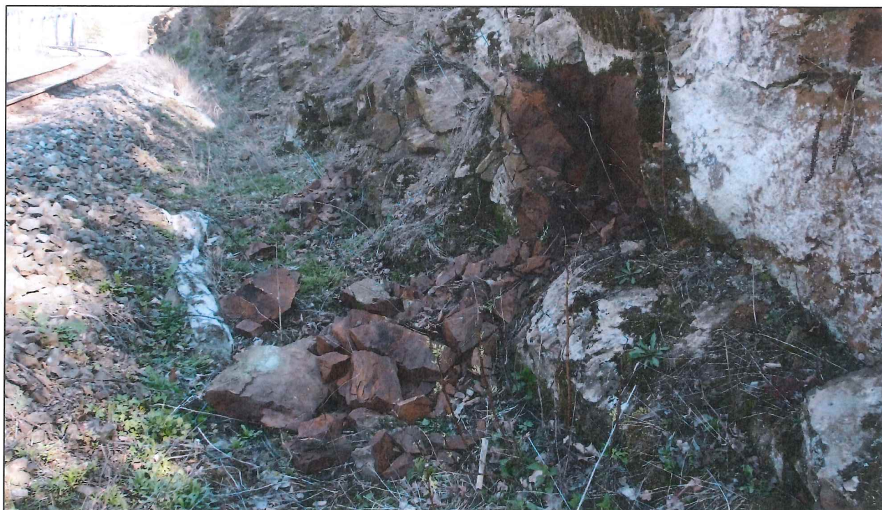
Obr. 6 – zřícené či sesuté hominy v odvodňovacím příkopu při trati
