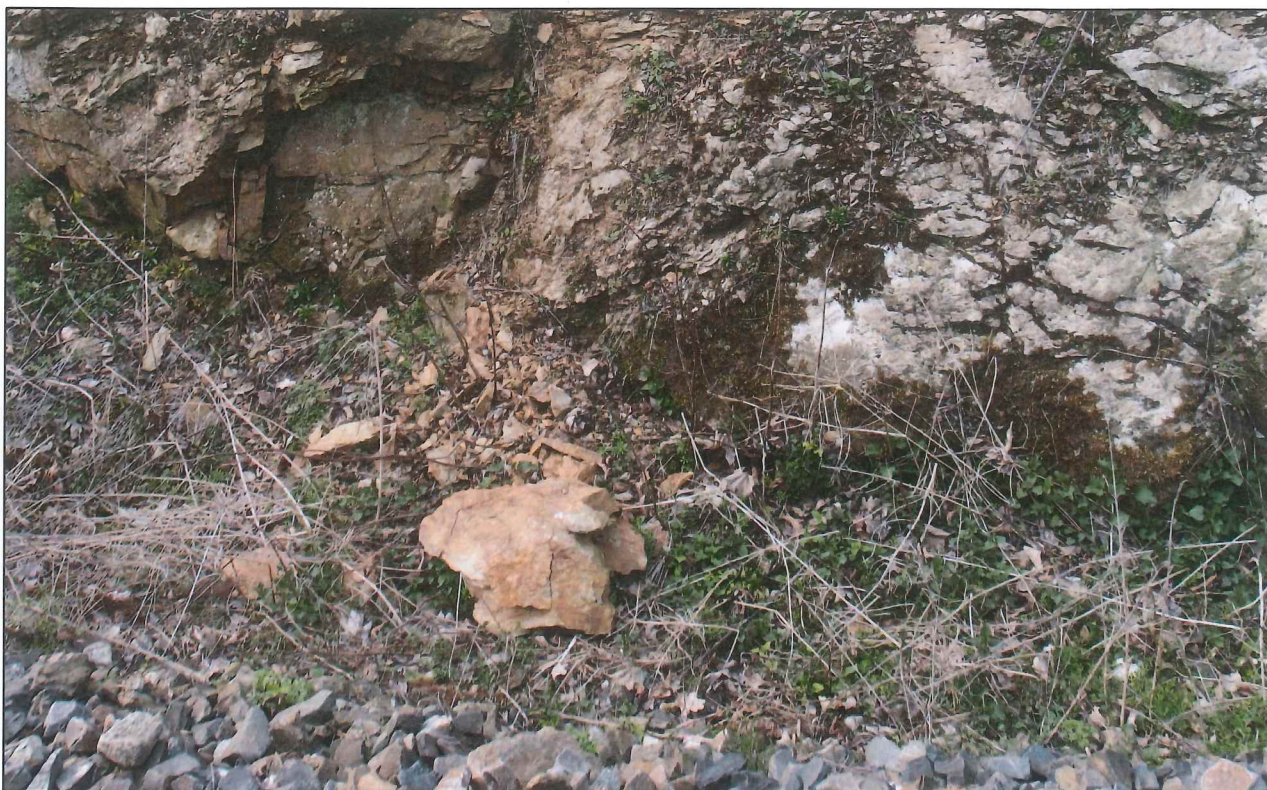
Obr. 7 – uvolněné kameny ze skalní stěny v odvodňovacím příkopu při trati
