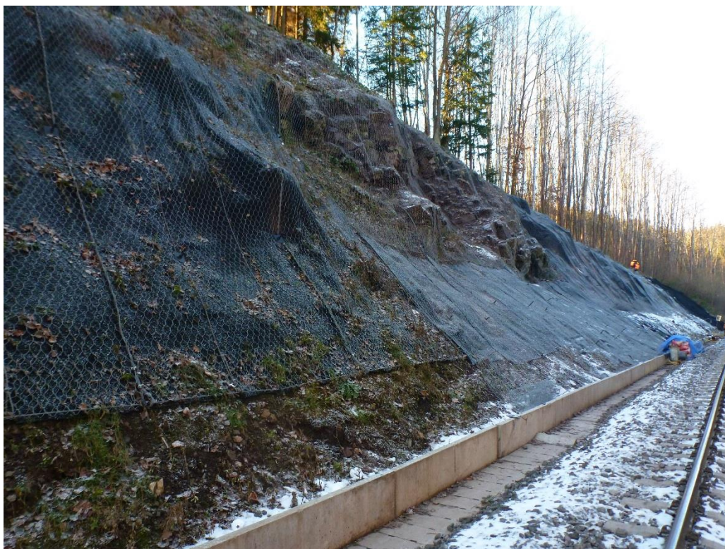
Obr. 2 Příklad trvalého zajištění svahu na stejné trati Pardubice – Liberec v km 97,080 - 97,250
