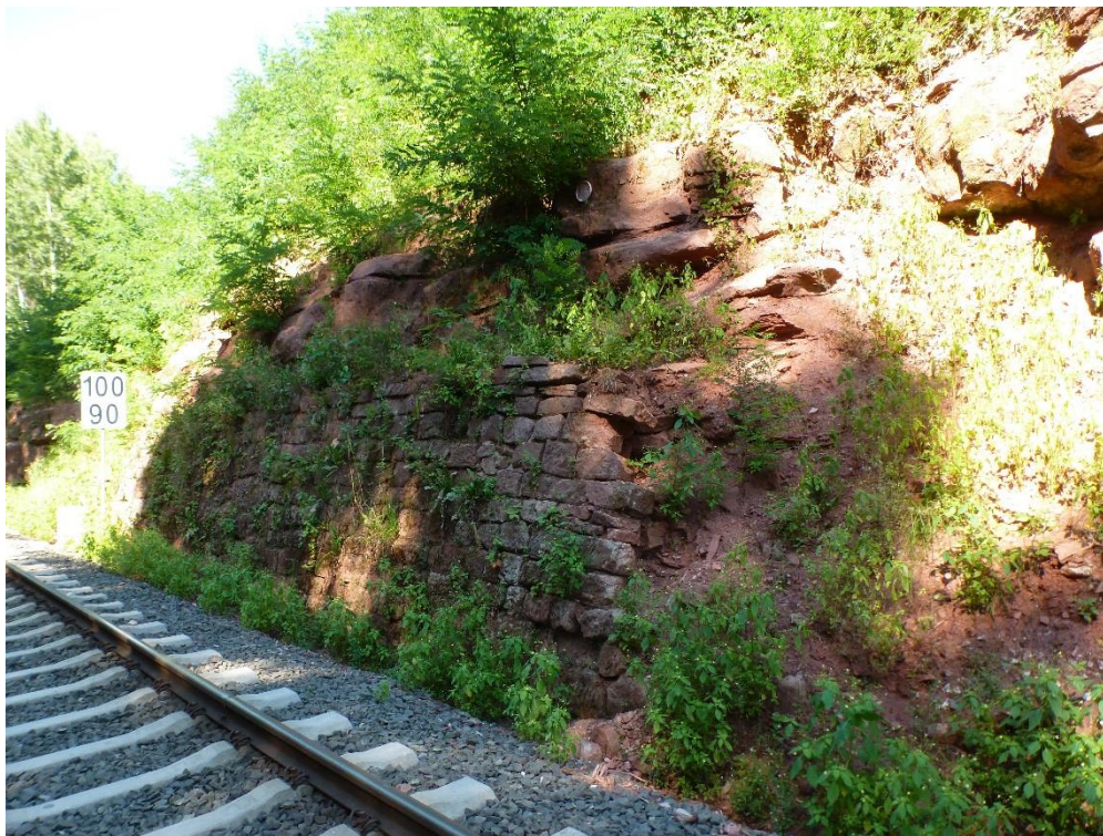
Obr.1 Nestabilní svah a zárubní zeď
