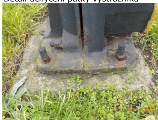
Detail uchycení patky výstražníku
