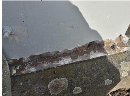
PZS detail spodní části rel. skříňě
