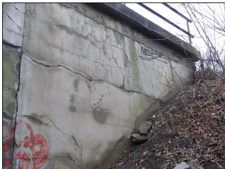
Obr. č. 9 – Opěra O 02 – křídlo vpravo – trhliny v povrchové úpravě s průsaky vody a výluhy pojiva
