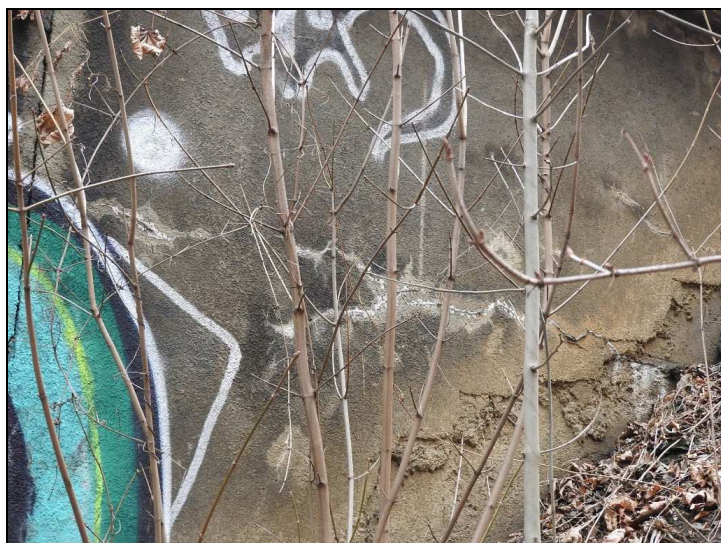
Obr. č. 6 – Opěra O 01 – křídlo vlevo – trhliny v povrchové úpravě s průsaky vody a výluhy pojiva
