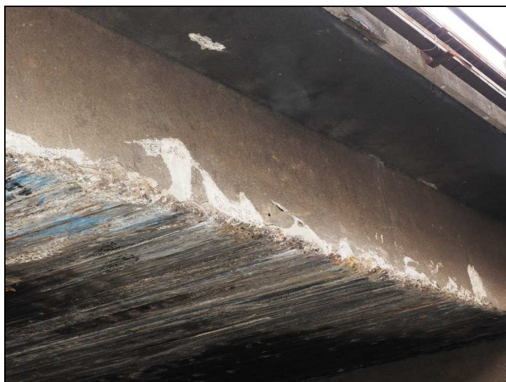
Obr. č. 2 – Konstrukce K 01 – levá dolní hrana – porušení od vozidel
