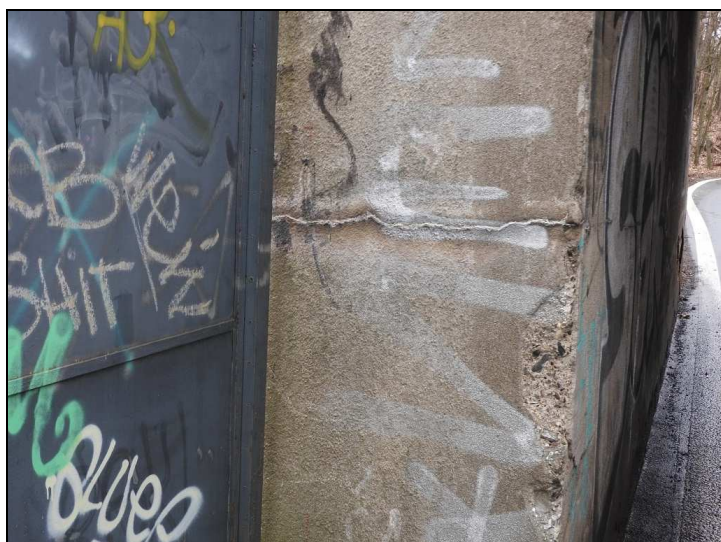
Obr. č. 5 – Opěra O 01 – vpravo – vodorovná trhlina v povrchové úpravě s průsaky vody a výluhy pojiva
