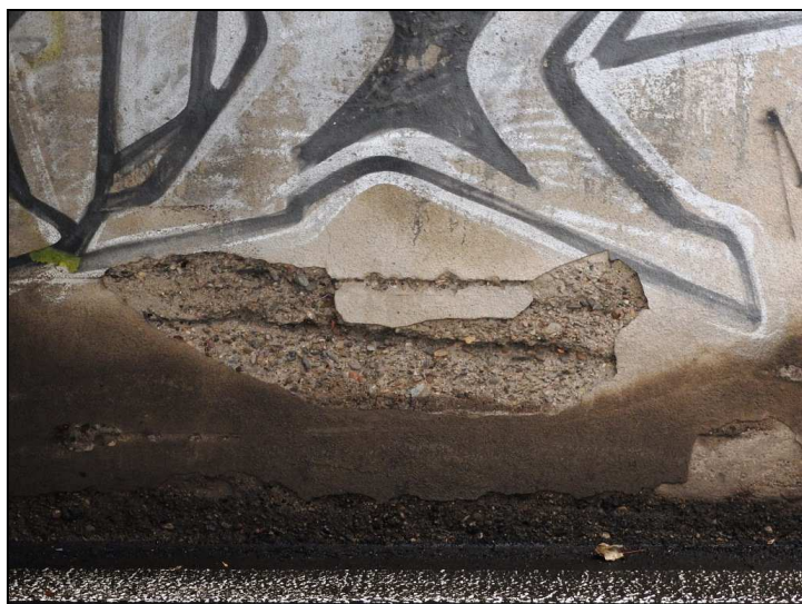
Obr. č. 4 – Opěra O 01 – rýhy od vozidel, odpadá povrchová úprava
