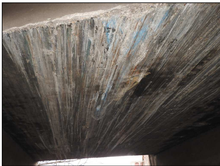
Obr. č. 1 – Konstrukce K 01 – rýhy od vozidel z podhledu
