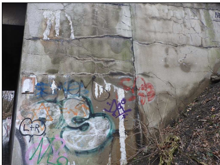
Obr. č. 8 – Opěra O 02 – vpravo z boční strany – trhliny v povrchové úpravě s průsaky vody a výluhy pojiva
