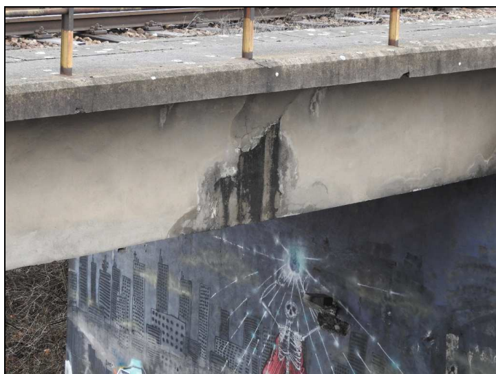
Obr. č. 5 – Konstrukce K 02 – vlevo z boční strany – popraskaná povrchová úprava s průsaky vody a výluhy pojiva
