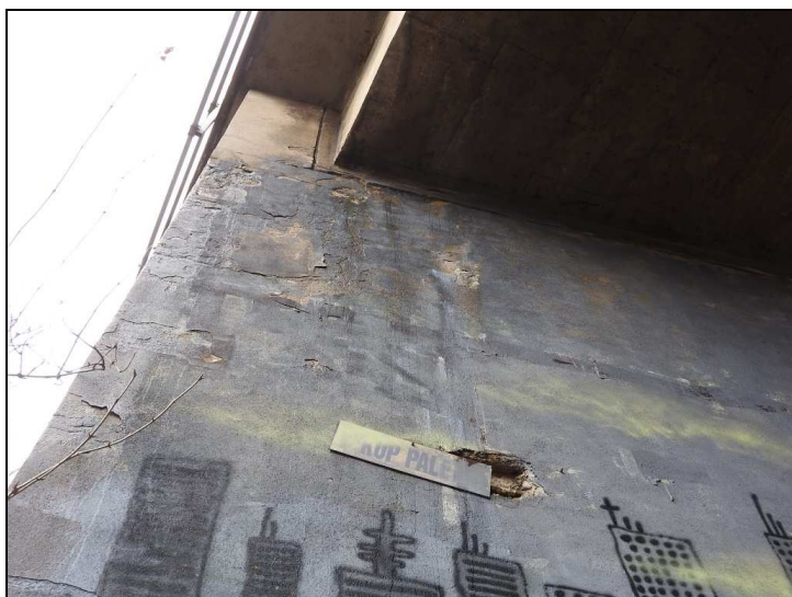
Obr. č. 10 – Opěra O 02 – vpravo – průsaky vody, degradace povrchové úpravy
