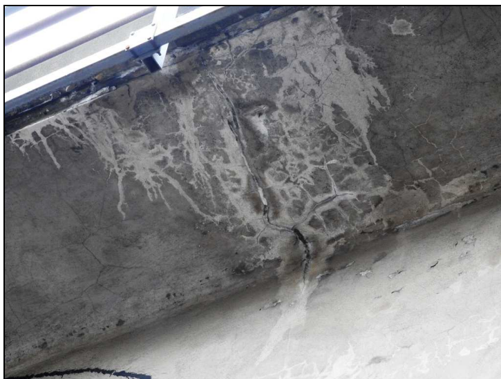
Obr. č. 3 – Konstrukce K 01 – římsa vlevo – trhlina z podhledu s průsaky vody a výluhy pojiva
