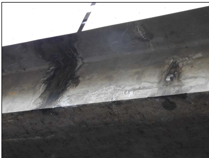
Obr. č. 6 – Konstrukce K 02 – vpravo z boční strany – popraskaná povrchová úprava s průsaky vody a výluhy pojiva
