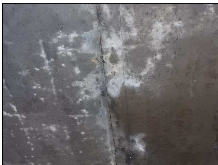
Obr. č. 1 – Konstrukce K 01 – průsaky vody s výluhy pojiva z podélné dilatační spáry
