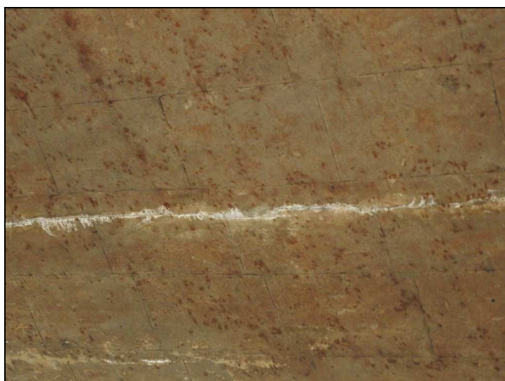
Obr. č. 4 – Konstrukce K 02 – podélná trhлина s průsaky vody a výluhy pojiva
