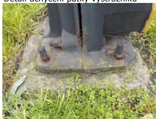
Detail uchycení patky výstražníku
