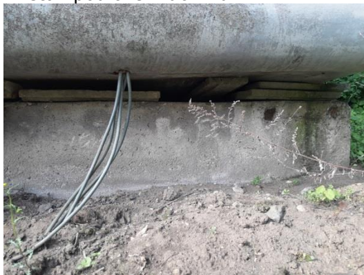
Detail podložení domku
