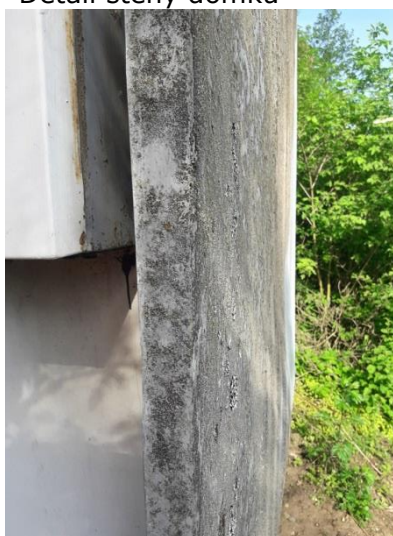
Detail stěny domku
