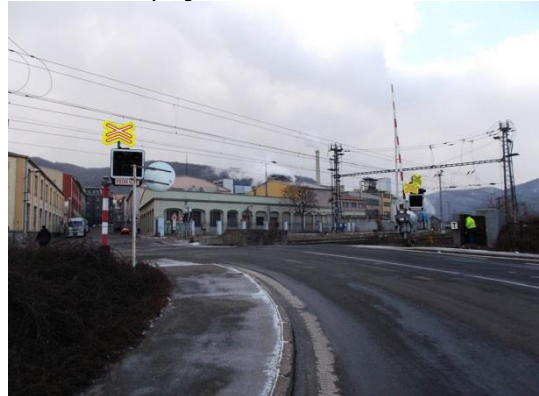
PZS směr příjezd od hlavní komunikace
