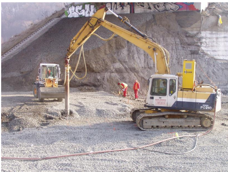
Provádění vibrovaných štěrkových pilířů pod mostním objektem
