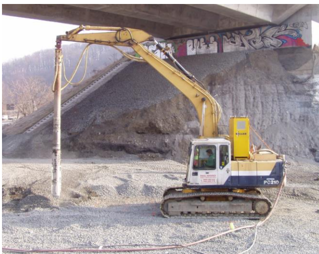
Zřizování vibrovaných šterkových pilířů
