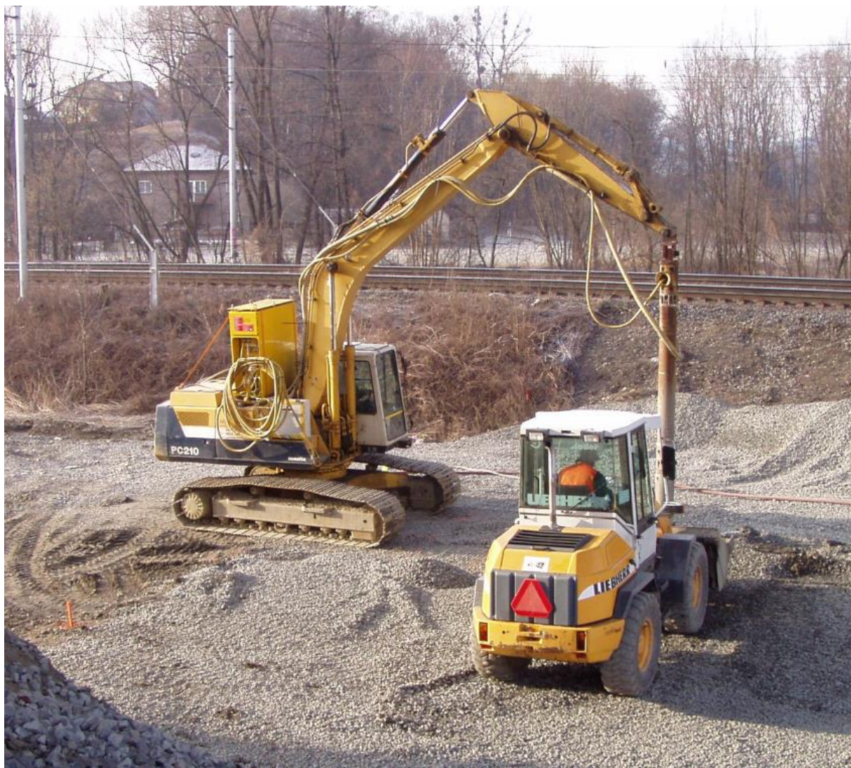
Strojní sestava pro provedení vibrovaných štěrkových pilířů
