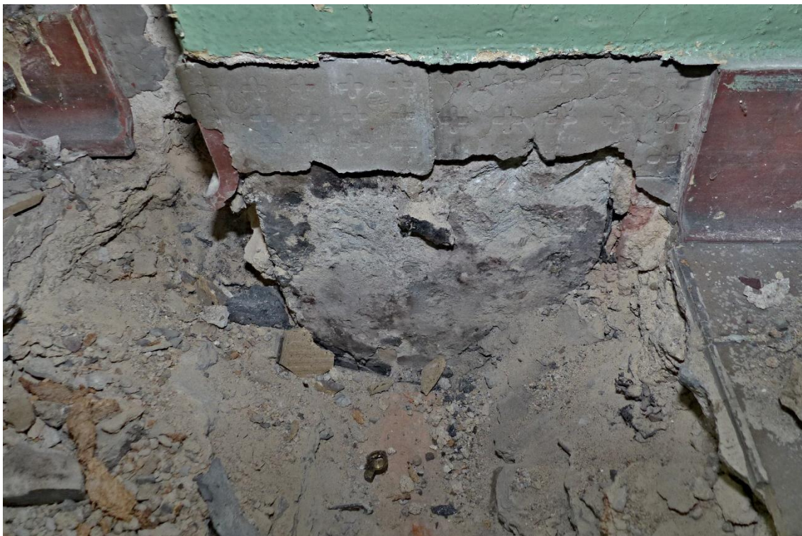
Foto č. 49 – Detailní pohled na hydroizolaci na nosném žlb sloupu u sondy P2
