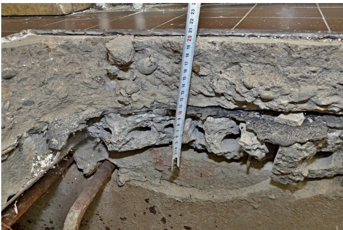
Foto č. 88 – Pohled na řez podlahou u sondy P5 v místnosti OP24 – vstupní vestibul v bloku B
