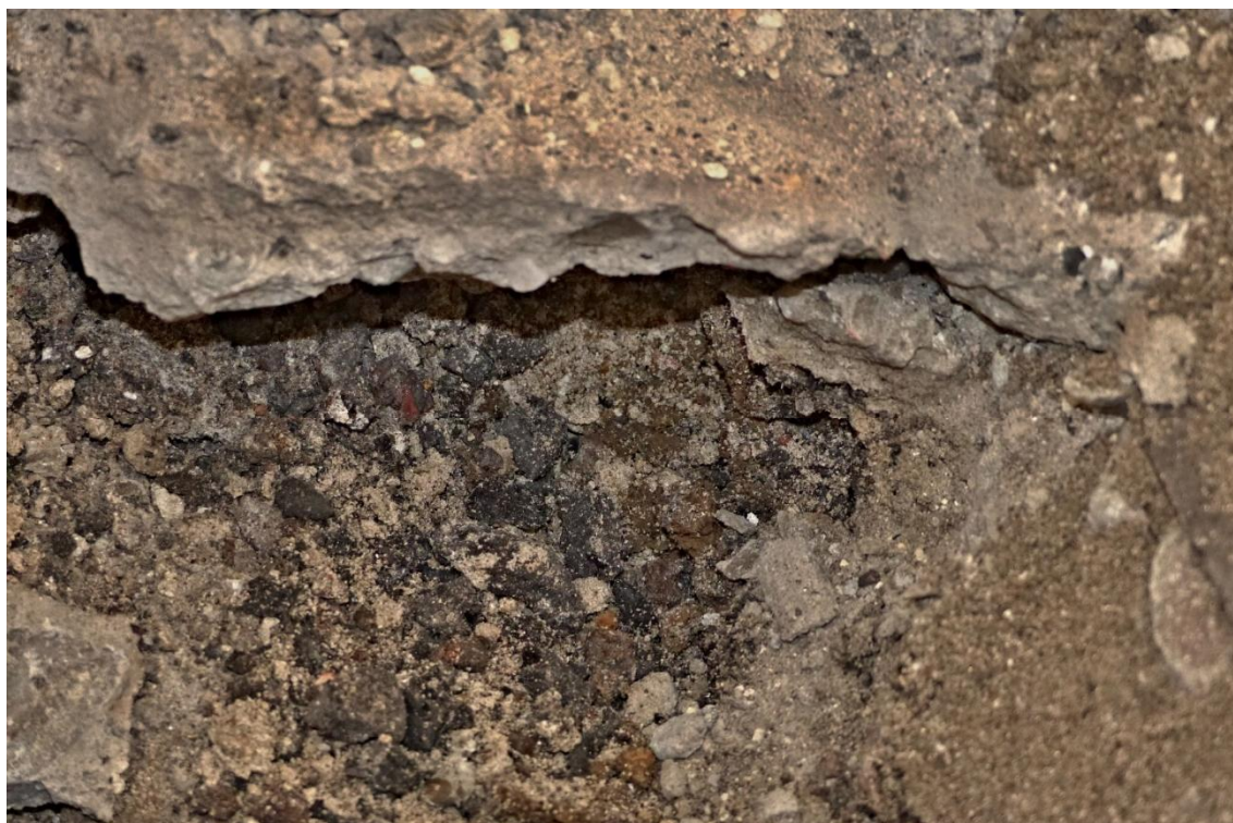
Foto č. 44 – Detailní pohled na kopanou sondu do podlahy P1 – příčka nemá základ
