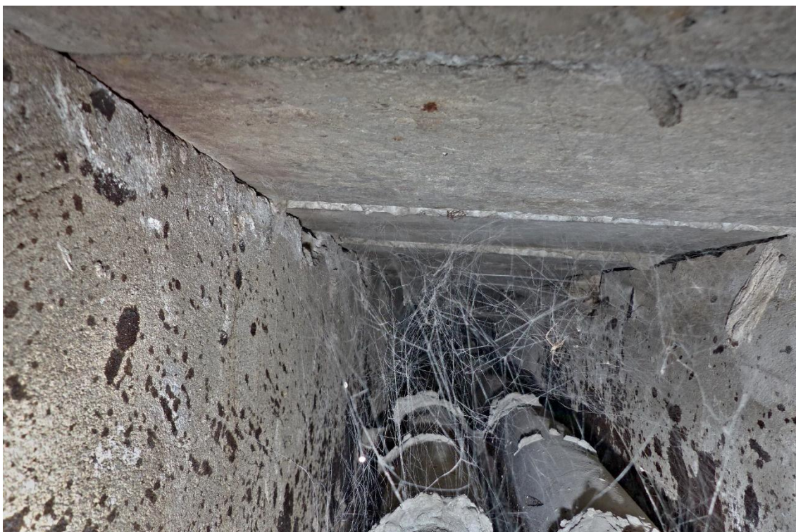
Foto č. 53 – Pohled do kanálu s vytápěním u sondy P2
