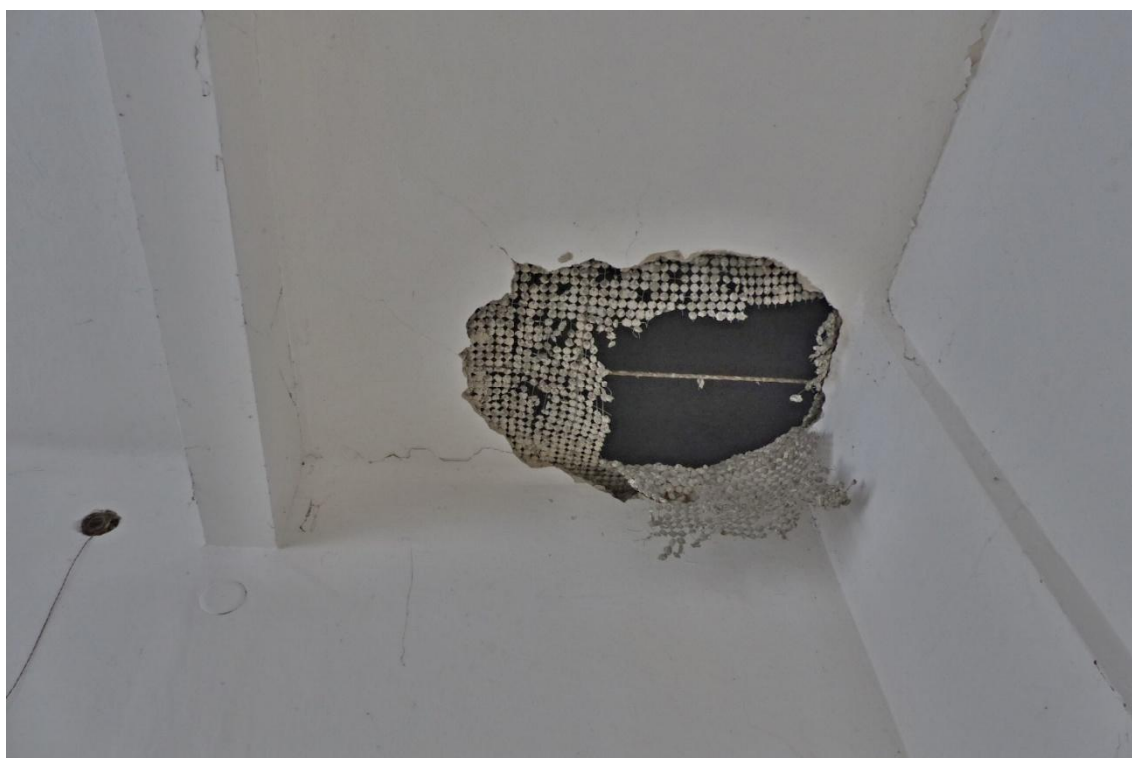
Foto č. 93 – Pohled na sondu do podhledu S4 v místnosti č. OP44
