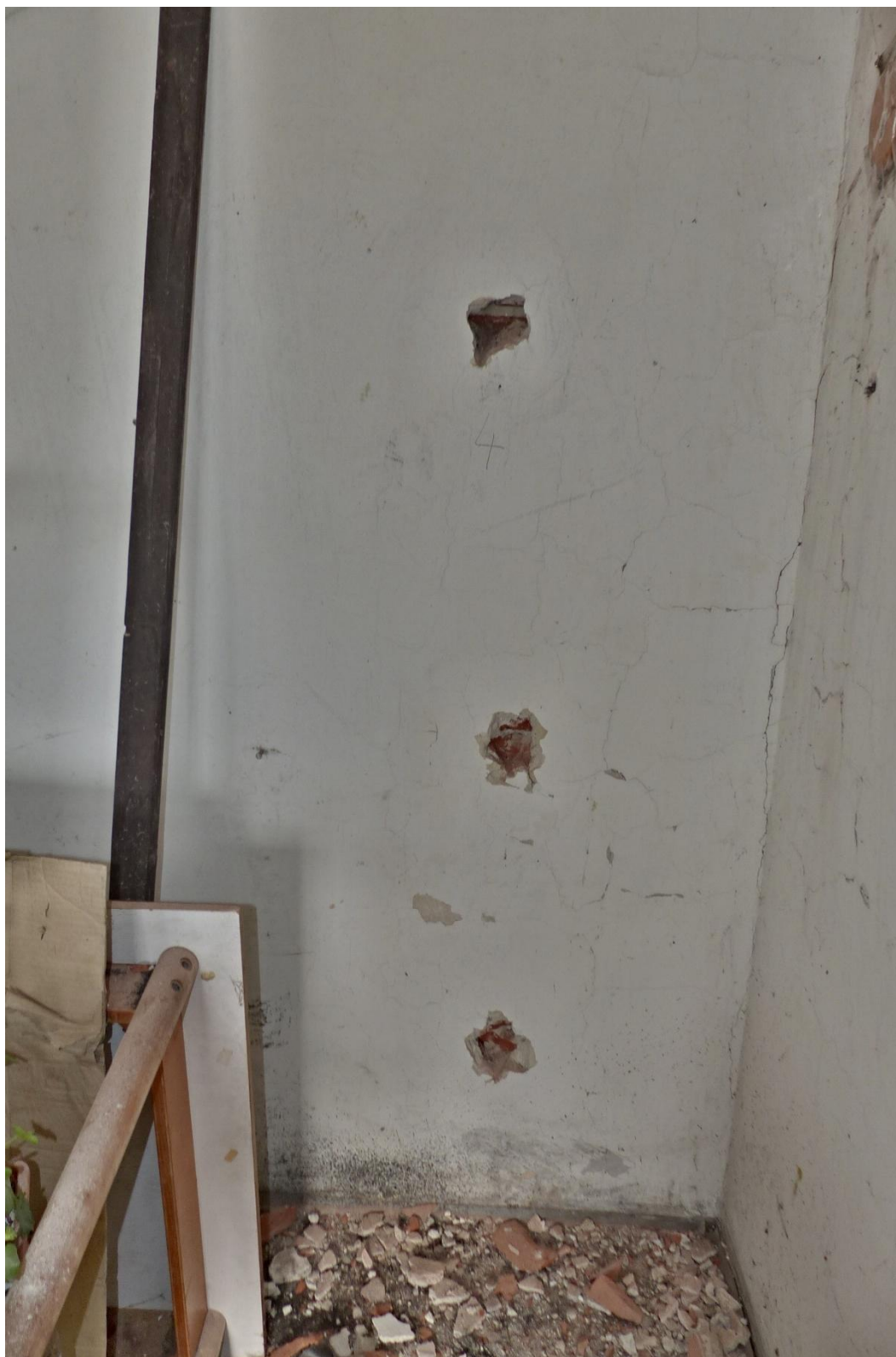
Foto č. 28 – Celkový pohled na vlhkostní profil WP 4, kde se odebraly vzorky omítky
