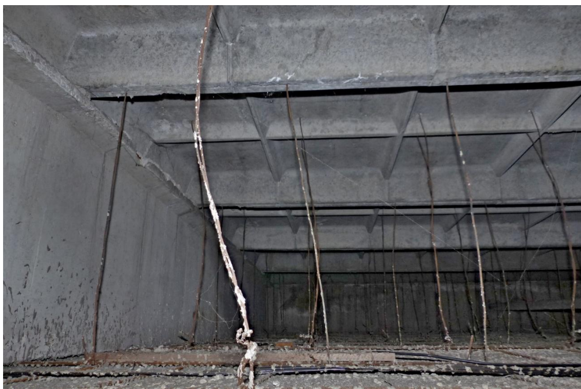
Foto č. 114 – Pohled na sondu do podhledu S5 v místnosti č. OP41
