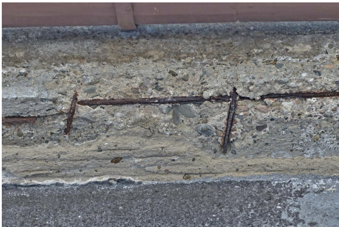
Foto č. 126 – Detailní pohled na sondu S7 ke zjištění zbytkové zkorodované výztuže
