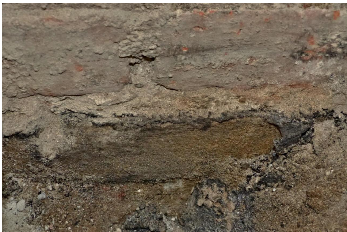
Foto č. 40 – Detailní pohled na hydroizolaci pod zdí u sondy P1
