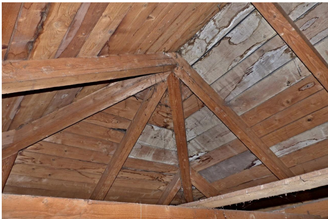
Foto č. 11 – detailní pohled na část krovu ve vrcholu u valby
