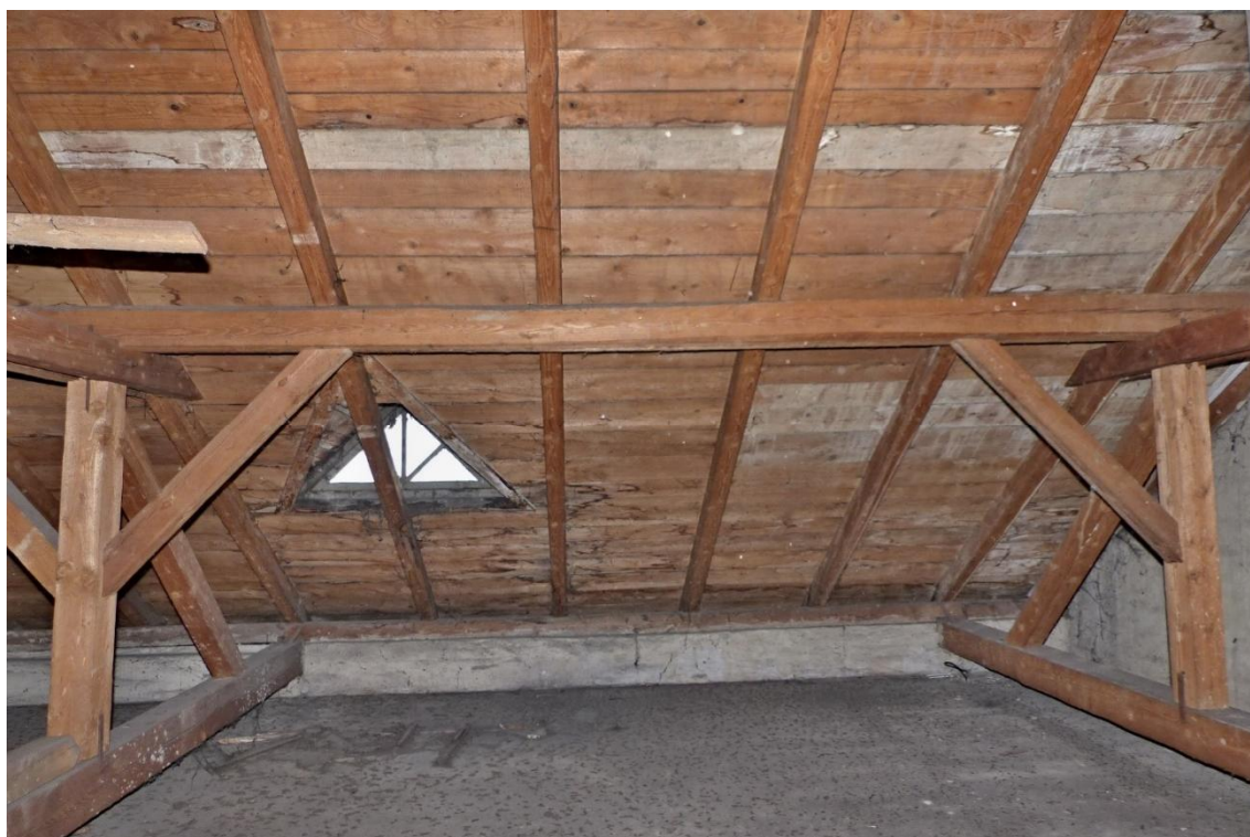
Foto č. 10 – pohled na střední vaznici u sedlové část krovu
