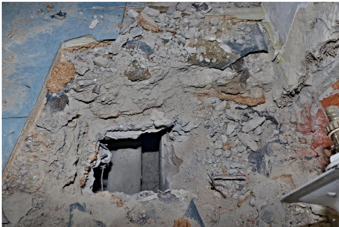
Foto č. 59 – Detailní pohled na sondu P3a u obvodové zdi nad kanálem s vytápěním
