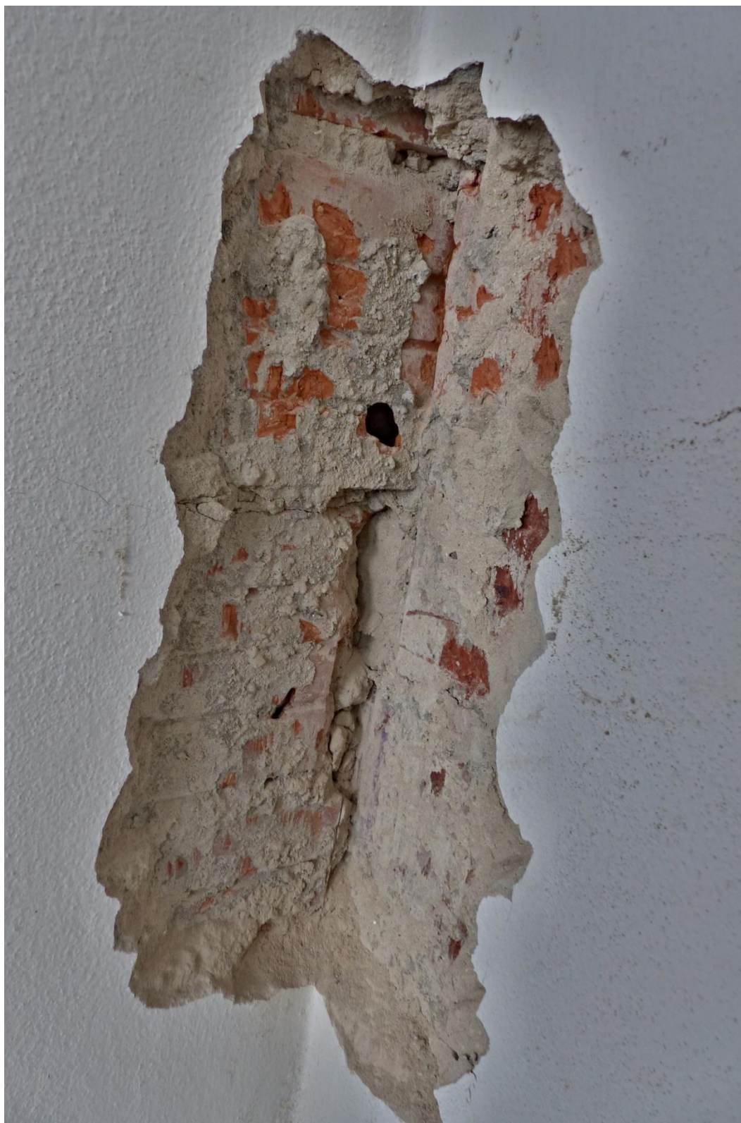
Foto č. 91 – Pohled na ověření materiálu příčky – sonda S3 v místnosti č. OP44
