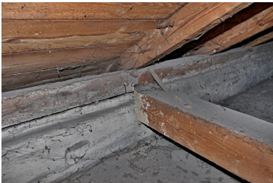
Foto č. 14 – detailní pohled na část krovu při podlaze u vazného trámu
