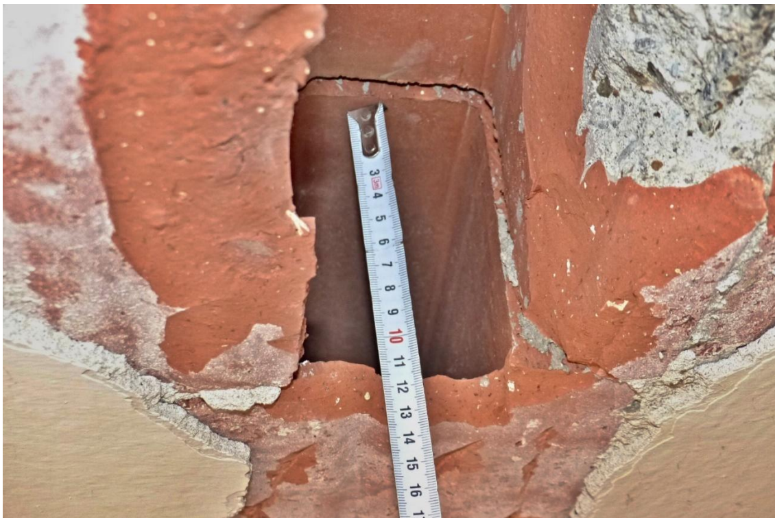
Foto č. 31 – Detailní pohled na sondu S1 do stropní konstrukce mezi 1.NP a 2.NP
