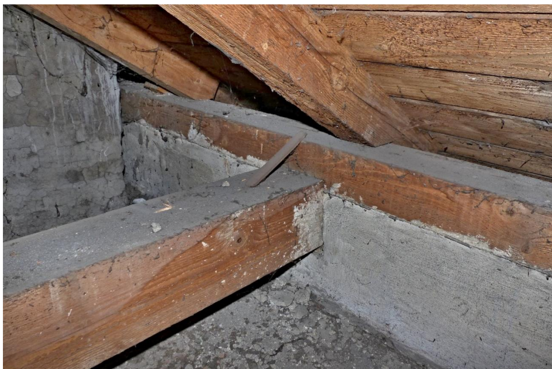
Foto č. 16 – detailní pohled na část krovu při podlaze u vazného trámu
