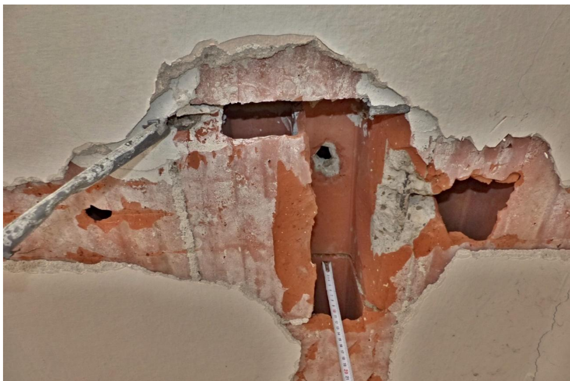
Foto č. 30 – Detailní pohled na sondu S1 do stropní konstrukce mezi 1.NP a 2.NP
