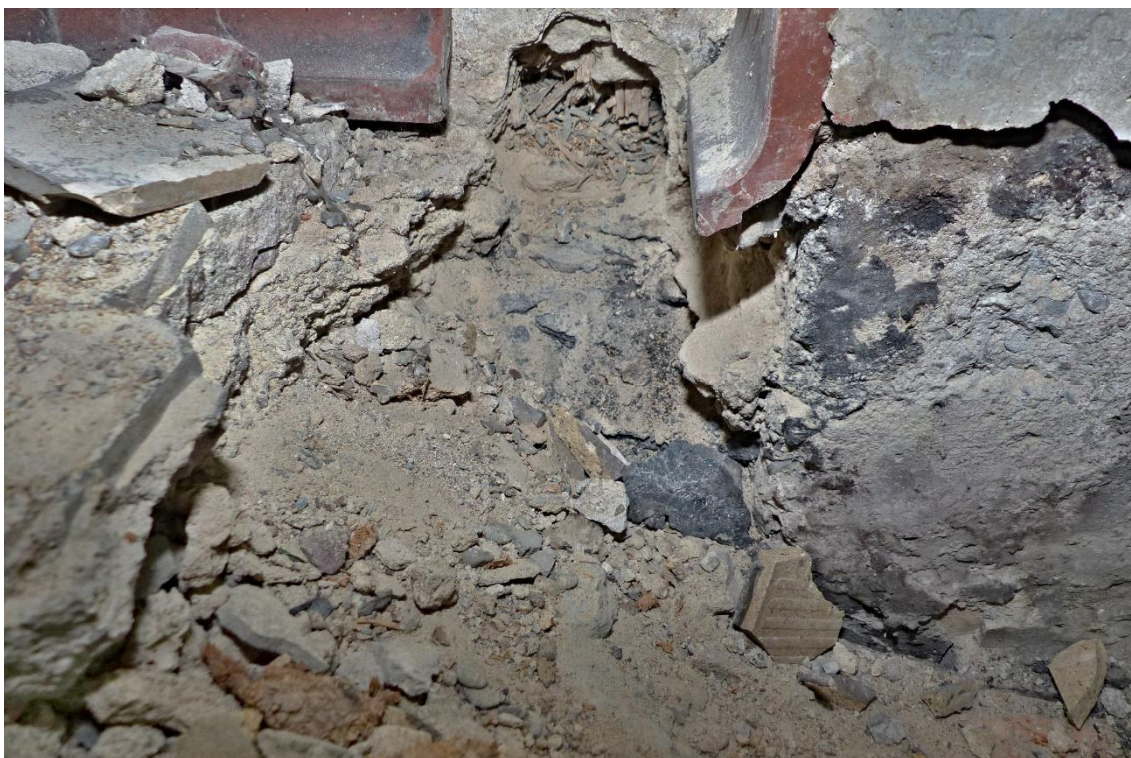
Foto č. 50 – Detailní pohled na hydroizolaci na nosném žlb sloupu u sondy P2
