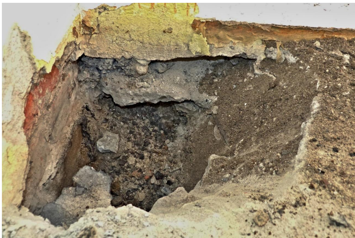
Foto č. 42 – Celkový pohled na kopanou sondu do podlahy P1
