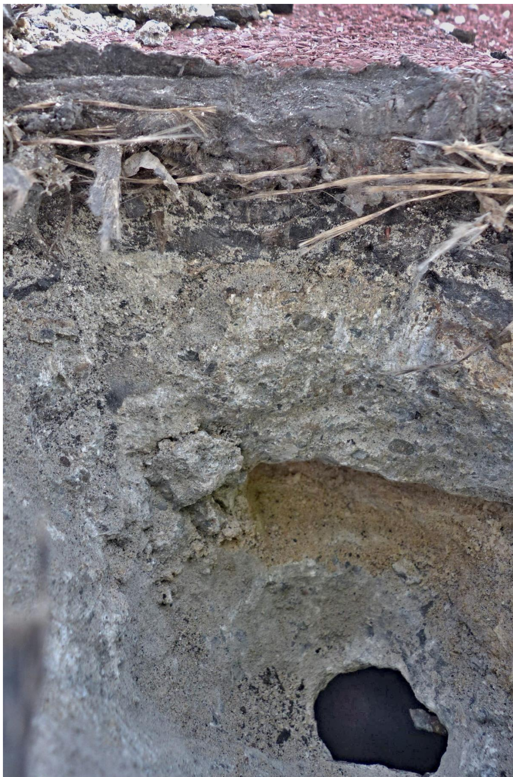
Foto č. 121 – Detailní pohled na sondu do ploché střechy S6
