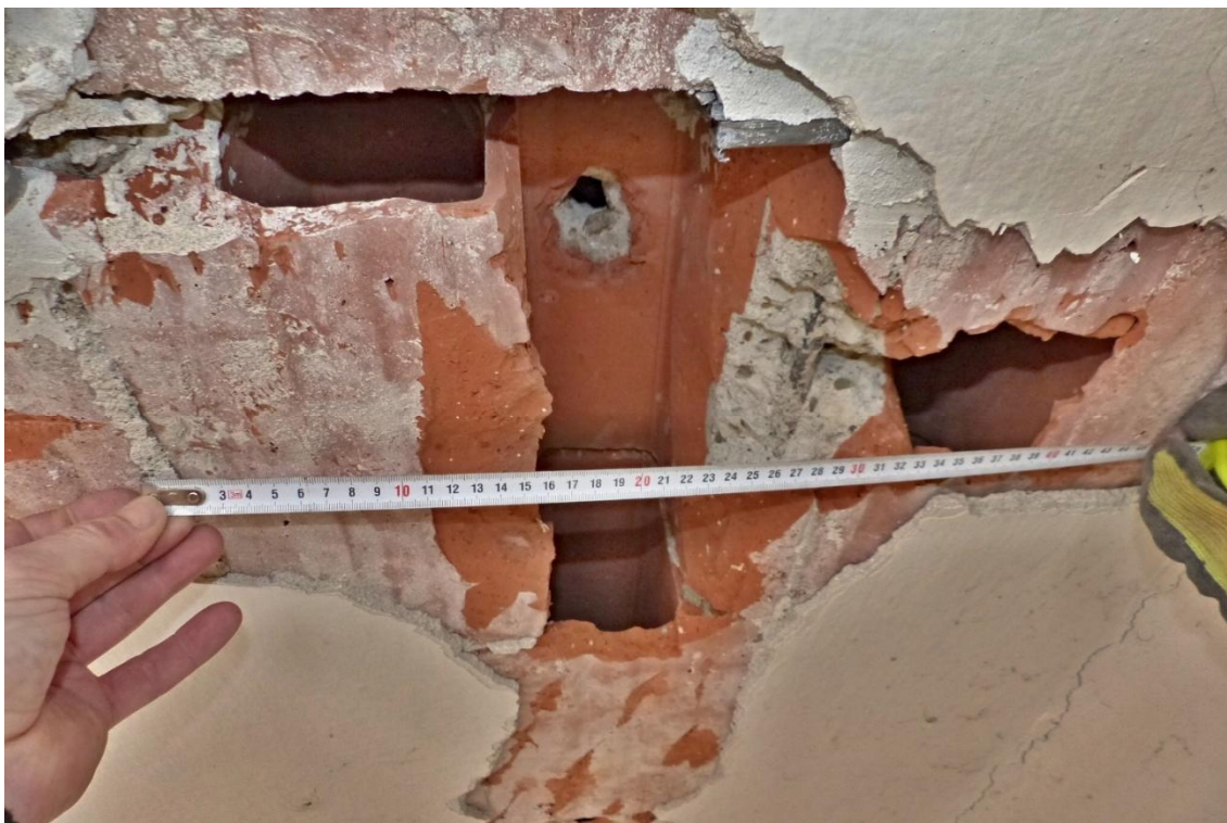
Foto č. 32 – Detailní pohled na sondu S1 do stropní konstrukce mezi 1.NP a 2.NP
