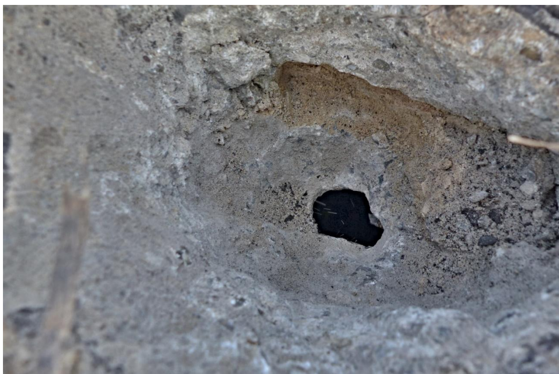
Foto č. 120 – Detailní pohled na sondu do ploché střechy S6
