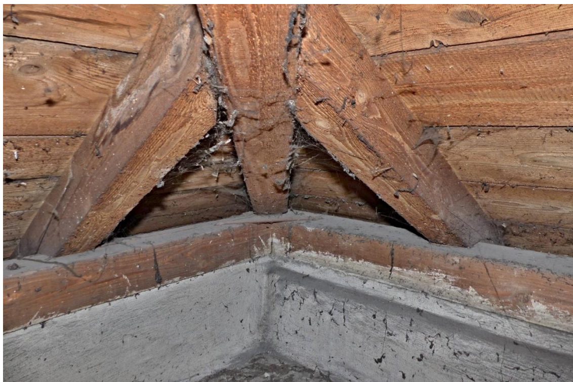
Foto č. 15 – detailní pohled na část krovu při podlaze u valby
