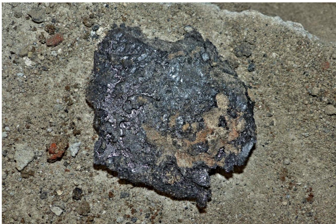
Foto č. 41 – Detailní pohled na hydroizolaci pod zdí u sondy P1
