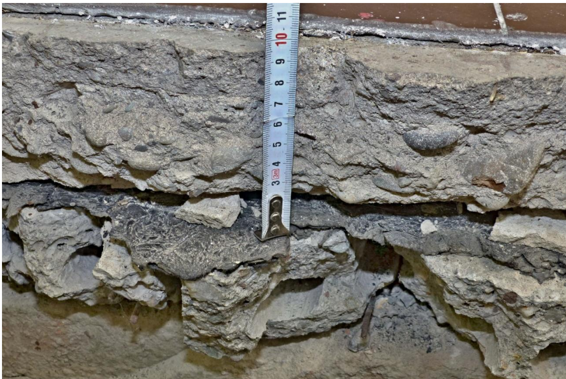
Foto č. 87 – Detailní pohled na řez podlahou u sondy P5 v místnosti OP24 – vstupní vestibul v bloku B
