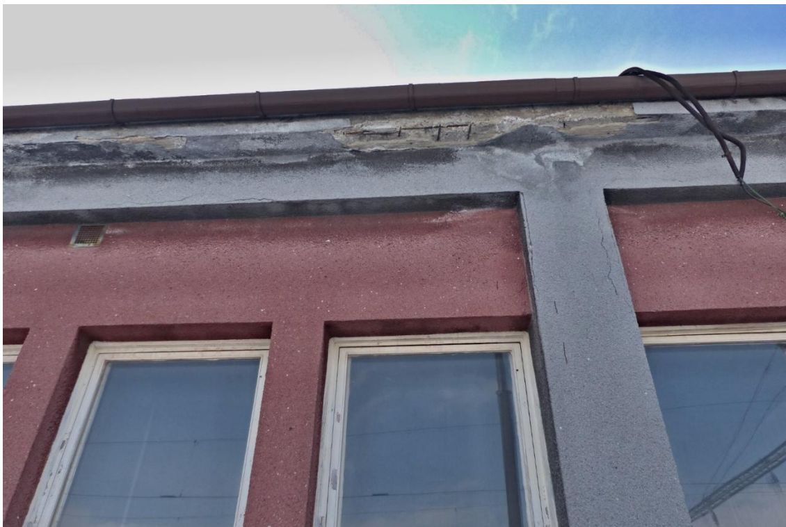
Foto č. 124 – Detailní pohled na sondu S7 ke zjištění zbytkové zkorodované výztuže
