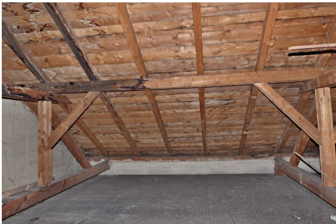
Foto č. 9 – pohled na střední vaznici u sedlové část krovu
