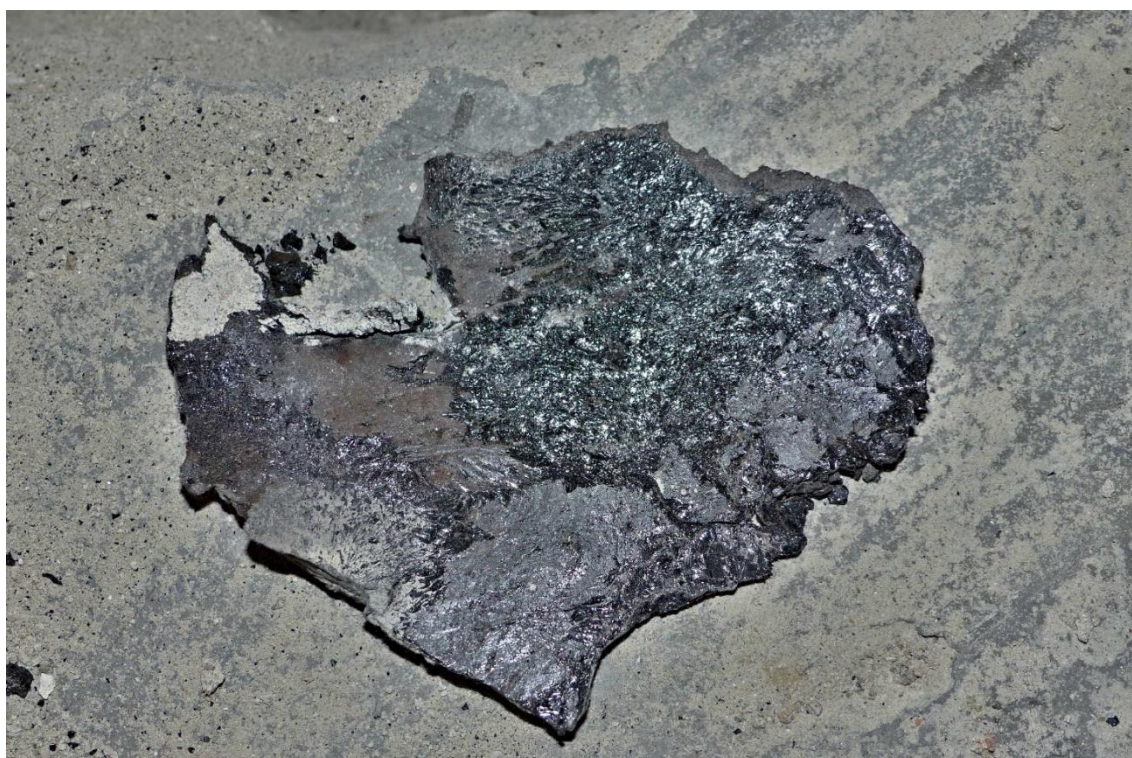
Foto č. 76 – Detailní pohled na hydroizolaci u na sondy P4 v místnosti OP41
