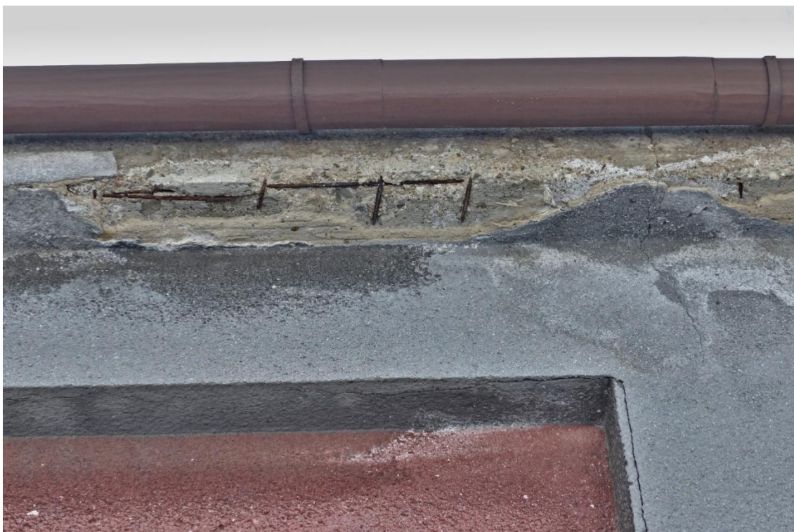
Foto č. 125 – Detailní pohled na sondu S7 ke zjištění zbytkové zkorodované výztuže
