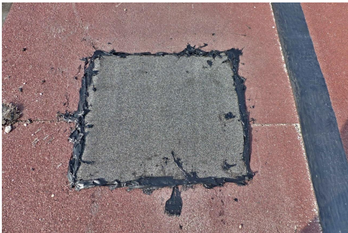
Foto č. 122 – Pohled na opravu sondy do ploché střechy S6
