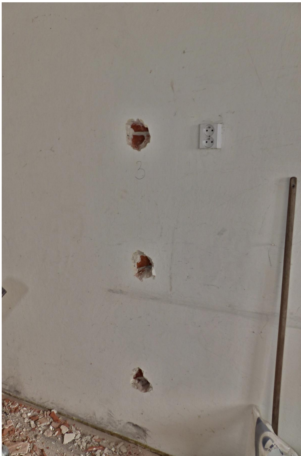
Foto č. 27 – Celkový pohled na vlhkostní profil WP 3, kde se odebraly vzorky omítky
