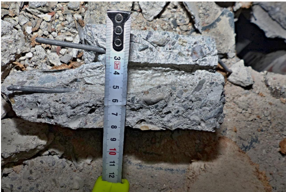
Foto č. 62 – Detailní pohled na žlb prefa desku nad kanálem s vytápěním u sondy P3a
