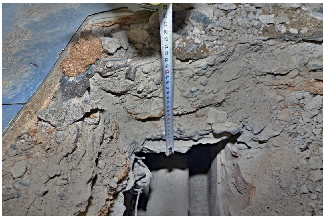
Foto č. 60 – Detailní pohled na sondu P3a u obvodové zdi nad kanálem s vytápěním
