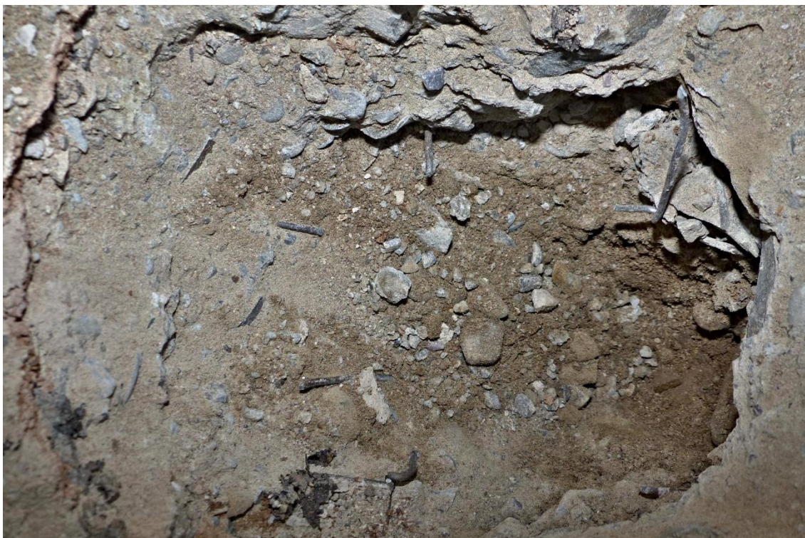
Foto č. 47 – Detailní pohled na kopanou sondu P2 do podlahy v místě mimo kanál s vytápěním
