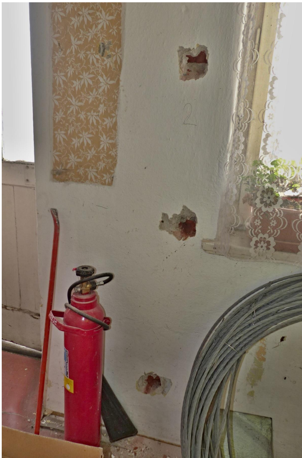
Foto č. 26 – Celkový pohled na vlhkostní profil WP 2, kde se odebraly vzorky omítky
