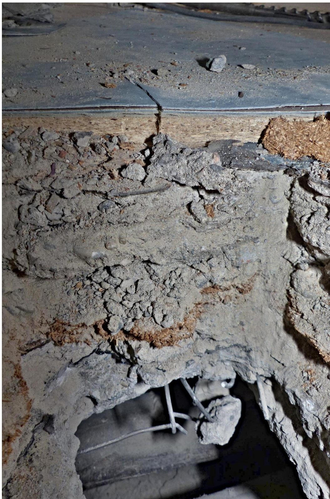
Foto č. 61 – Detailní pohled na sondu P3a u obvodové zdi nad kanálem s vytápěním
