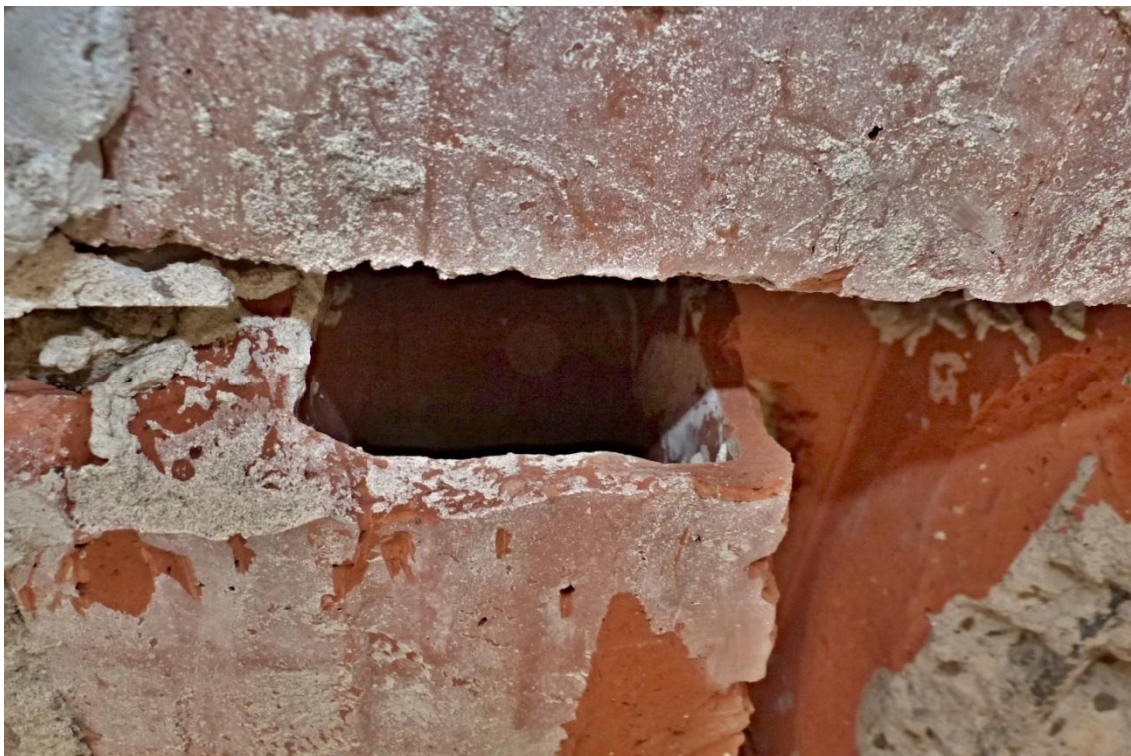
Foto č. 35 – Detailní pohled na sondu S1 do stropní konstrukce mezi 1.NP a 2.NP
