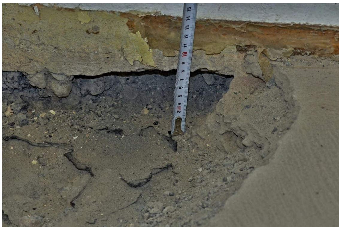
Foto č. 38 – Detailní pohled na kopanou sondu do podlahy P1
