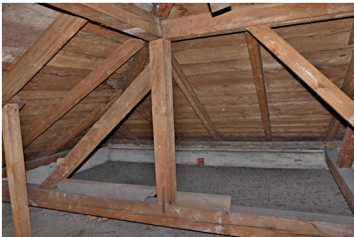
Foto č. 12 – detailní pohled na část krovu u valby
