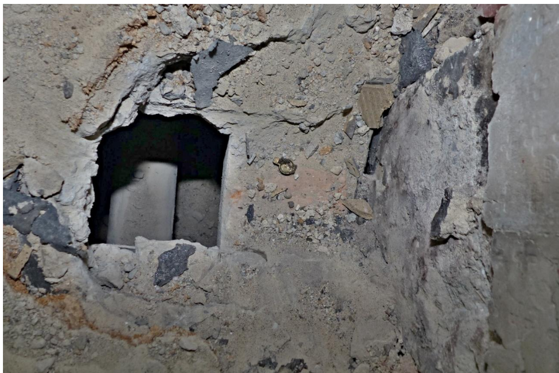
Foto č. 51 – Celkový pohled na odkrytý kanál s vytápěním u sondy P2
