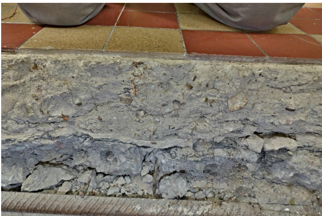
Foto č. 86 – Pohled na řez podlahou u sondy P5 v místnosti OP24 – vstupní vestibul v bloku B
