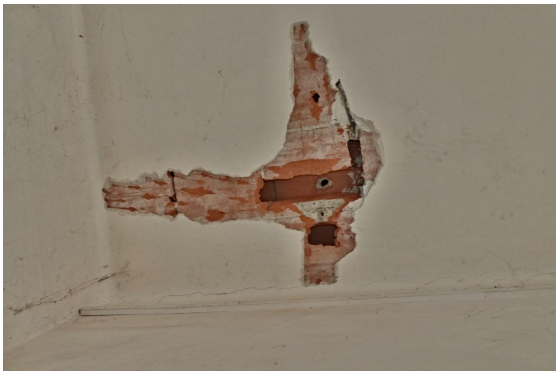
Foto č. 29 – Celkový pohled na sondu S1 do stropní konstrukce mezi 1.NP a 2.NP
