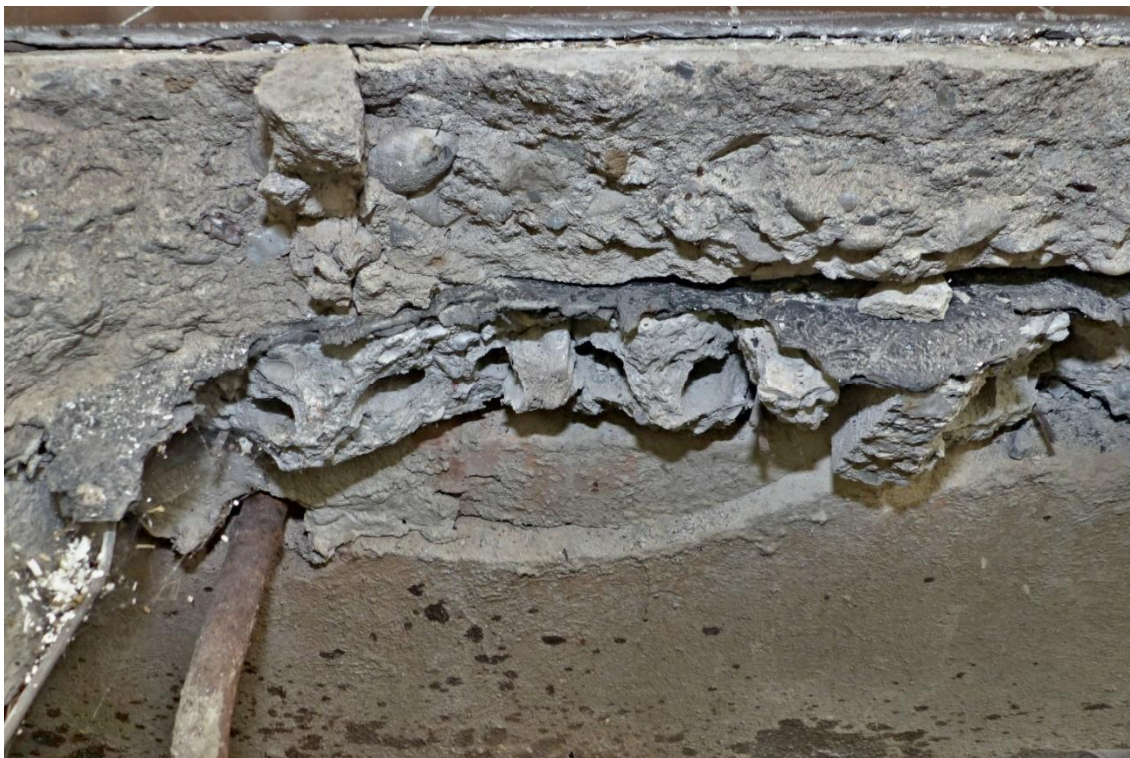
Foto č. 85 – Pohled na řez podlahou u sondy P5 v místnosti OP24 – vstupní vestibul v bloku B
