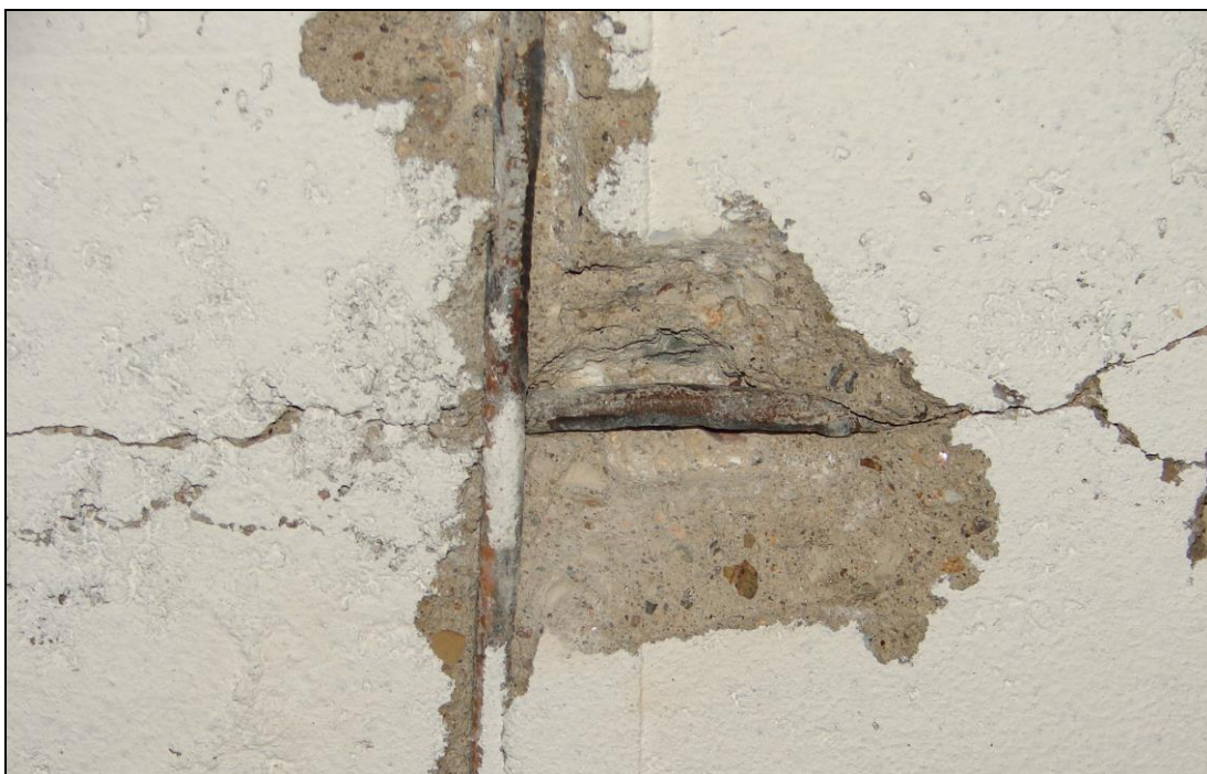
Foto 7: DESKA D1; výztuž Ø 6 E (10 216) je zasažena slabou povrchovou korozí bez tvorby korozních zplodin a bez zjevného úbytku plochy průřezu
