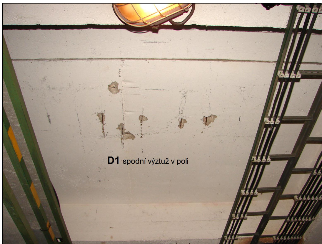
Foto 5: DESKA D1; celkový pohled na desku s vyznačením sondy
