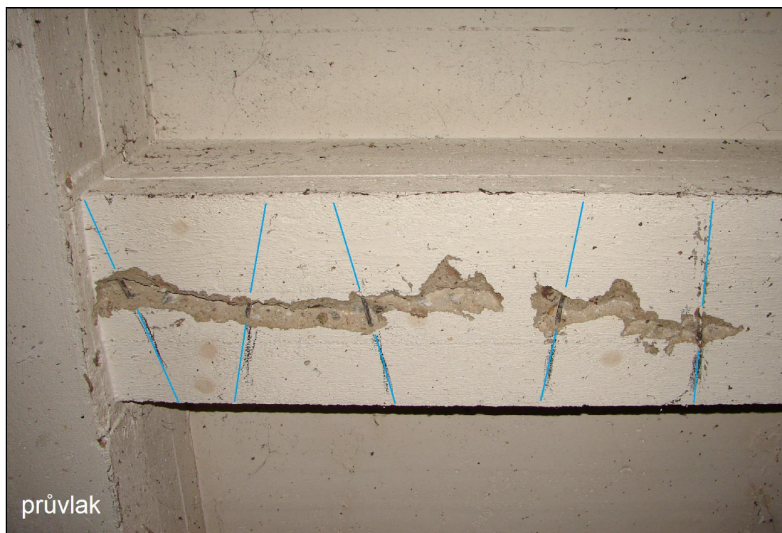
Foto 3: TRÁM T1; třmínky u podpory (průvlaku), pohled na spodní líc trámu, třmínky Ø 6 E (10 216)
