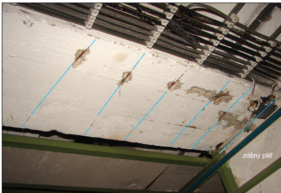
Foto 11: PRŮVLAK P1; třmínky u podpory (pilíře), pohled na spodní líc průvzlaku, čtyřstřížné třmínky Ø 6 E (10 216)
