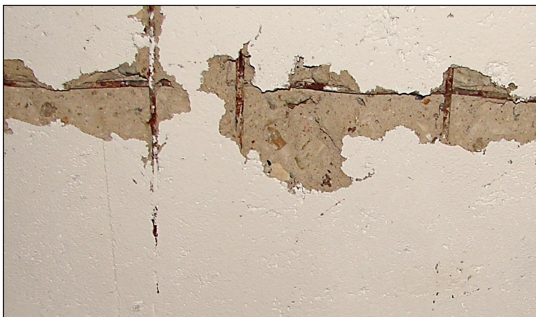
Foto 18: DESKA D2; výztuž Ø 6 E / Ø 8 E (10 216) je zasažena povrchovou korozí s počátkem tvorby korozních zplodin, avšak bez zjevného úbytku plochy průřezu
