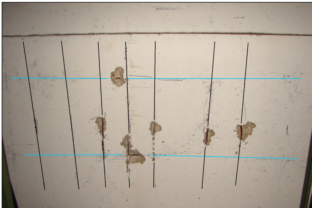
Foto 6: DESKA D1; černě vyznačena spodní výztuž v poli Ø 6 E (10 216), modře vyznačena rozdělovací výztuž Ø 6 E (10 216)
