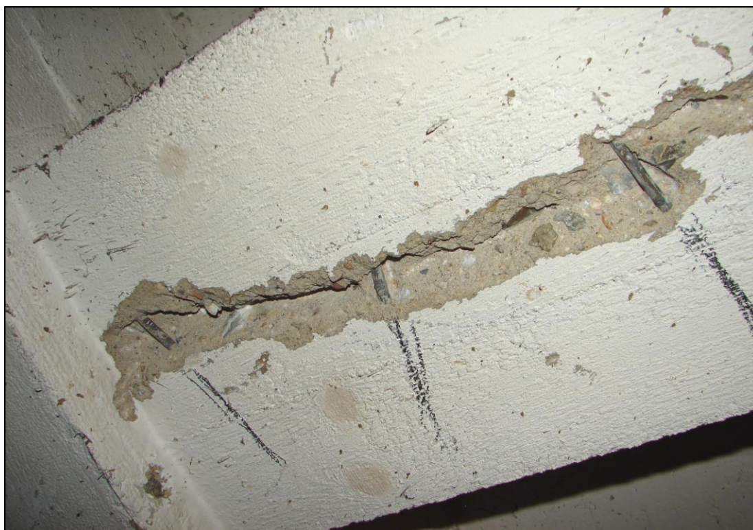
Foto 4: TRÁM T1; třmínky u podpory (průvlaku), třmínky jsou zasaženy slabou povrchovou korozí bez tvorby korozních zplodin a bez zjevného úbytku plochy průřezu
