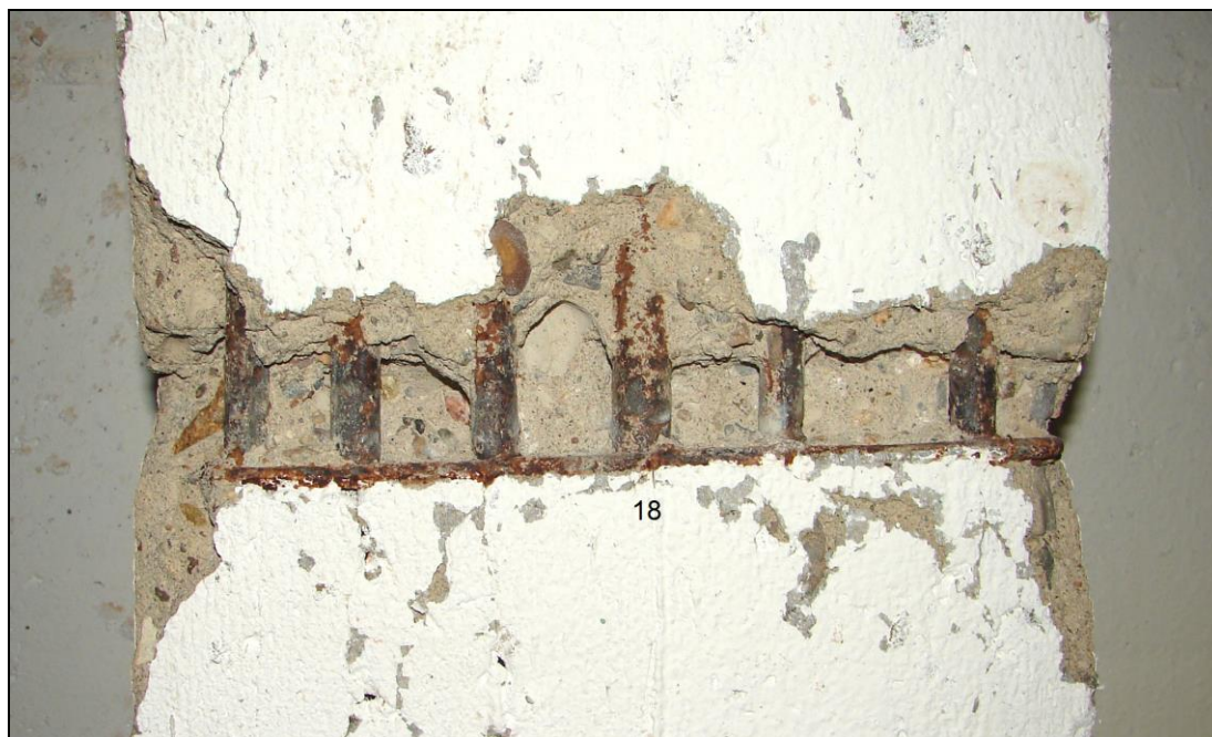
Foto 14: TRÁM T2; výztuž střed rozpětí 5 Ø 14 E + 1 Ø 18 E (10 216), třmínek Ø 6 E (10 216), výztuž je zasažena povrchovou korozí doprovázenou tvorbou korozních zplodin, avšak bez zjevného úbytku plochy průřezu
