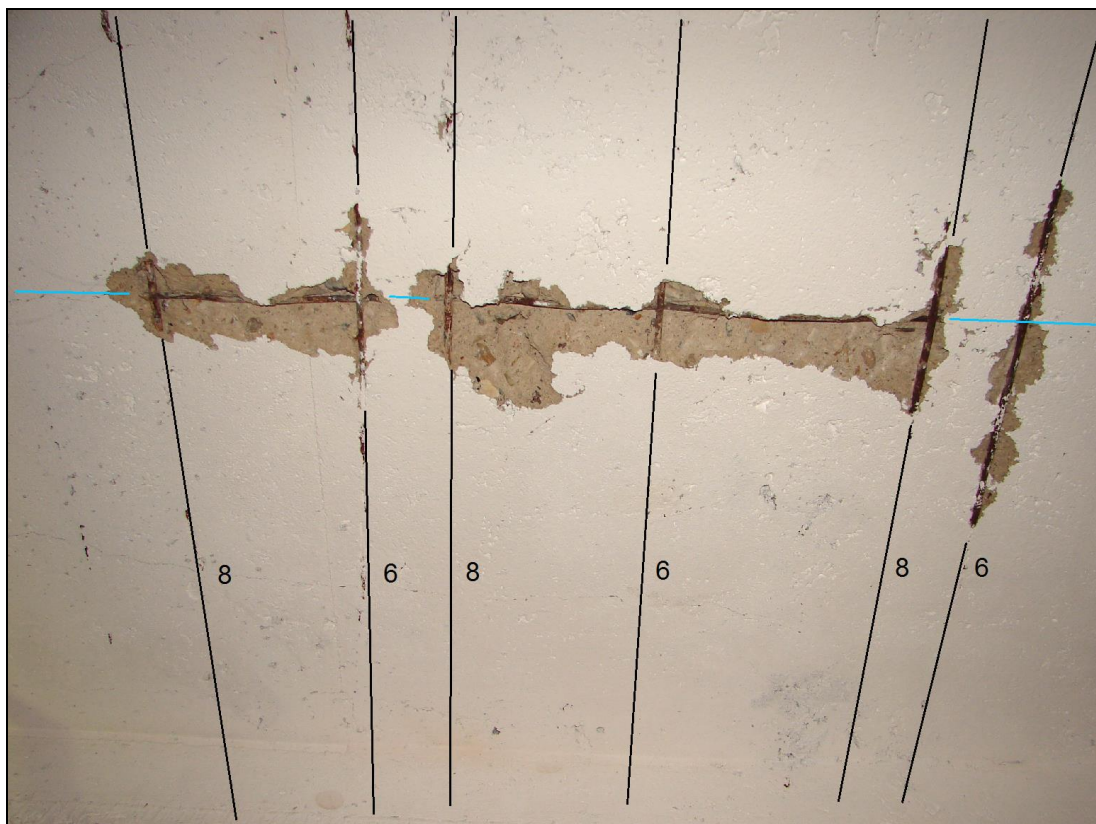
Foto 17: DESKA D2; černě vyznačena spodní výztuž v poli Ø 6 E / Ø 8 E (10 216), modře vyznačena rozdělovací výztuž Ø 6 E (10 216), celkový pohled na sondu viz foto 13
