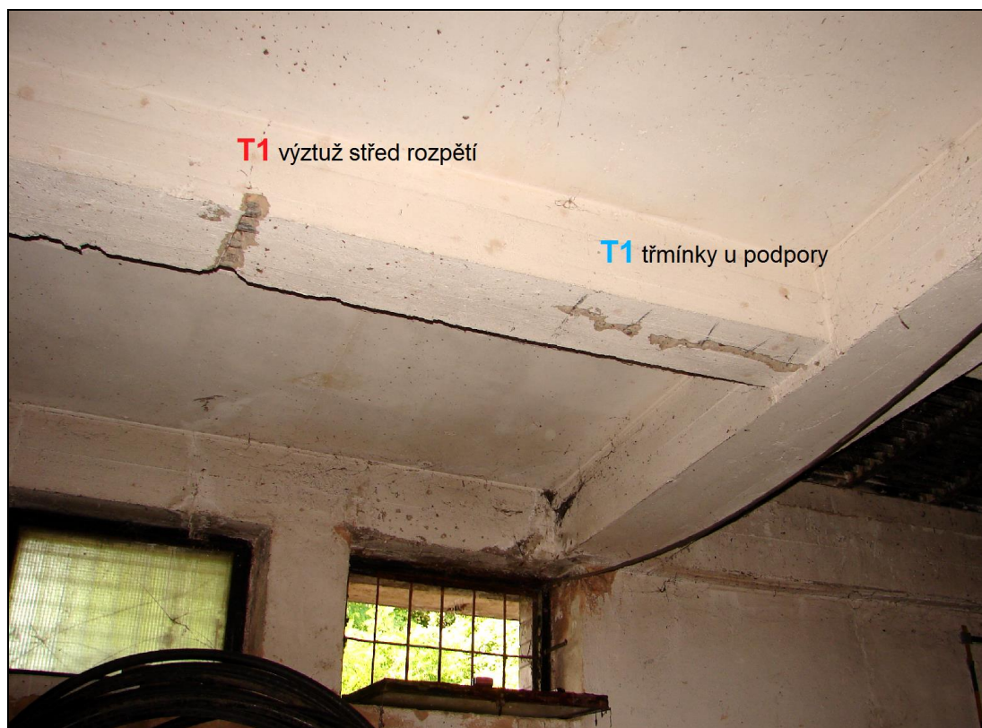
Foto 1: TRÁM T1; celkový pohled na trám s vyznačením sond
