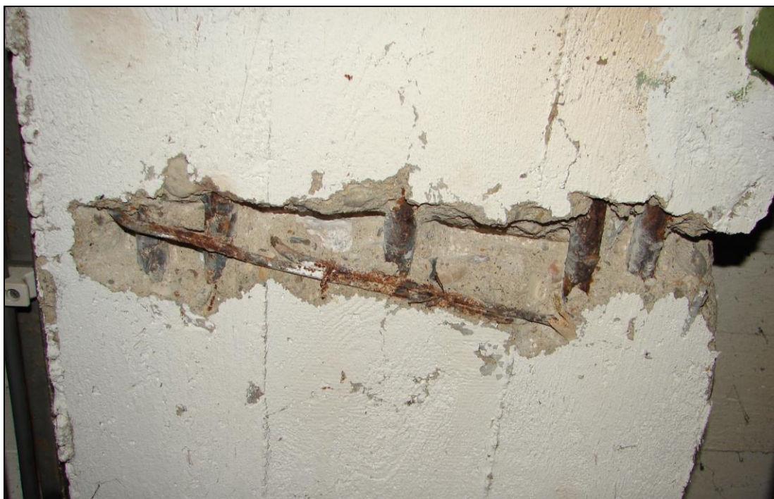
Foto 10: PRŮVLAK P1; výztuž střed rozpětí 5 Ø 20 E (10 216), třmínek Ø 6 E (10 216), výztuž je zasažena slabou povrchovou korozi bez tvorby korozních zplodin a bez zjevného úbytku plochy průřezu
