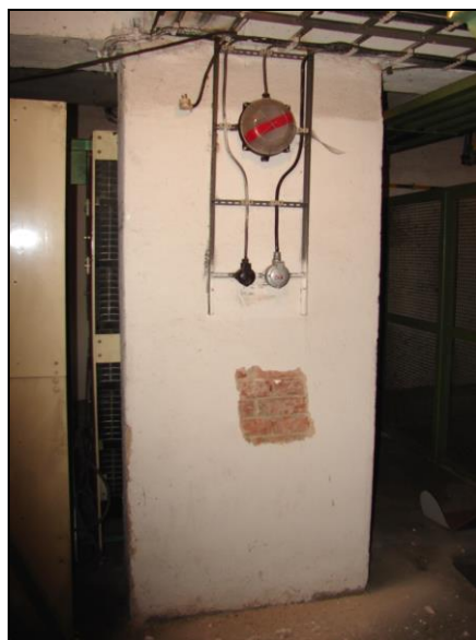
Foto 5: Zděný pilíř, příčný průřez 900 / 450 mm (zk. místo Z1)
