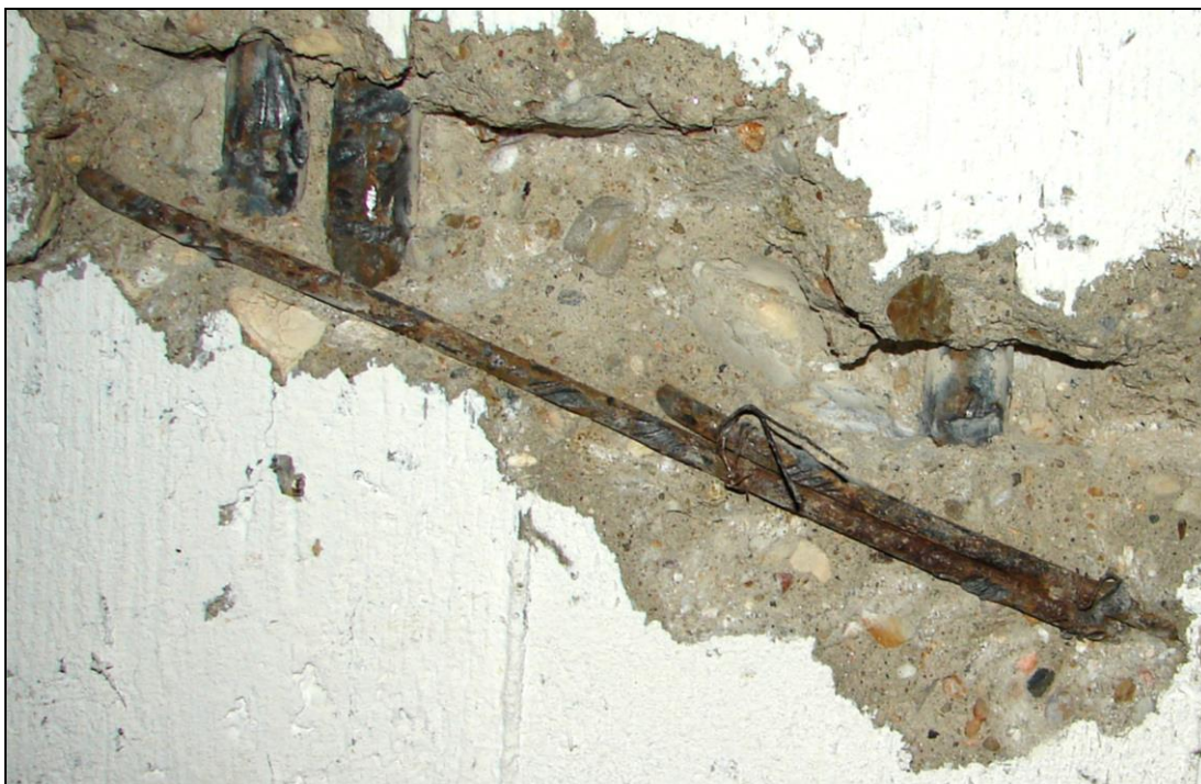
Foto 22: PRŮVLAK P2; čtyřstržné třmínky u podpory (pilíře), třmínky jsou zasaženy povrchovou korozí, místy s počátkem tvorby korozních zplodin, avšak bez zjevného úbytku plochy průřezu
