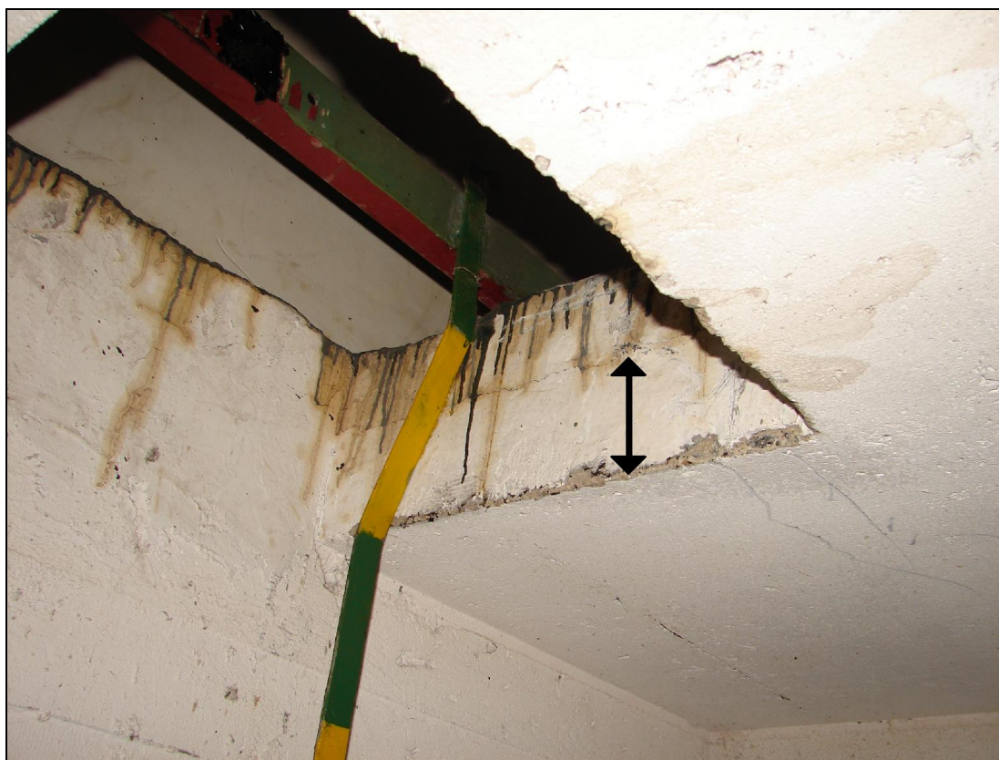
Foto 8: DESKA D1; tloušťka desky byla stanovena ve dvou stávajících otvorech, stejným způsobem byla stanovena i tloušťka desky D2
