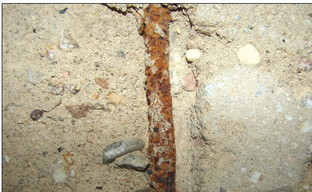
Foto 16: TRÁM T2; třmínky jsou zasaženy silnou korozí doprovázenou tvorbou korozních zplodin s oslabením plochy průřezu o cca 5 %
