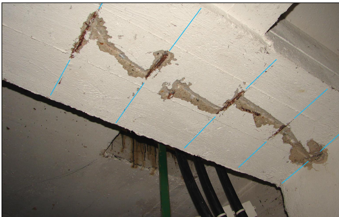
Foto 21: PRŮVLAK P2; třmínky u podpory (pilíře), pohled na spodní líc průvlaku, čtyřstržné třmínky Ø 6 E (10 216)
