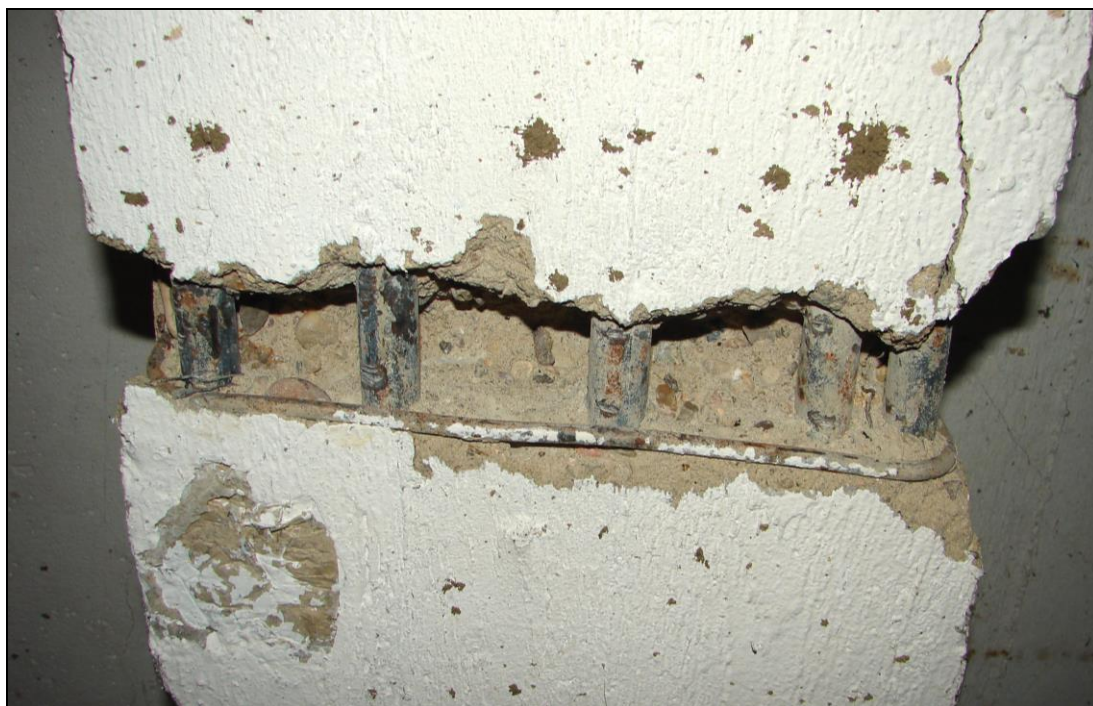
Foto 2: TRÁM T1; výztuž střed rozpětí 5 Ø 20 E (10 216), třmínek Ø 6 E (10 216), výztuž je zasažena slabou povrchovou korozi bez tvorby korozních zplodin a bez zjevného úbytku plochy průřezu
