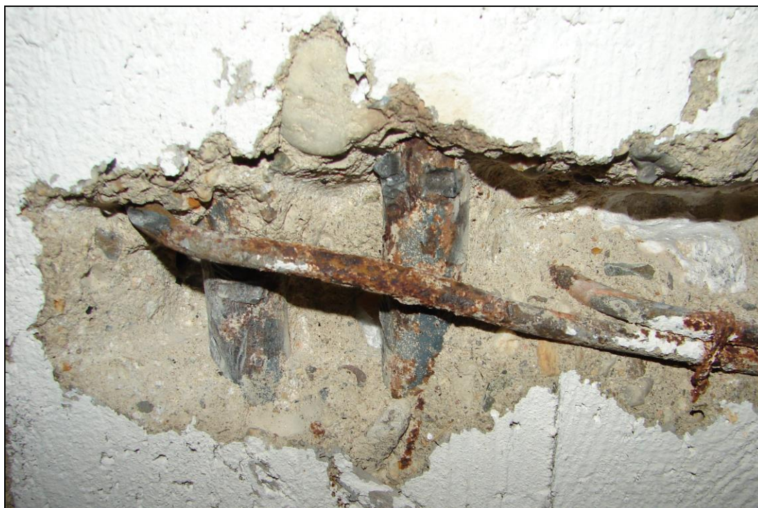
Foto 12: PRŮVLAK P1; čtyřstřížné třmínky u podpory (pilíře), třmínky jsou zasaženy povrchovou korozí, místy s počátkem tvorby korozních zplodin, avšak bez zjevného úbytku plochy průřezu
