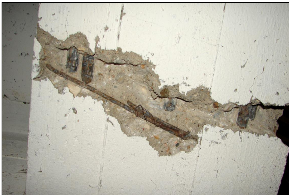
Foto 20: PRŮVLAK P2; výztuž střed rozpětí 5 Ø 20 E (10 216), třmínky Ø 6 E (10 216), výztuž je zasažena slabou povrchovou korozí bez tvorby korozních zplodin a bez zjevného úbytku plochy průřezu
