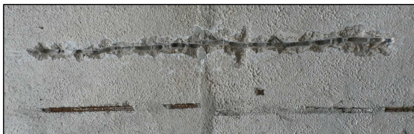
Obr. č.1: sonda do spodního líce konstrukce SNK1
