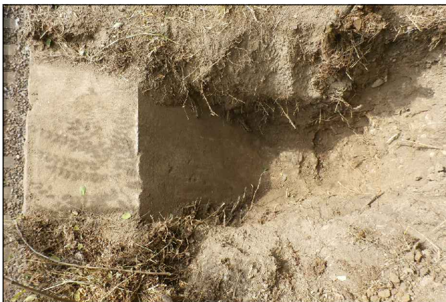
Obr. č.1: kopaná sonda pro ověření tvaru zárubní zdii
