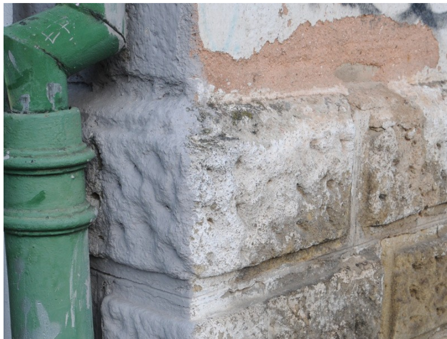
Povrch kamene s nátěrem před a po čištění
