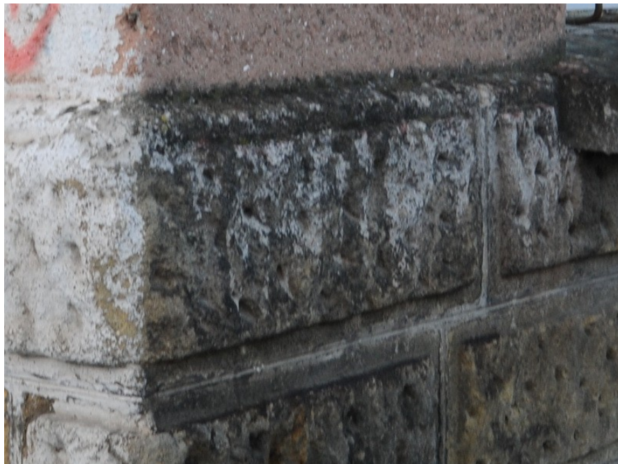
Povrch kamene před a po čištění
