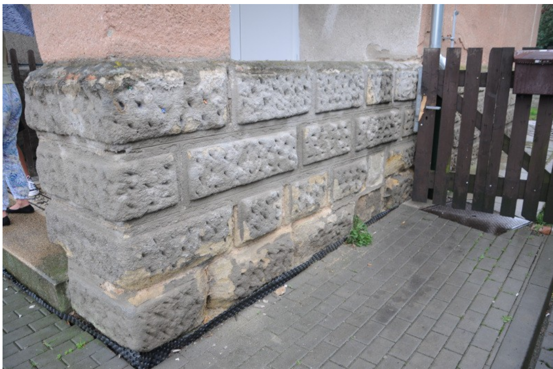
Sokl severozápadní strany – nátěr cementovým pačokem
