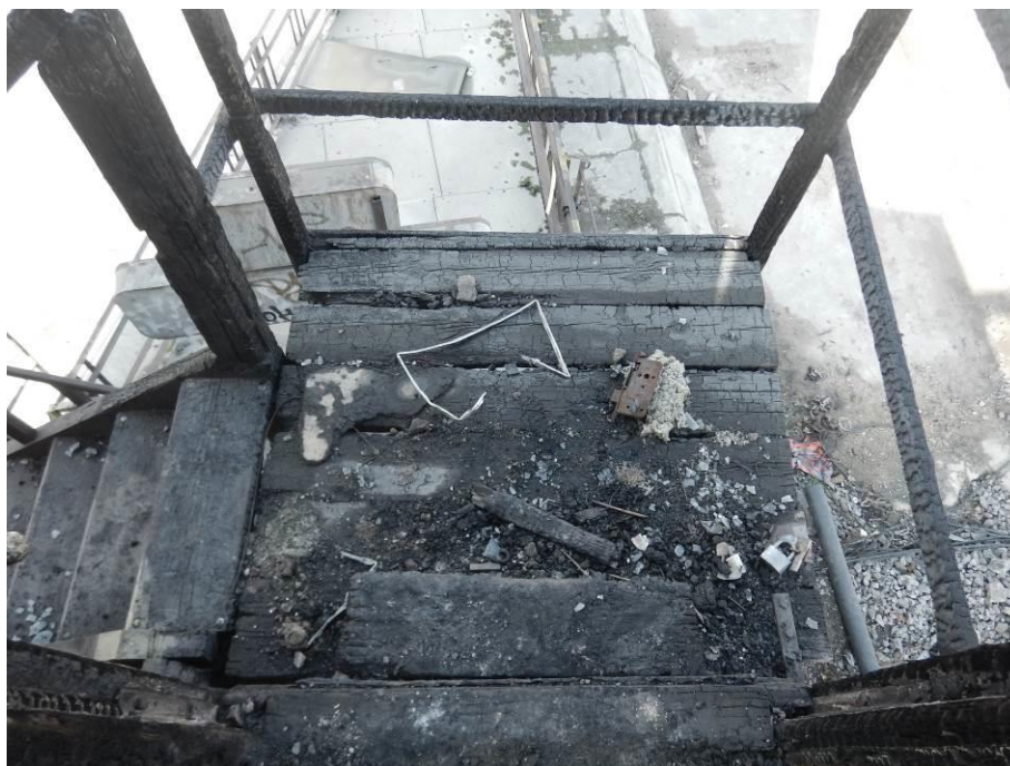
Foto 23: Pohled na podestu, nutná výměna fošen (konstrukce schodiště má být nahrazena)
