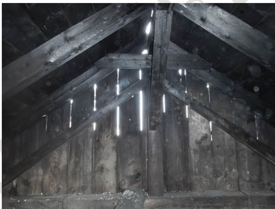
Foto 12: Pohled do krovu, konstrukce je pouze začouzena
