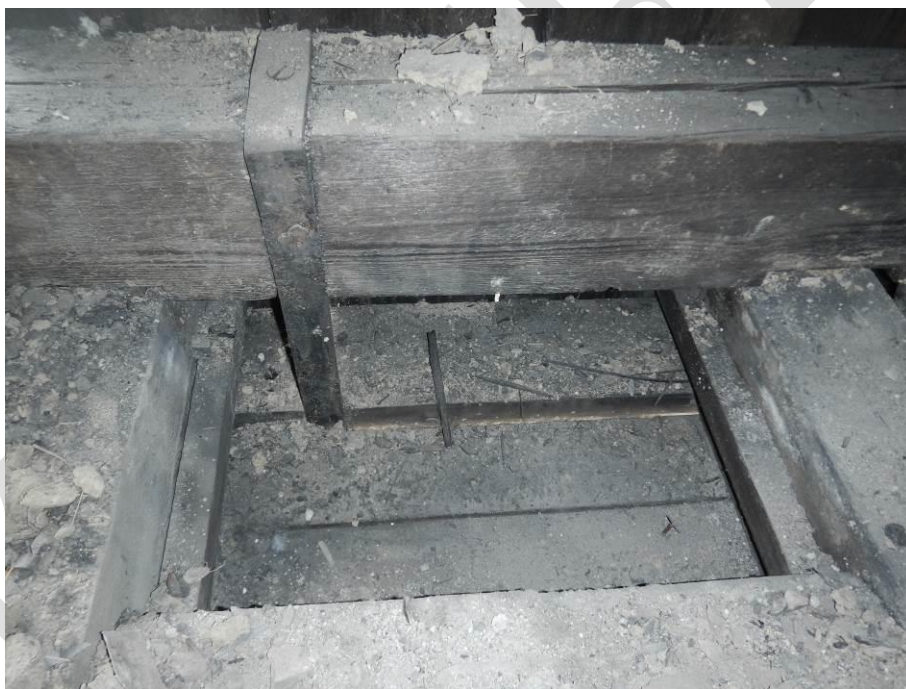
Foto 18: Pohled stropní trámy pod záklopem, bez známek ohoření
