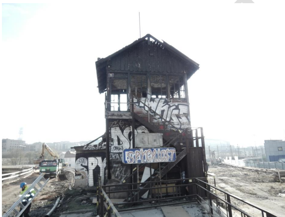
Obr. 1: Diagnostikované hradlo H4 po požáru, umístění hradla je v místě rozdělení jednotlivých větví Negrelliho viaduktu
