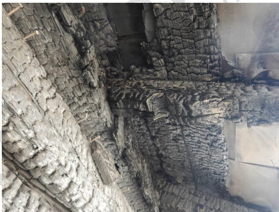
Foto 22: Pohled na přesahující část krokví, doporučujeme po očištění ověřit možnost zachování, případně zvážit možnost převislou část nahradit replikou
