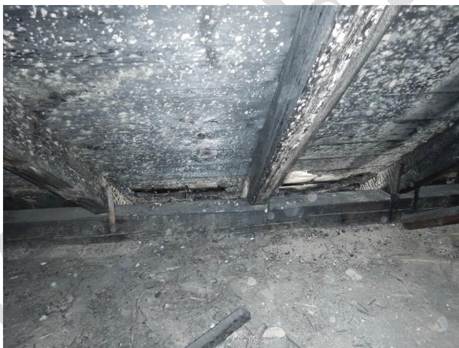
Foto 14: Pohled do krovu pravá strana bok, u pozednice je patrné porušení prkenného záklopu (má být obnoven)
