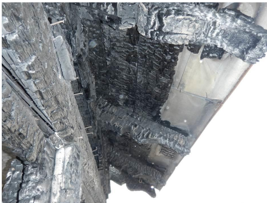
Foto 21: Pohled na přesahující část krokví, doporučujeme po očištění ověřit možnost zachování, případně zvážit možnost převislou část nahradit replikou
