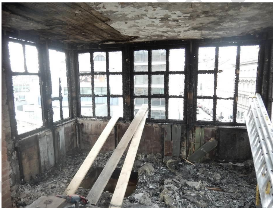
Foto 4: Pohled do objektu hradla, očištěné meziokení sloupy
