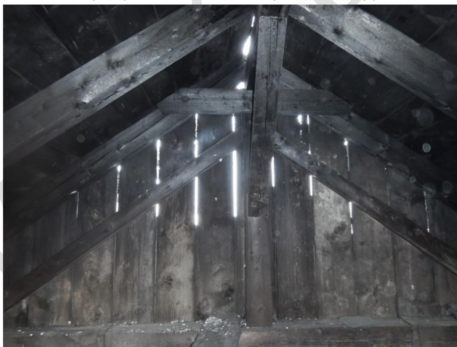
Pohled na šikmou vzpěru vnitřní část krovu nezasažena požárem
