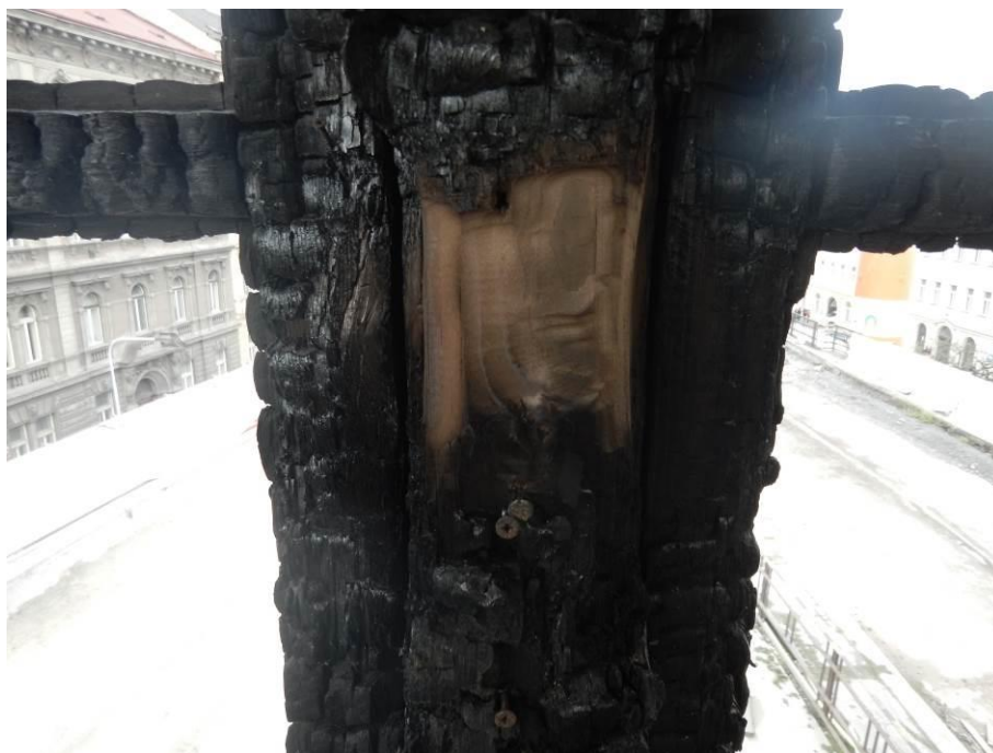
Foto 7: Detail očištěného meziokeního sloupku
