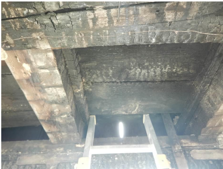
Foto 19: Pohled do stropu po odstranění podhledu, nosné trámy bez známek ohoření
