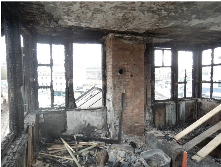
Foto 3: Pohled do objektu hradla, očištěné meziokení sloupy
