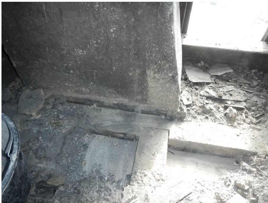
Foto 17: Pohled na trámovou výměnu v oblasti komínu, prvky nejeví známky ohoření
