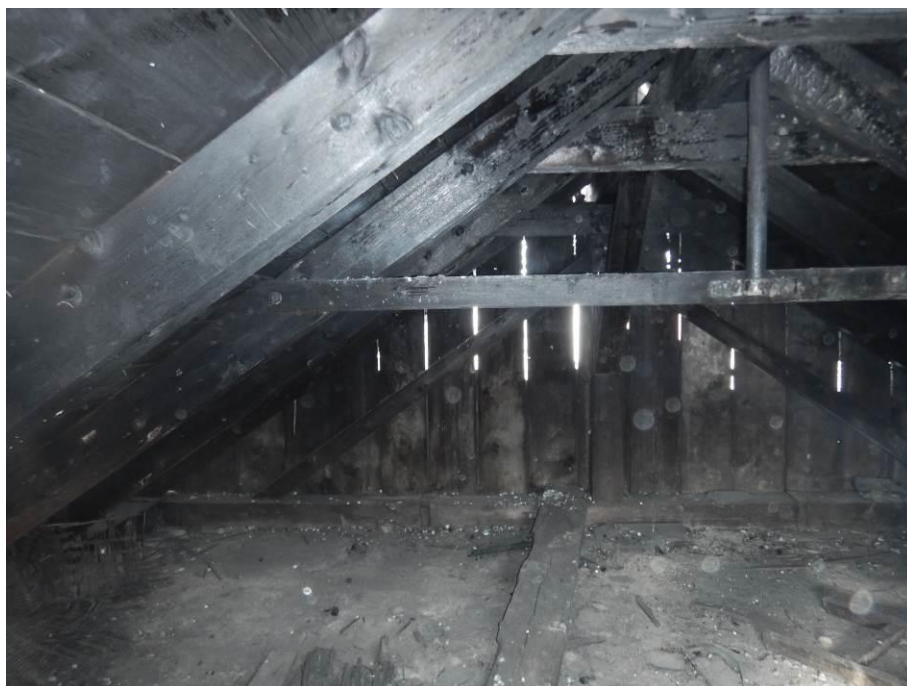
Foto 13: Pohled do krovu, konstrukce je pouze začouzena
