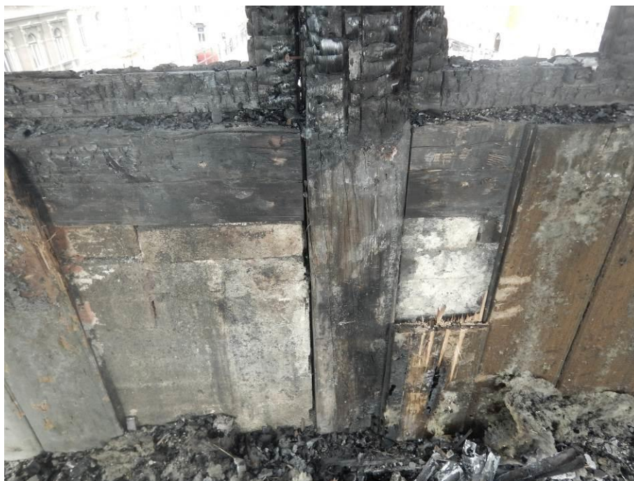
Foto 11: Pohled na patu sloupu po odstranění obkladu
