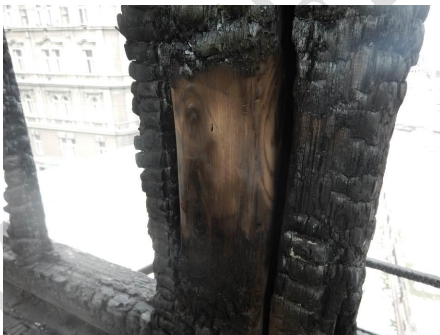
Foto 6: Detail očištěného meziokeního sloupku
