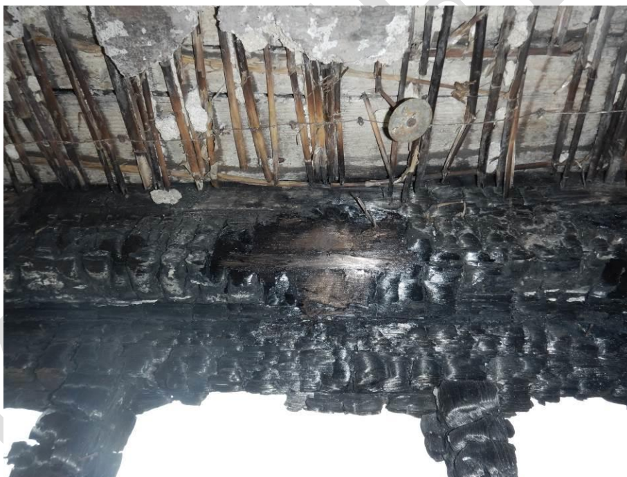
Foto 10: Pohled na očištěný spojující trám ve stropní rovině
