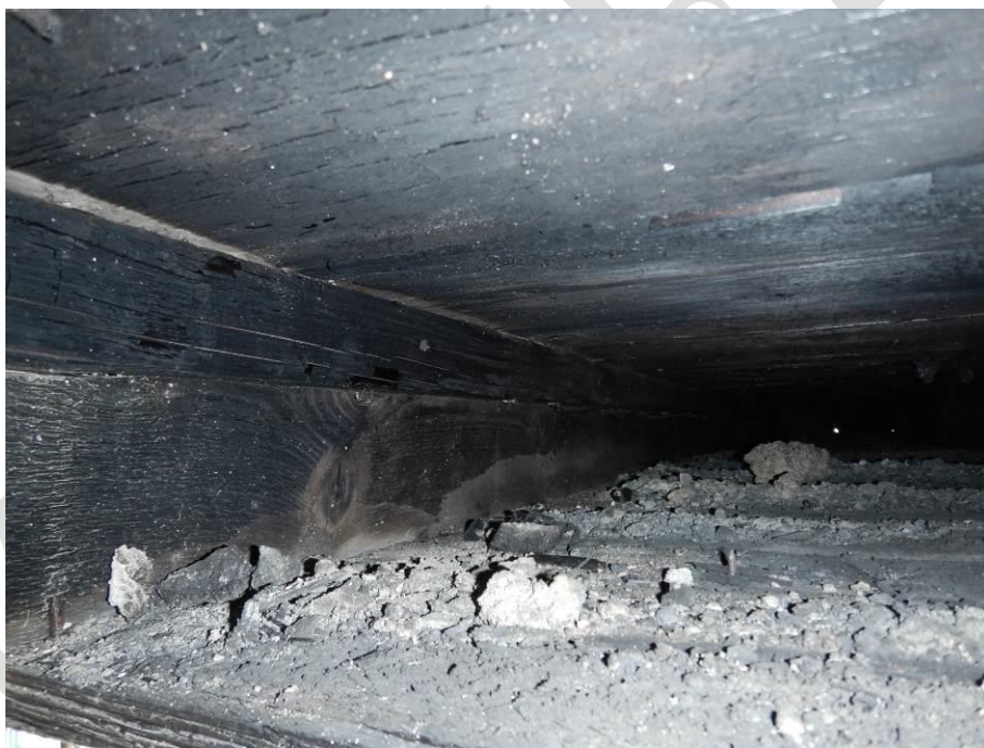
Foto 20: Pohled do pohledu, nosné trámy bez známek ohoření
