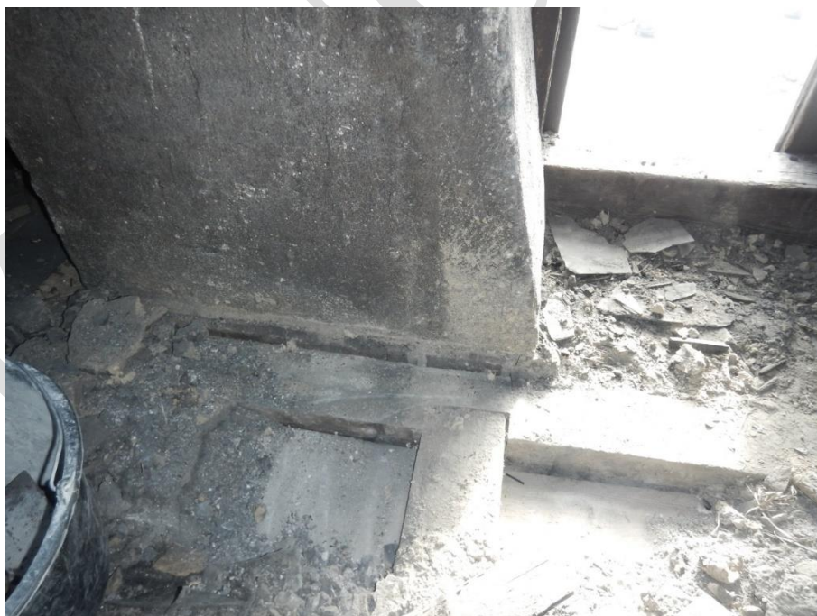
Pohled na komínovou výměnu, která je neoslabena vlivem požáru
