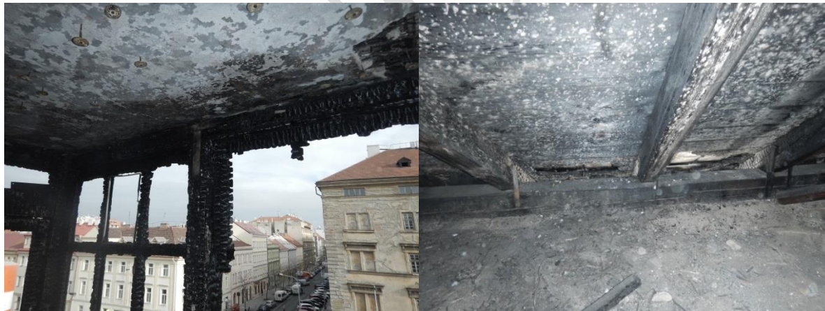
Posudek pozednice průřez oslabený požárem
