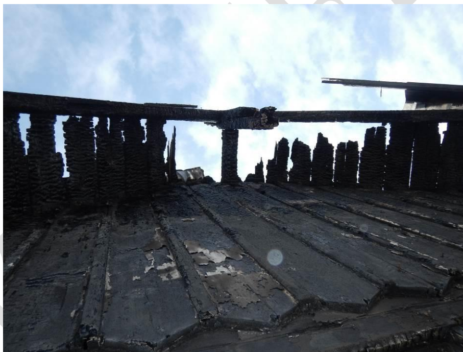
Foto 24: Pohled na první řadu krokví, doporučujeme nahradit materiálovou replikou
