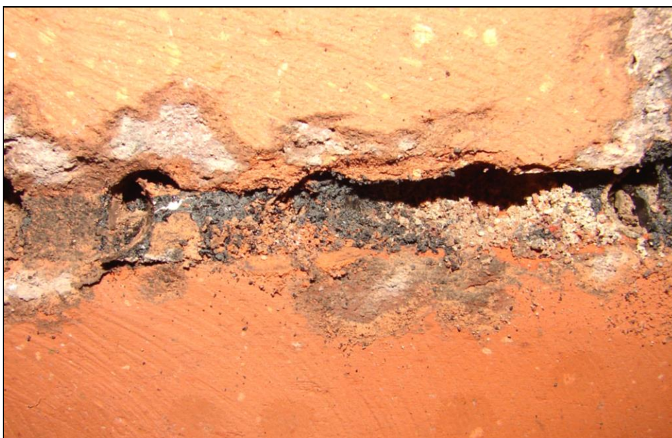
Foto 56: Oblouk 50; místo 50 B, za spárováním byl zjištěn uhelný prach, z toho vyplývá, že se zde skladovalo uhlí, a že spárování bylo provedeno dodatečně
