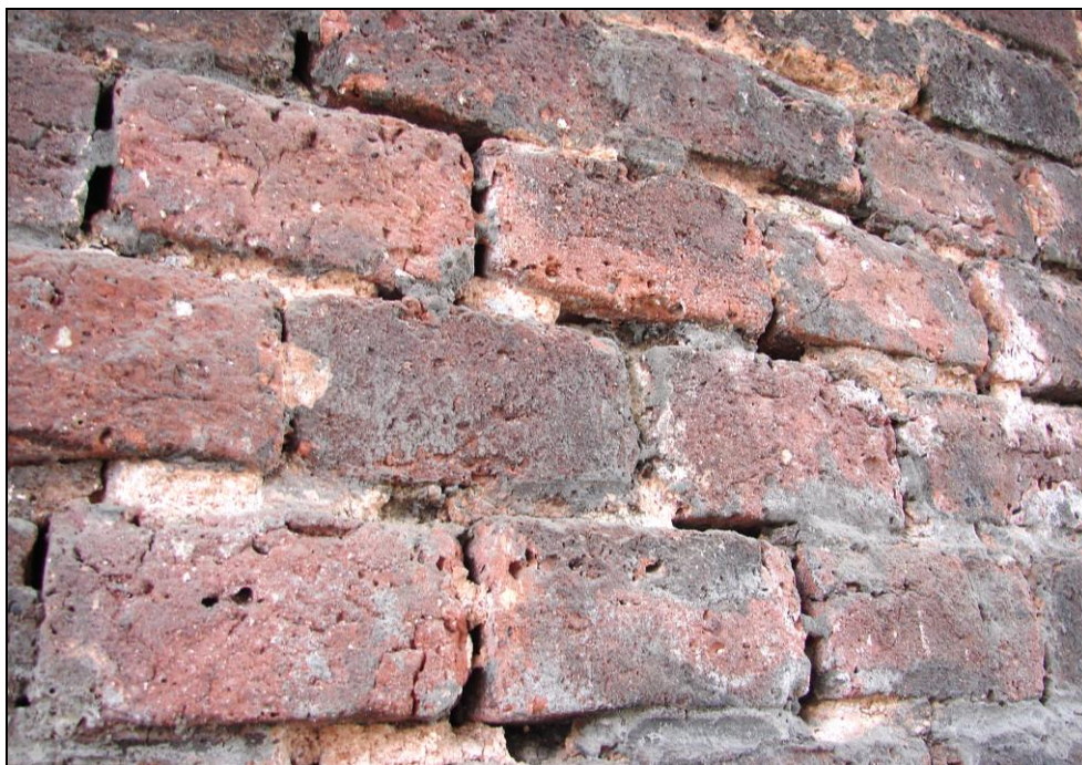
Foto 41: Oblouk 16; cihly bez vizuálně patrné degradace povrchu, odebrán vzorek 16 A pro destruktivní zkoušku pevnosti cihly v tlaku a provedeny nedestruktivní zkoušky pevnosti cihel a malty v tlaku
