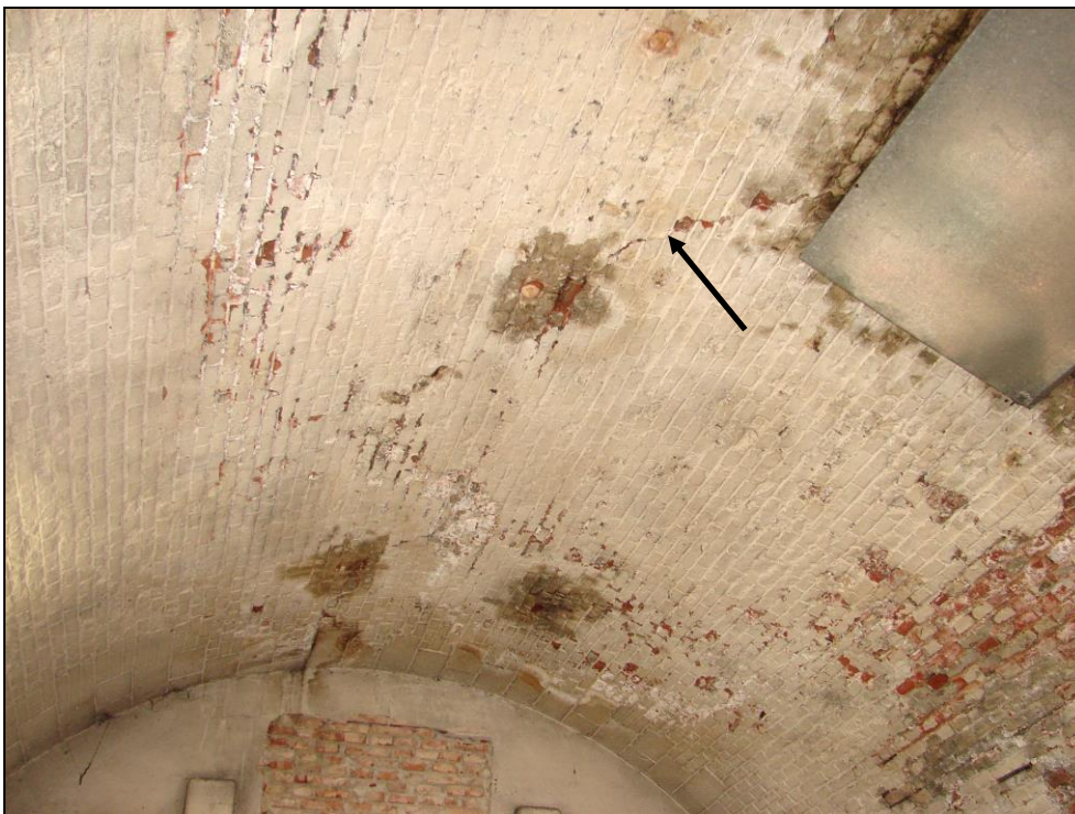
Foto 48: Oblouk 21; jediná zjištěná trhlina v oblouku (z přístupných oblouků)
