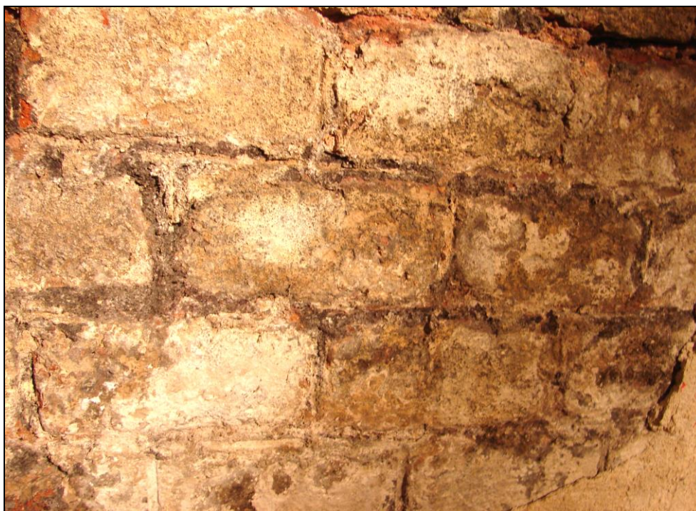
Foto 32: Oblouk 13; cihly bez vizuálně patrné degradace povrchu, odebrán vzorek 13 B pro destruktivní zkoušku pevnosti cihly v tlaku a provedeny nedestruktivní zkoušky pevnosti cihel a malty v tlaku
