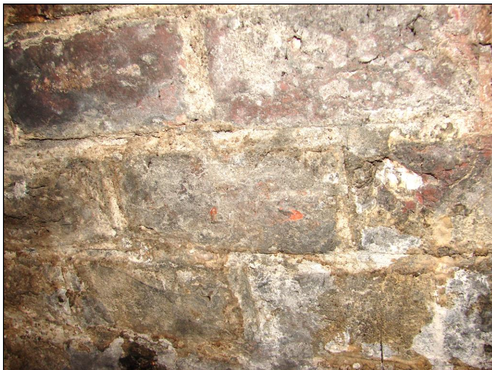
Foto 25: Oblouk 8; cihly bez vizuálně patrné degradace povrchu, odebrán vzorek 8 A pro destruktivní zkoušku pevnosti cihly v tlaku a provedeny nedestruktivní zkoušky pevnosti cihel a malty v tlaku
