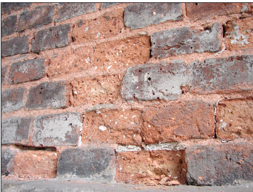
Foto 42: Oblouk 16; cihly s vizuálně patrnou degradací povrchu, odebrán vzorek 16 B pro destruktivní zkoušku pevnosti cihly v tlaku a provedeny nedestruktivní zkoušky pevnosti cihel a malty v tlaku
