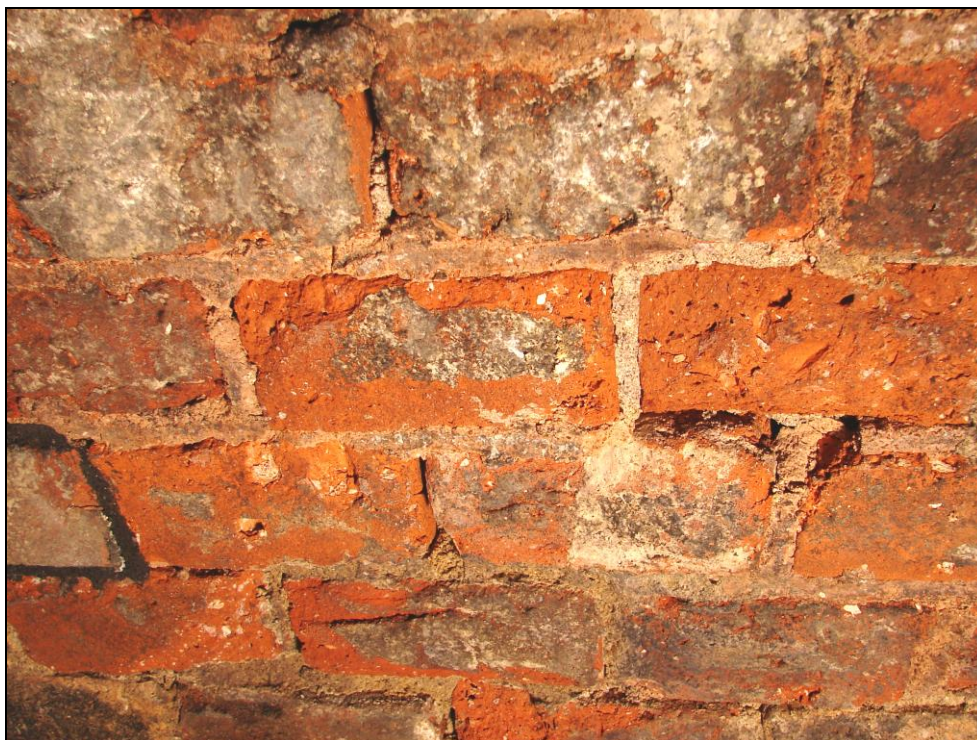
Foto 31: Oblouk 13; cihly s vizuálně patrnou degradací povrchu, odebrán vzorek 13 A pro destruktivní zkoušku pevnosti cihly v tlaku a provedeny nedestruktivní zkoušky pevnosti cihel a malty v tlaku
