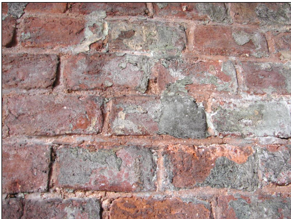
Foto 19: Oblouk 6; cihly bez vizuálně patrné degradace povrchu, odebrán vzorek 6 A pro destruktivní zkoušku pevnosti cihly v tlaku a provedeny nedestruktivní zkoušky pevnosti cihel a malty v tlaku
