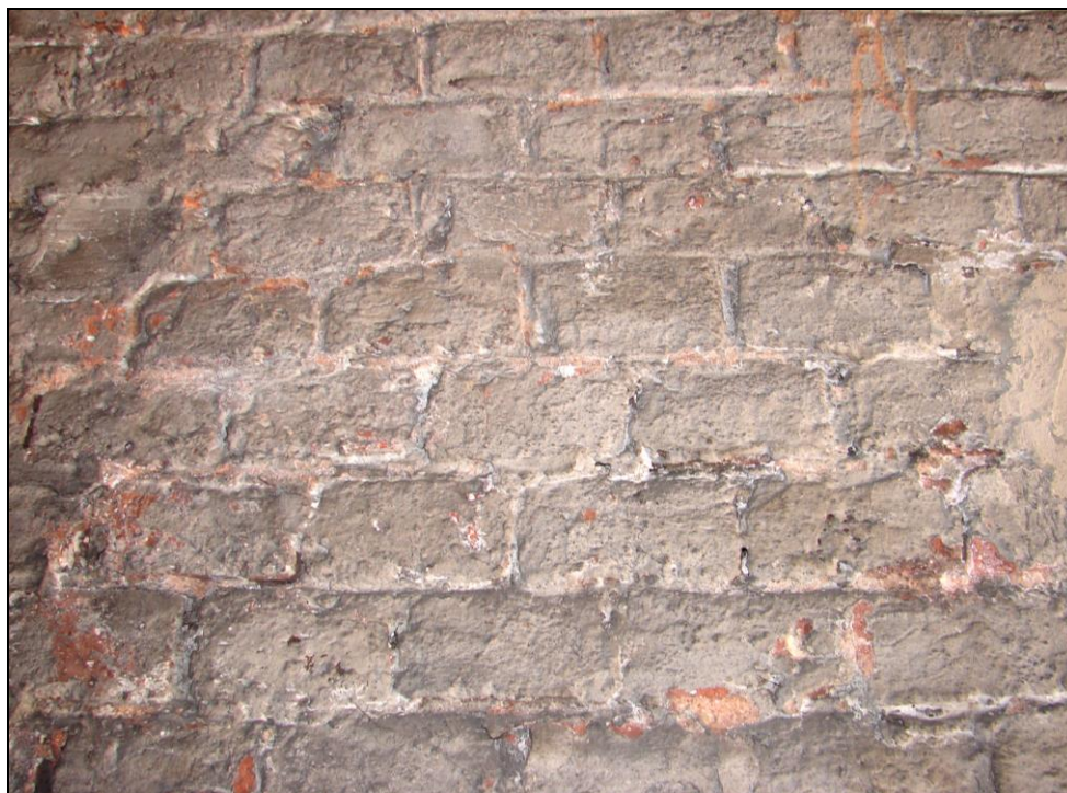
Foto 35: Oblouk 14; cihly bez vizuálně patrné degradace povrchu, odebrán vzorek 14 A pro destruktivní zkoušku pevnosti cihly v tlaku a provedeny nedestruktivní zkoušky pevnosti cihel a malty v tlaku
