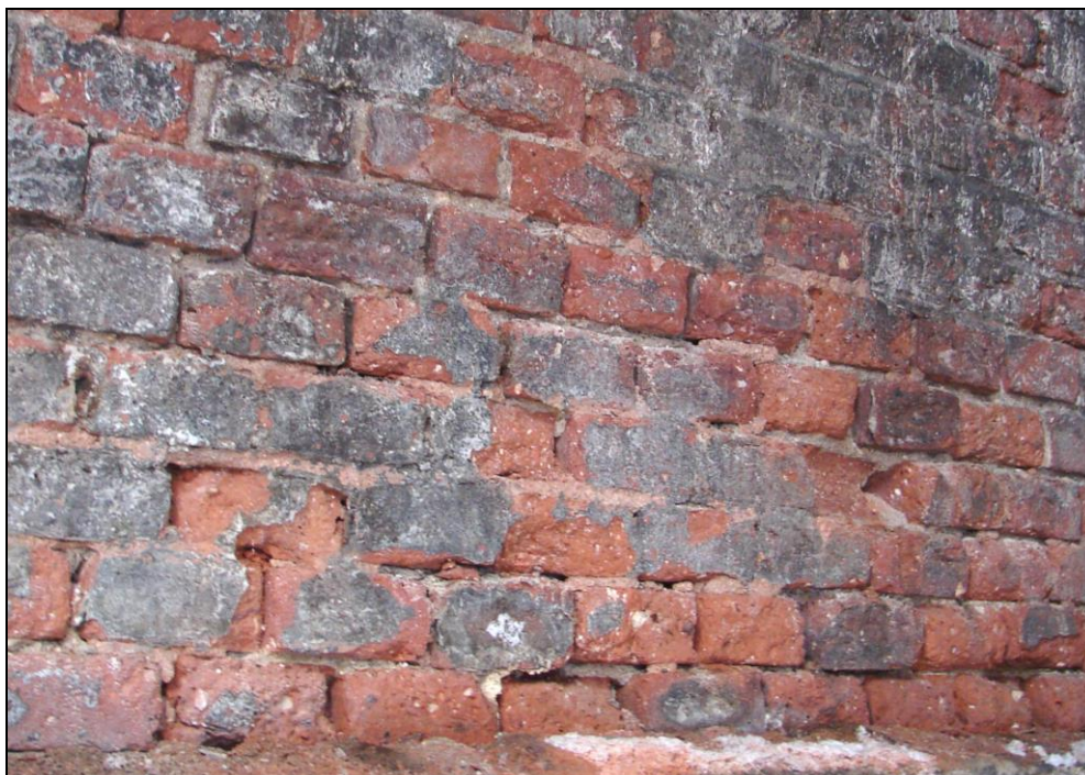
Foto 22: Oblouk 7; cihly s vizuálně patrnou degradací povrchu, odebrán vzorek 7 C a provedeny nedestruktivní zkoušky pevnosti cihel a malty v tlaku
