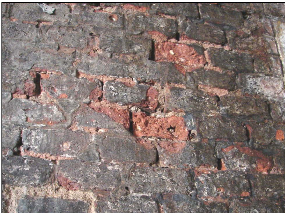
Foto 36: Oblouk 14; cihly s vizuálně patrnou degradací povrchu, odebrán vzorek 14 B pro destruktivní zkoušku pevnosti cihly v tlaku a provedeny nedestruktivní zkoušky pevnosti cihel a malty v tlaku
