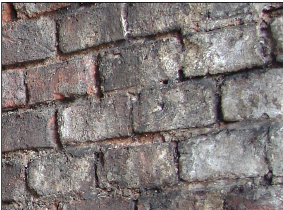
Foto 21: Oblouk 7; cihly bez vizuálně patrné degradace povrchu, odebrán vzorek 7 B pro destruktivní zkoušku pevnosti cihly v tlaku a provedeny nedestruktivní zkoušky pevnosti cihel a malty v tlaku
