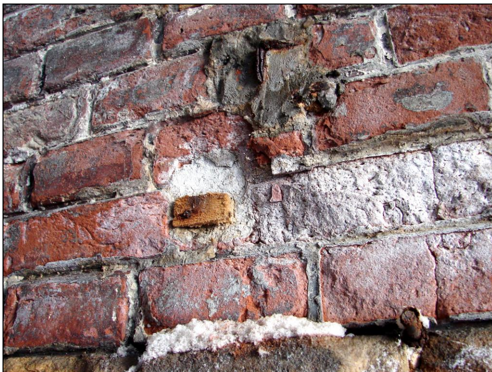
Foto 61: Oblouk 52; cihly s vizuálně patrnou degradací povrchu, odebrán vzorek 52 A pro destruktivní zkoušku pevnosti cihly v tlaku a provedeny nedestruktivní zkoušky pevnosti cihel a malty v tlaku
