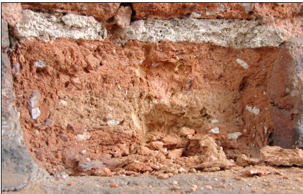
Foto 43: Oblouk 16; charakter cihelného střepu v oblasti odběru vzorku 16 B (detail z předcházející foto)
