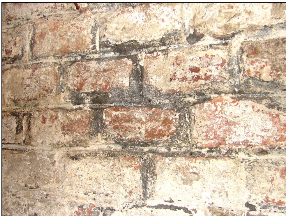
Foto 15: Oblouk 5; cihly bez vizuálně patrné degradace povrchu, odebrán vzorek 5 A pro destruktivní zkoušku pevnosti cihly v tlaku a provedeny nedestruktivní zkoušky pevnosti cihel a malty v tlaku
