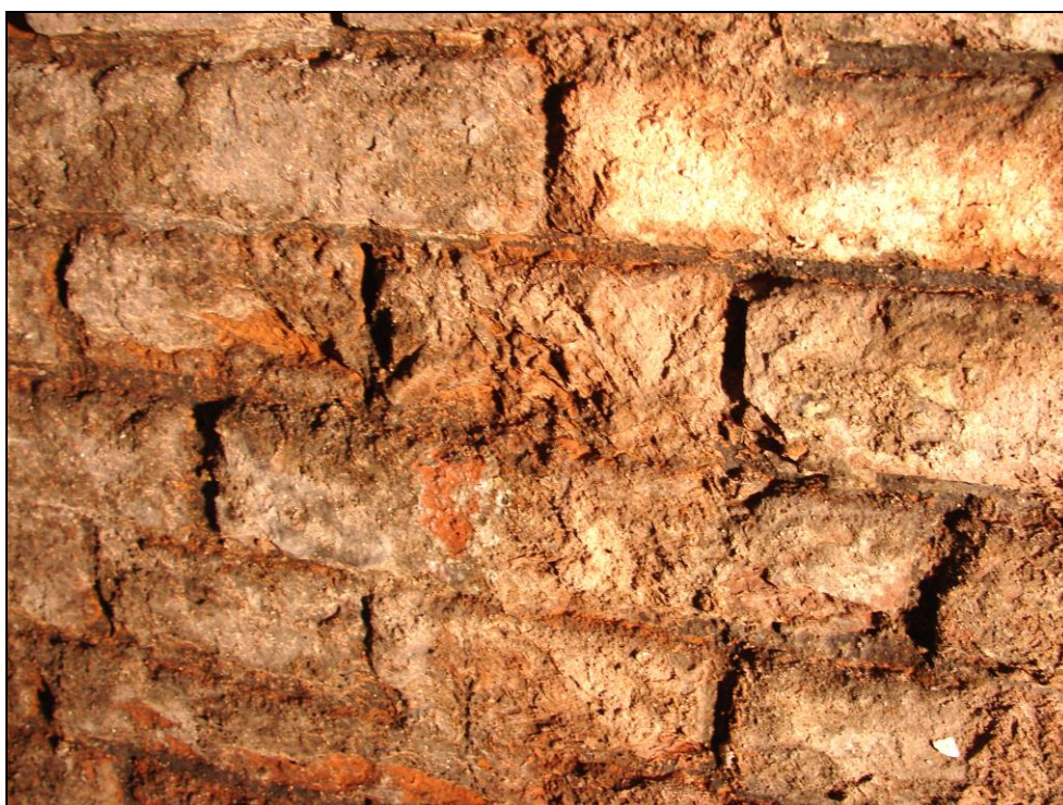
Foto 54: Oblouk 50; cihly s vizuálně patrnou degradací povrchu, odebrán vzorek 50 A pro destruktivní zkoušku pevnosti cihly v tlaku a provedeny nedestruktivní zkoušky pevnosti cihel a malty v tlaku
