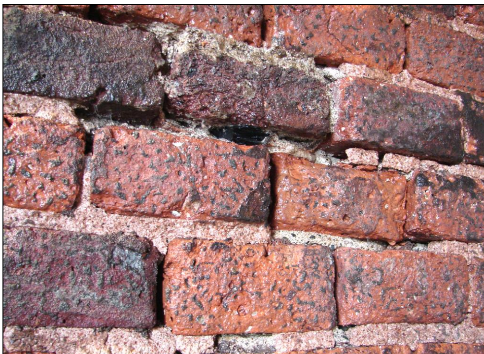
Foto 28: Oblouk 8; cihly s vizuálně patrnou degradací povrchu, odebrán vzorek 8 C pro destruktivní zkoušku pevnosti cihly v tlaku a provedeny nedestruktivní zkoušky pevnosti cihel a malty v tlaku
