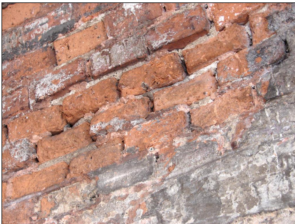
Foto 46: Oblouk 19; cihly s vizuálně patrnou degradací povrchu, odebrán vzorek 19 A pro destruktivní zkoušku pevnosti cihly v tlaku a provedeny nedestruktivní zkoušky pevnosti cihel a malty v tlaku
