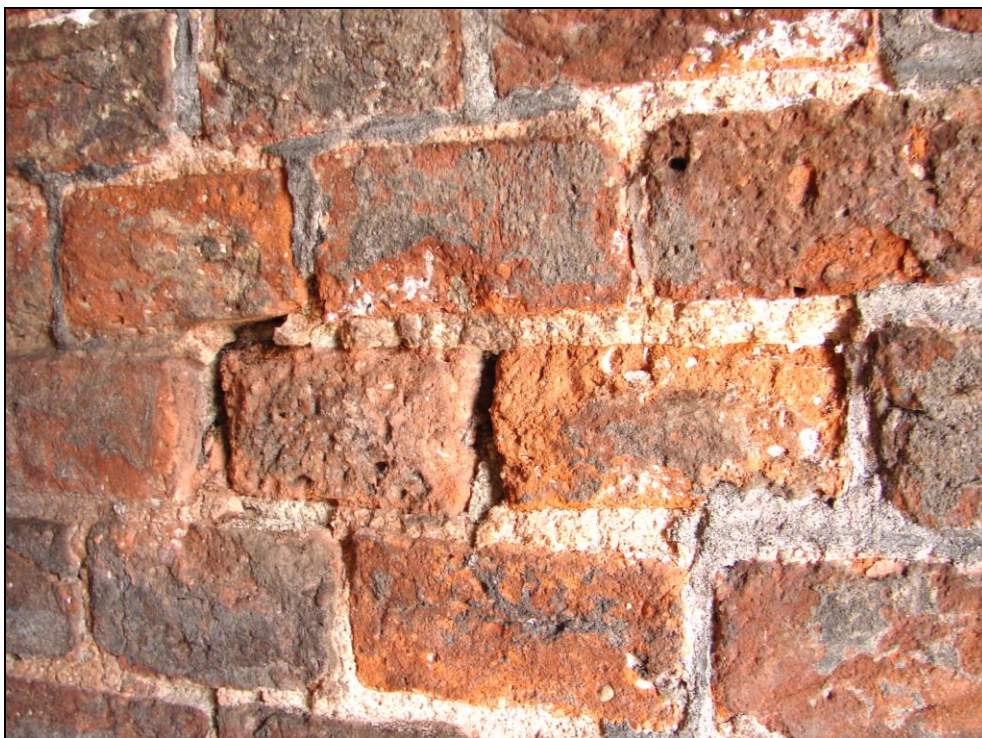
Foto 27: Oblouk 8; cihly s vizuálně patrnou degradací povrchu, odebrán vzorek 8 B pro destruktivní zkoušku pevnosti cihly v tlaku a provedeny nedestruktivní zkoušky pevnosti cihel a malty v tlaku
