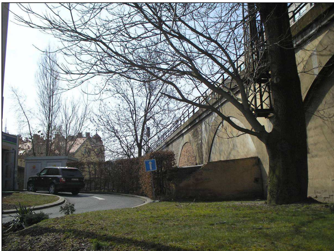
Obr. Mohutný pajasan může ohrozit most i trakční vedení (dřeviny A21)
