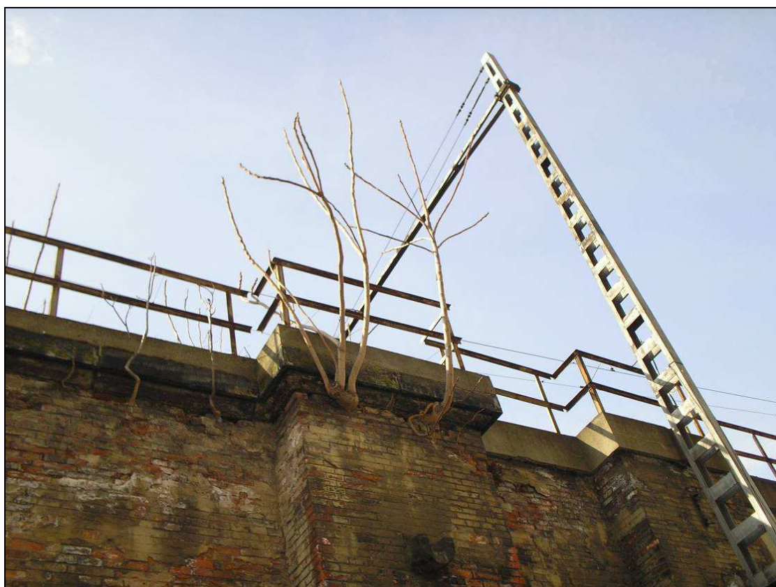
Obr. pajasany vyrůstají z vlastního mostu (dřeviny B4)
