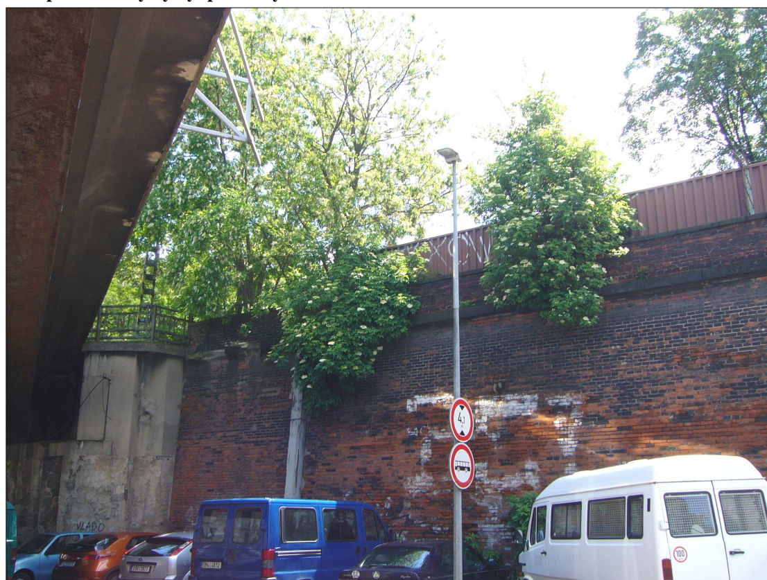
Obr. Náletové dřeviny narůstající z tělesa mostu
