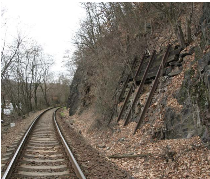
Obr. 7 SO-02 Již nevyhovující zajištění suťového pole
