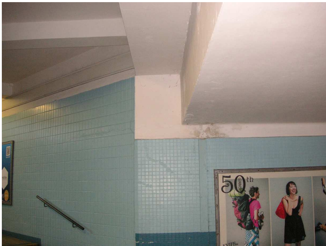
Obr. č. 5 Původní obklad přemalovaný barvou zakrývající i mnohé praskliny a poruchy.
