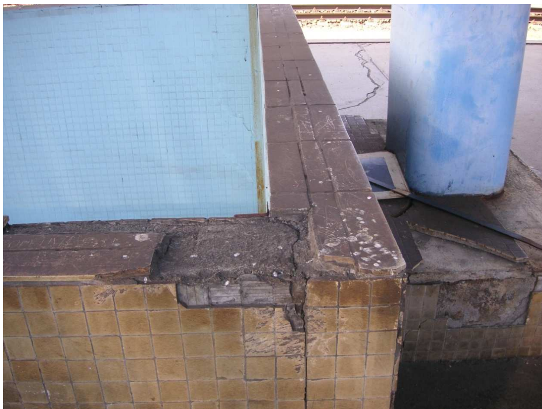
Obr. č. 6 poruchy obkladu schodišťových zdí na nástupišti
