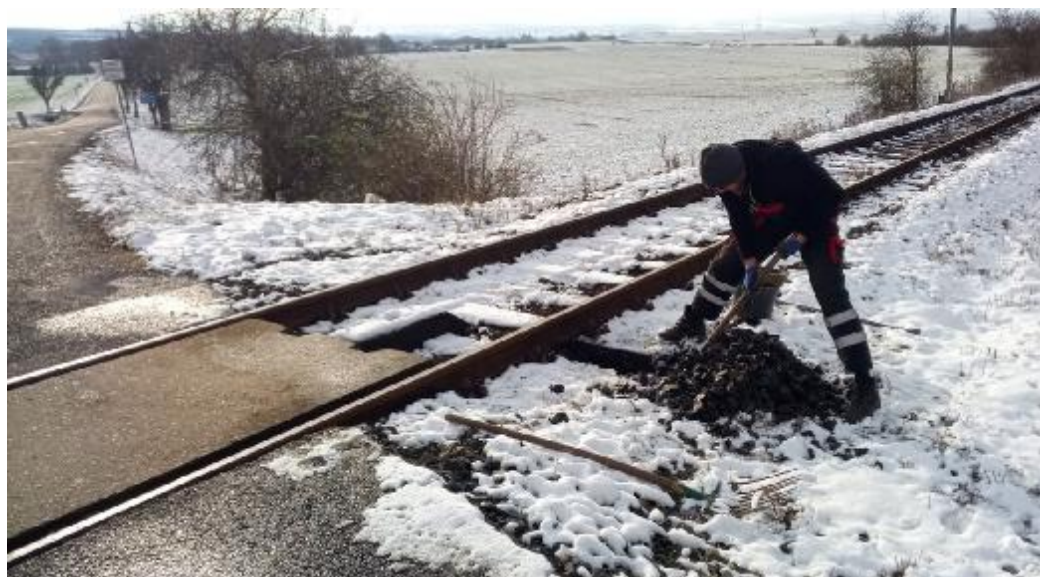
Obr. 4 Pohled na místo provádění ručně kopané sondy K1 v místě konstrukce žel. přejezdu P1720
