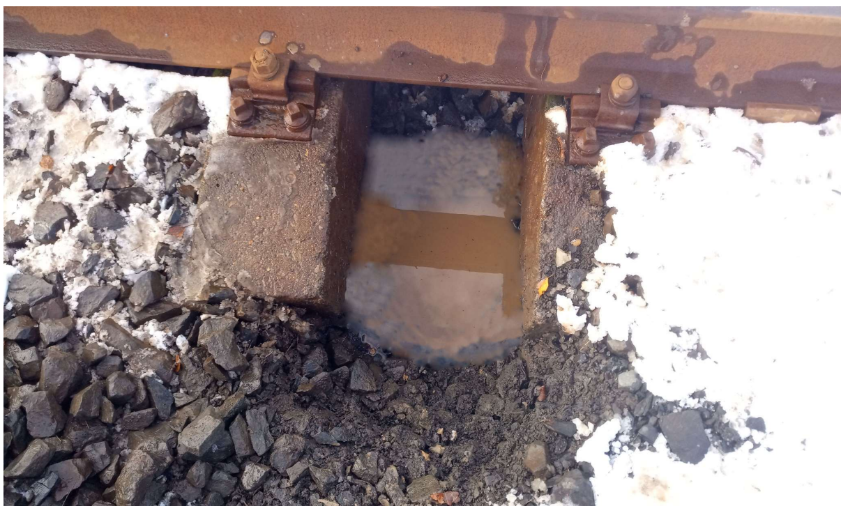
Obr. 4 Sonda byla v průběhu kopání zaplavena (v důsledku nefunkčního odvodnění – voda neodtékala)
