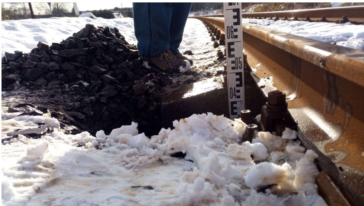
Obr. 3 Aktuální úroveň SD 0/32 (44 cm pod úložnou plochou pražce)
