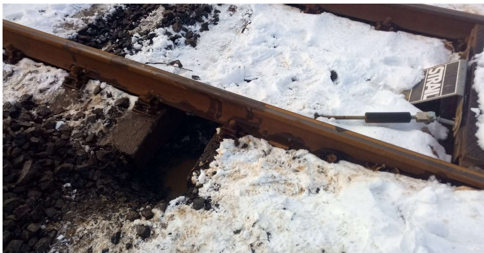
Obr. 3 Pohled na místo realizace ručně kopané sondy K1 u přejezdu P3550
