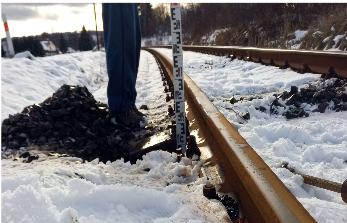
Obr. 2 Aktuální hloubka štěrkového lože (39 cm pod úložnou plochou pražce)
