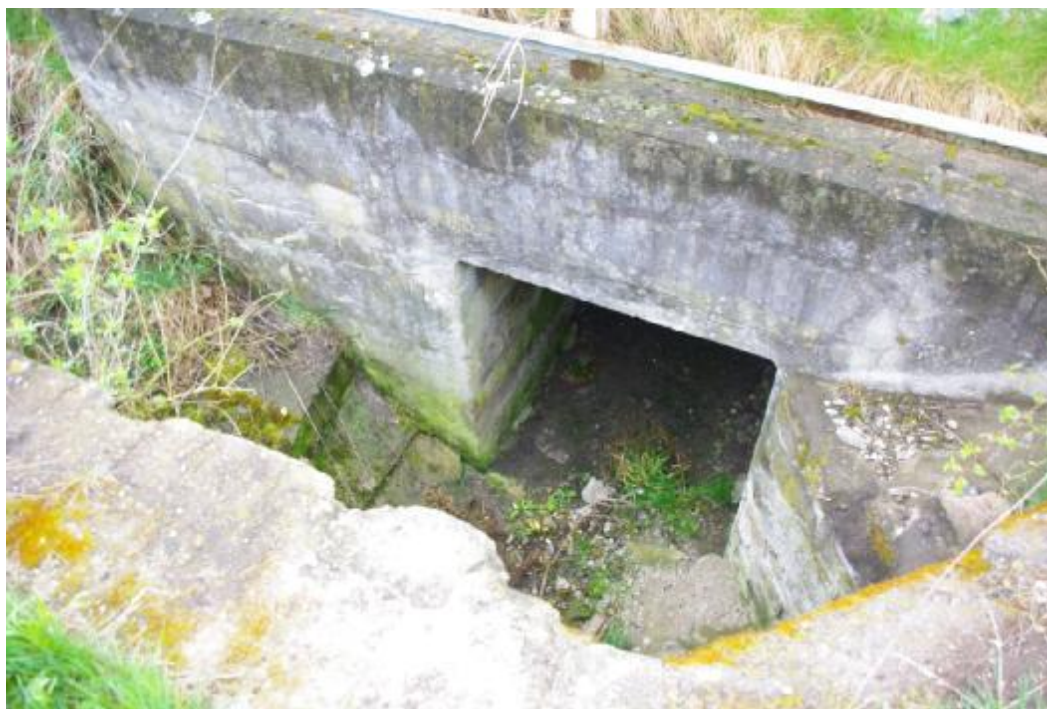
Obr. 3 Pohled na propustek pod žel. tratí
