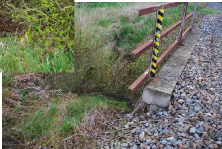
Obr. 5 Navazující konstrukce propustku pod polní cestou a část otevřeného příkopu (občasně vodoteče) navazující na propustek (směr SZ)
