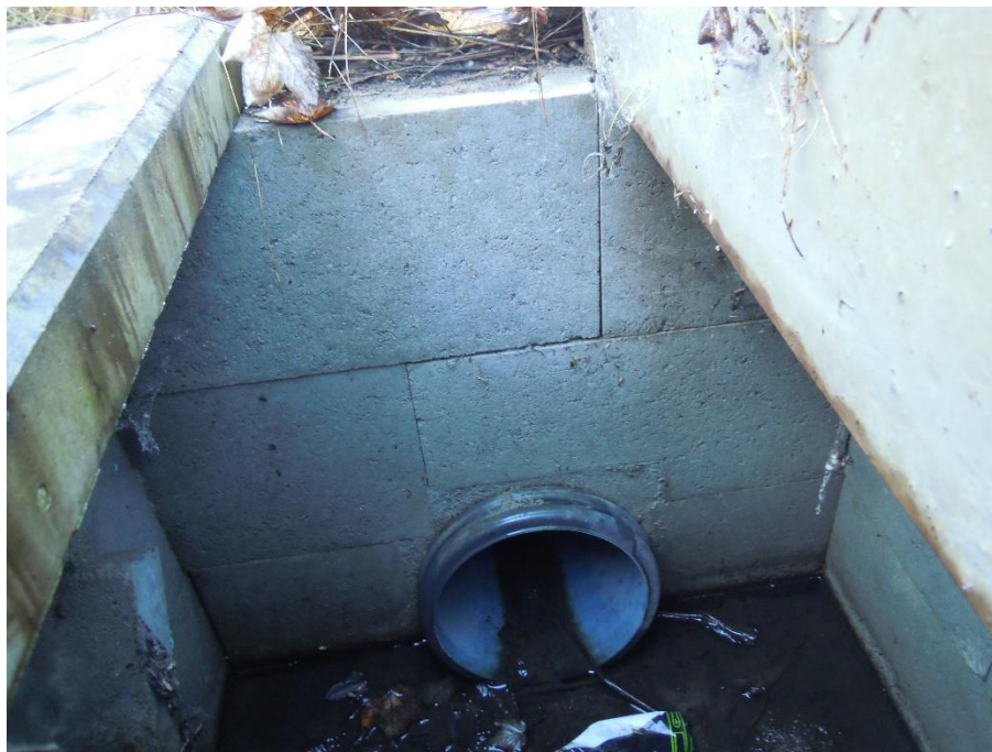
Obr. 2 - Napojení jímky na systém odvodnění
