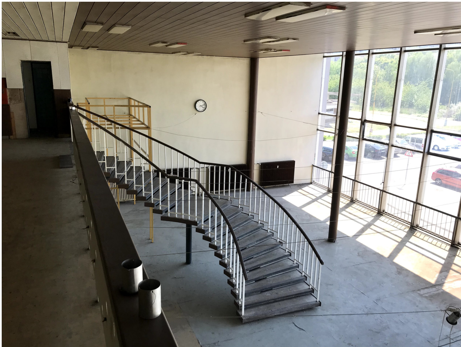
Část A - schody v bývalém restauračním provozu. Zdroj: SŽ, nedatováno.
