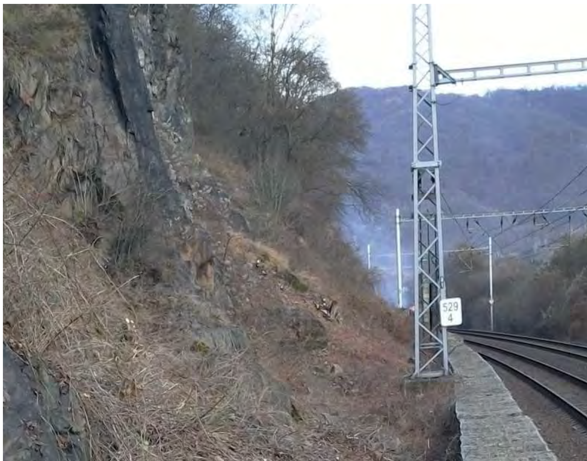
Obr. 9 – od km cca 529,380 je za zárubní zdí již nedostatečný akumulací prostor
