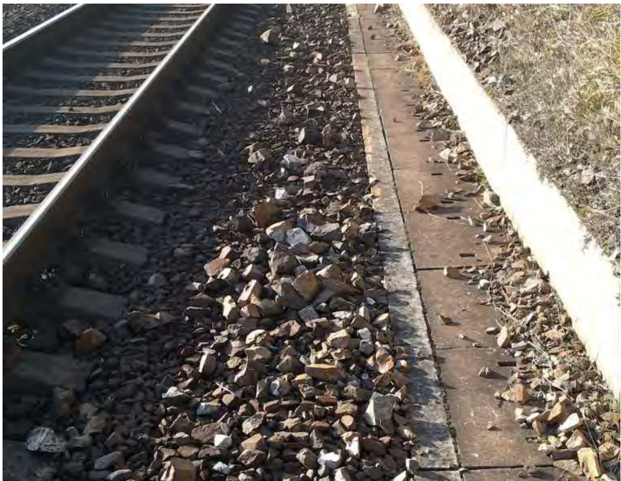
Obr. 8 – napadané kameny při patě svahu až do kolejiště
