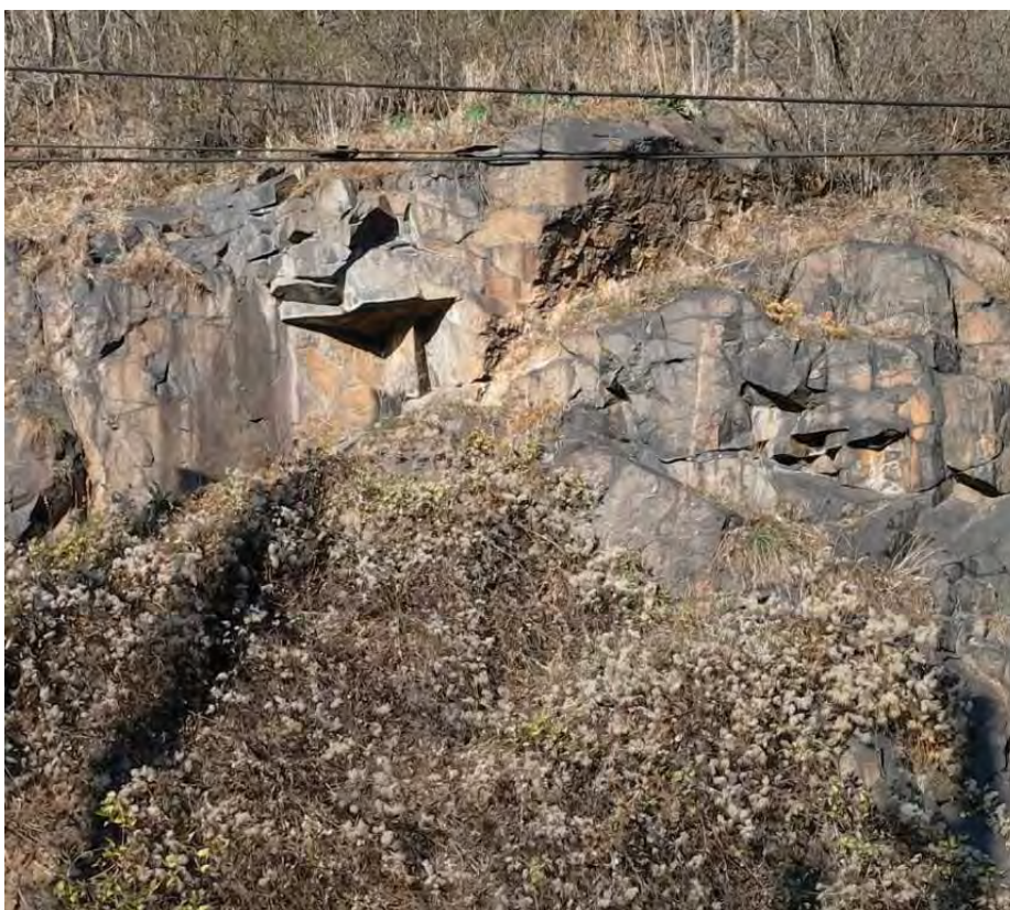
Obr. 7 – Skalní stěna v km cca 528,838-528,900, na skalní stěně jsou patrná místa s čerstvě vypadlými bloky
