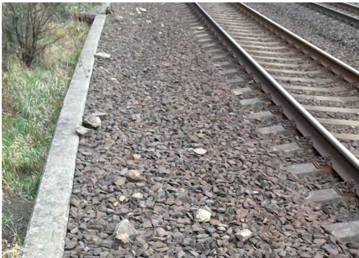
Obr. 5 – Zanesený podélný odvodňovací příkop a napadané kameny v kolejišti
