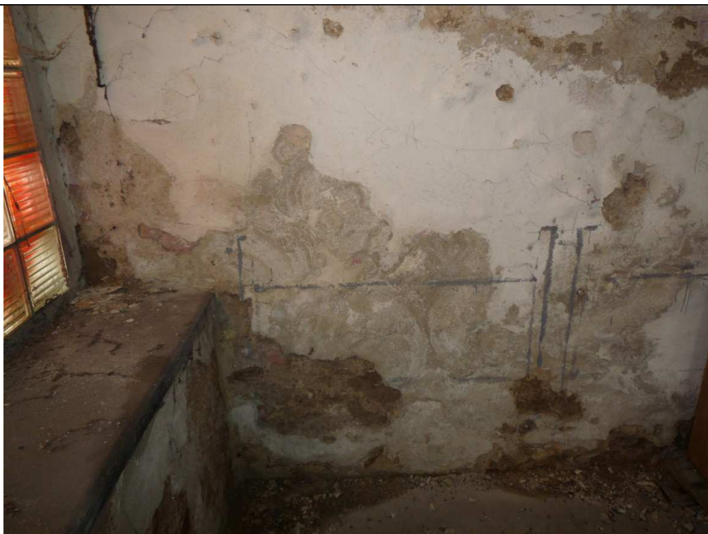
Mapy na stěně způsobené vlhkostí v JV části budovy – místnost Rozvodny NN SŽDC
