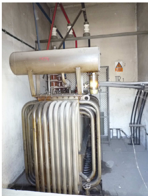
Obr. 21a – Stanoviště transformátoru T1 - SŽDC s olejovým transformátorem 22/0,4 kV, 400 kVA s kabelovými vývody nn. Vzadu jsou statické kondenzátory pro kompenzaci proudu naprázdno.
