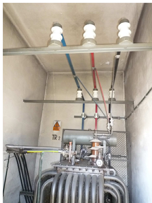
Obr. 22b – Stanoviště transformátoru T2 - SŽDC s olejovým transformátorem 22/0,4 kV, 400 kVA s pasovým přívodním vedením 22 kV na podpěrkách
