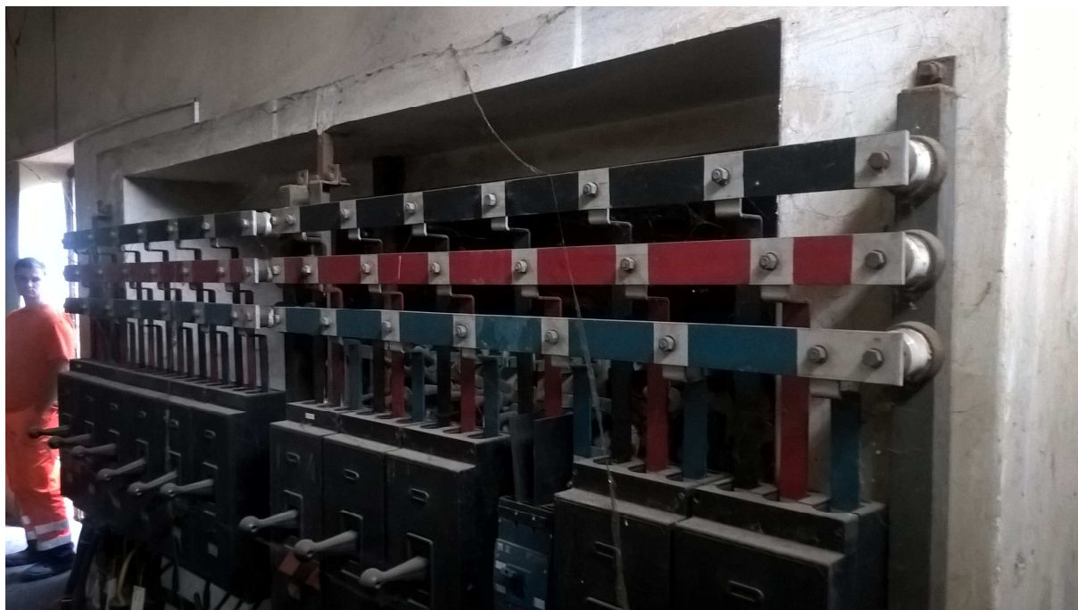
Obr. 11 – Dělené přípojnice rozvaděče nn PRE Di
