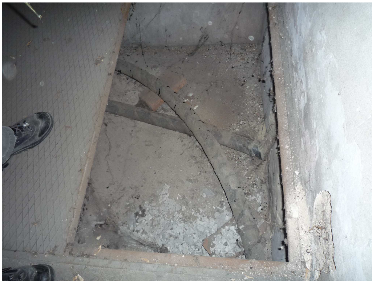
Obr. 14 –Přívodní kabely 22 kV – PRE-Di v zakrytém kabelovém kanálu
