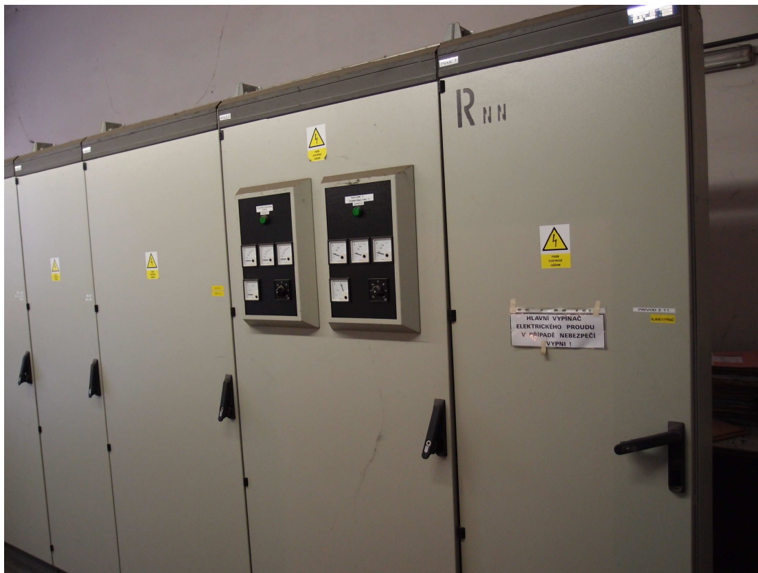
Obr. 19 – Pole rozvaděče nn SŽDC v zadní části rozvodny nn – pole 1- 4
