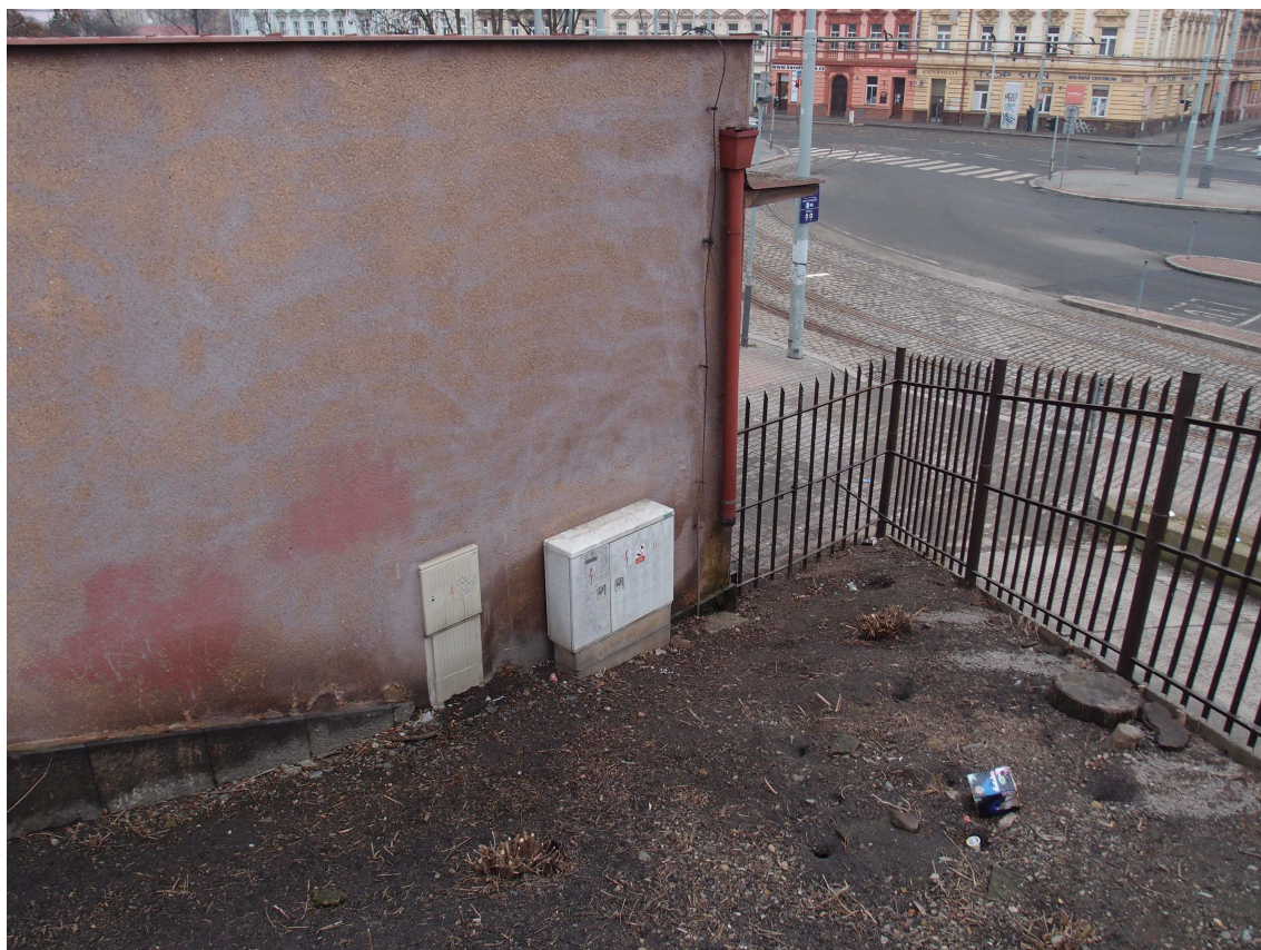
Obr. 5 – Levá boční strana transformovny TS1 (TS795) v žst Praha-Smíchov s kabelovou skříní KS1 (pro kabely k záložnímu zdroji el. energie a pilířem pro městské venkovní osvětlení (MVO) ve správě Eltodo.
