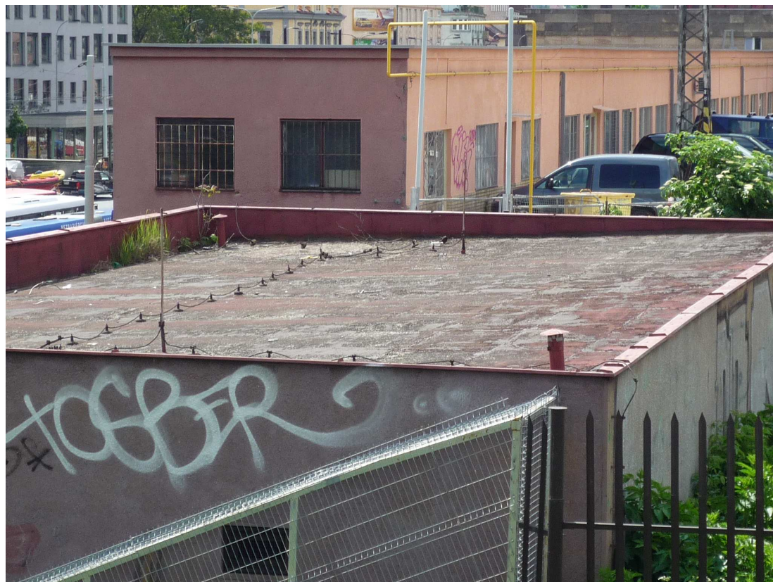
Obr. 7 – Střeška transformovny TS1 (TS795) v žst Praha-Smíchov s jímací soustavou bleskosvodu a větracími komínky v rozích střechy a oplechování atiky
