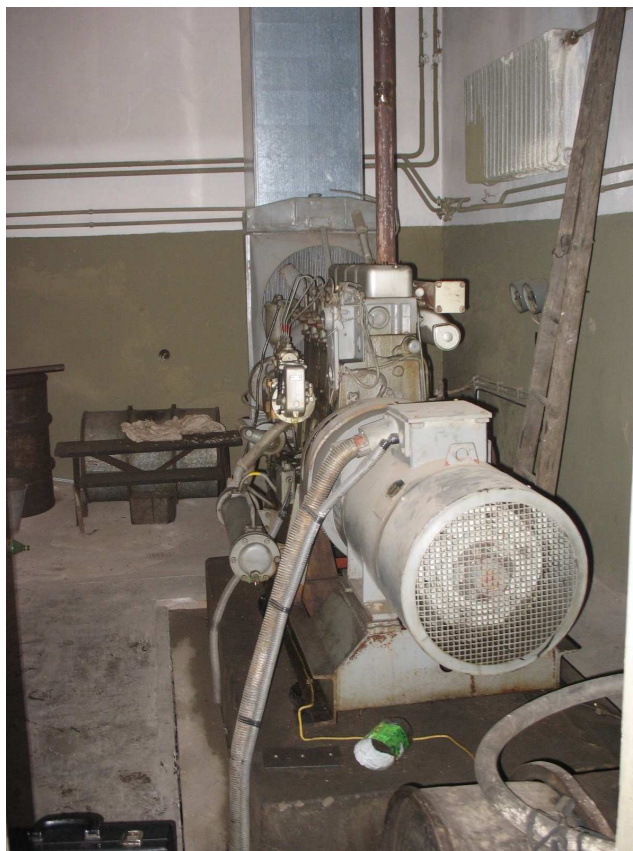
Obr. 23 – Pohled na záložní zdroj elektrické energie (ZZEE)– dieselagregát od vstupních dveří.
