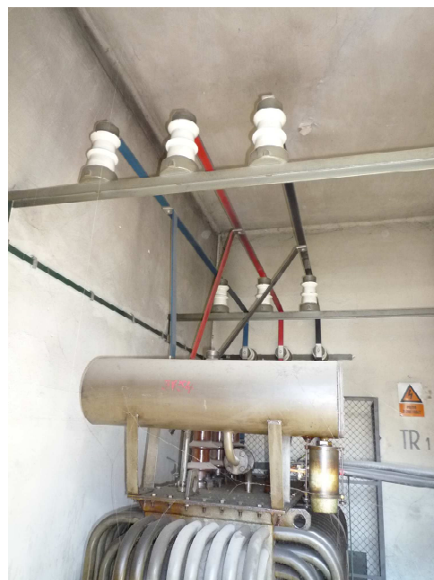
Obr. 21b – Stanoviště transformátoru T1 - SŽDC s olejovým transformátorem 22/0,4 kV, 400 kVA s pasovým přívodním vedením 22 kV na podpěrkách
