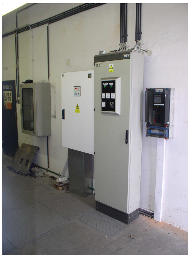
Obr. 20 – Rozvaděč zajištěné sítě - RZS, Kompenzační rozvaděč RK, a vzadu před dveřmi do rozvodny 22 kV elektroměrový rozvaděč s měřicí soupravou PRE-Di. Vpředu je elektroměrová rozvodnice pro měření vývodu z rozvaděče RZS do stavědlové ústředny (na zab. zařízení)
