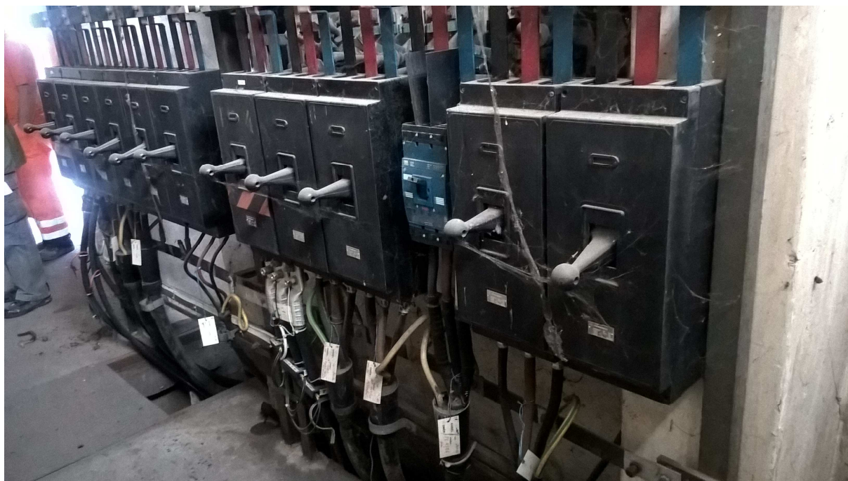
Obr. 12 – Přístrojové vybavení rozvaděče nn PRE-Di, Vlevo část rozvaděče nn pro transformátor T3 s přívodem a 5 vývody s jističi J2UX, vpravo část rozvaděče pro transformátor T4 s přívodem a 5 vývody s jističi J2UX (3. jistič nahrazen novým typem Modeion BH 630)
