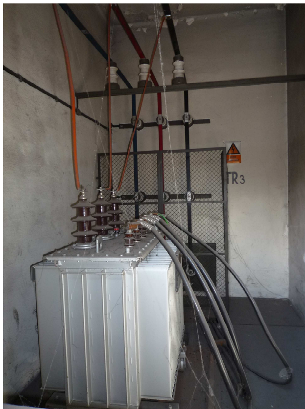
Obr. 15 –Stanoviště transformátoru PRE-Di – T3 - olejový hermetizovaný transformátor 22/0,4 kV, 400 kVA
