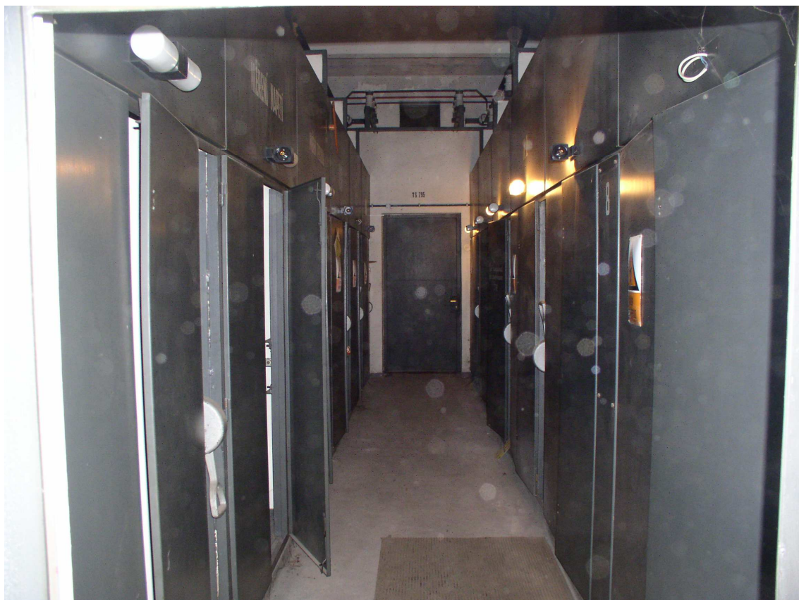
Obr. 17 – Společná kobková rozvodna 22 kV. Vzadu část PRE-DI s přechodem přípojníc 22 kV, vpředu část SŽDC. Chodba šířky pouze 1450 mm!
