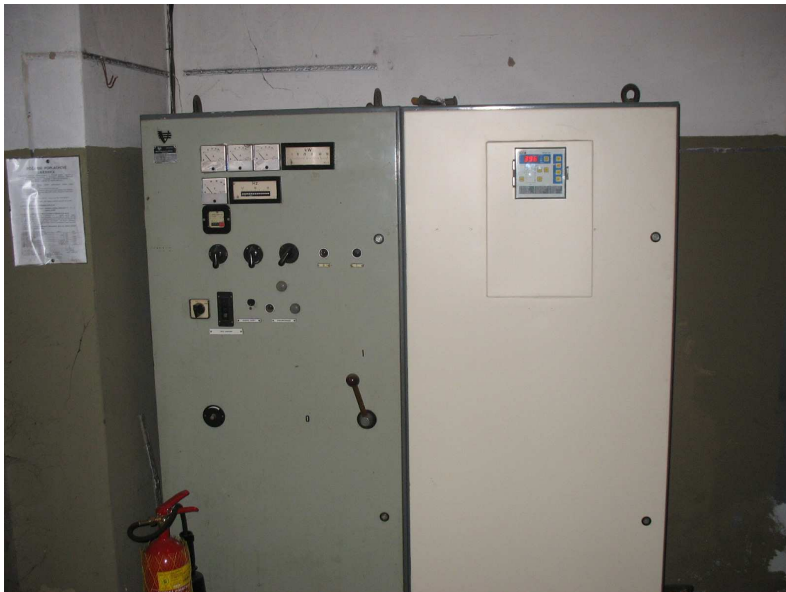
Obr. 26 – Rozvaděče ZZEE – dieselařegát
