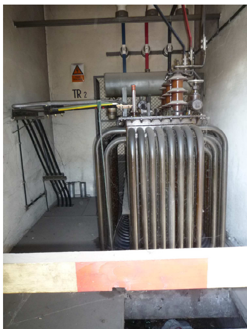
Obr. 22a – Stanoviště transformátoru T2 - SŽDC s olejovým transformátorem 22/0,4 kV, 400 kVA s kabelovými vývody nn. Vzadu jsou statické kondenzátory pro kompenzaci proudu naprázdno.
