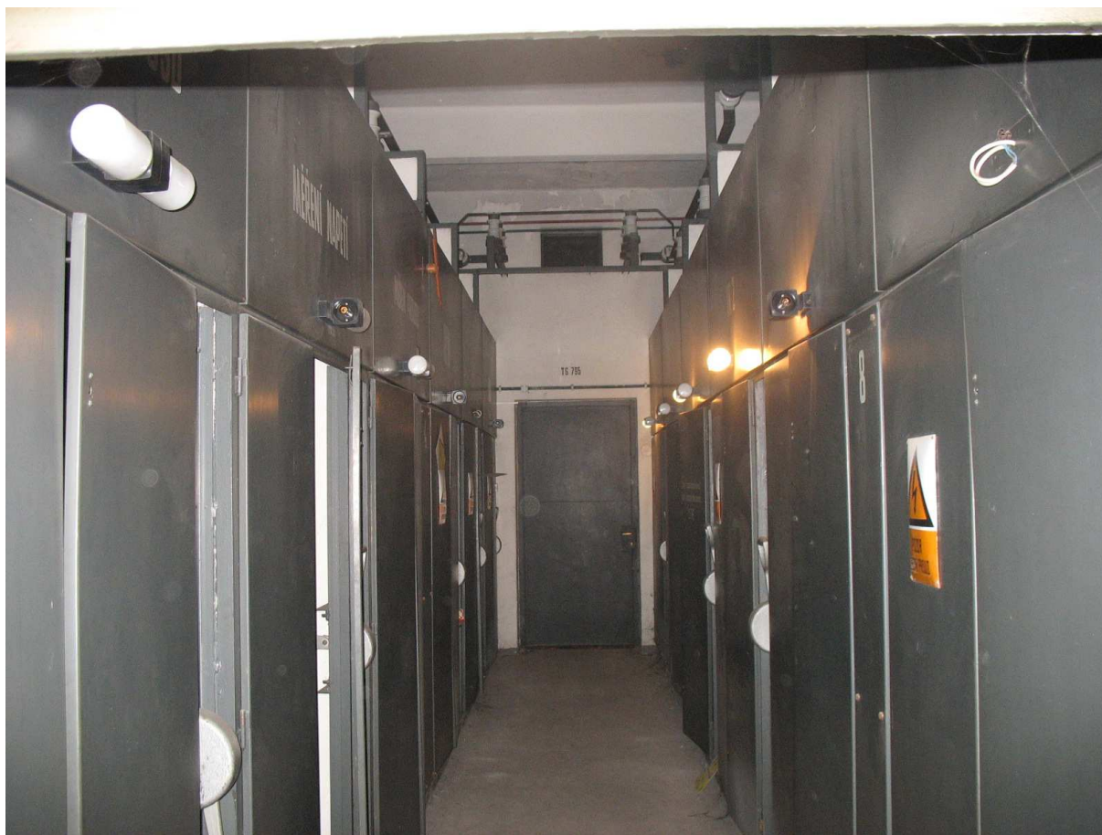
Obr. 9 – Společná kobková rozvodna 22 kV. Vzadu přechod přípojníc 22 kV v části PRE-Di
