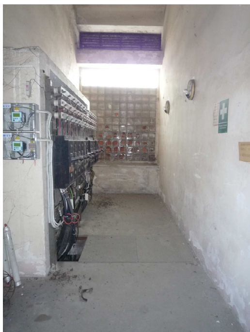
Obr. 10a – Rozvaděč nn části PRE-Di PRE-Di. Vpravo nástěnné rozvodnice s analyzátory sítě PRE-Di
