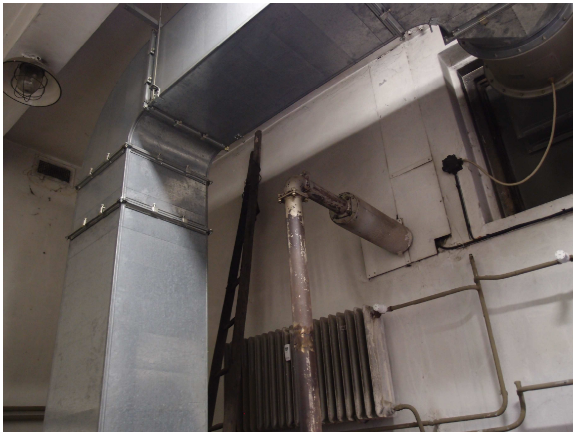
Obr. 25 – Vzduchotechnika a vyvedení spalin ZZEE– dieselagregátu 2
