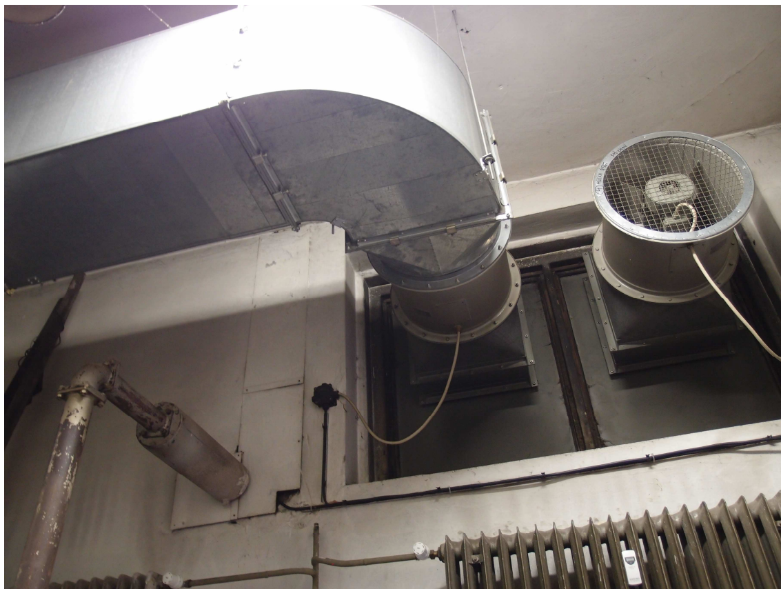
Obr. 25 – Vzduchotechnika a vyvedení spalín ZZEE– dieselařegátu 3
