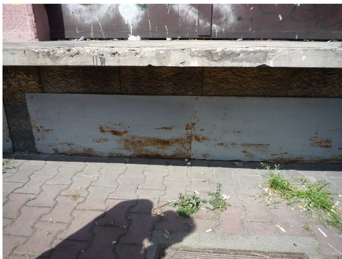
Obr.8 – Zaplechované větrací otvory transformátorů SŽDC. Vpředu dole je zakrytý vstup do společné havarijní olejové jímky na 100% oleje největšího z transformátorů osazených na stanovištích transformátorů T1 až T4 a z kobek rozvodny 22 kV
