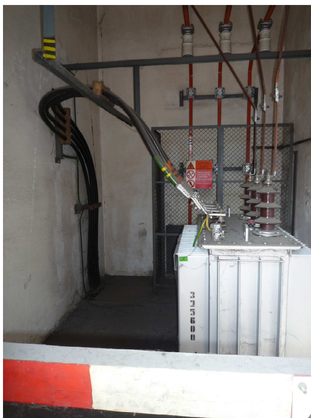
Obr. 16 –Stanoviště transformátoru PRE-Di - T4 - olejový hermetizovaný transformátor 22/0,4 kV, 400 kVA
