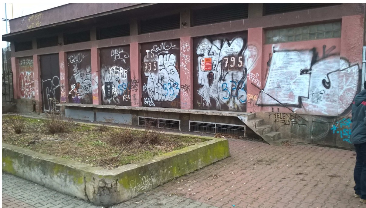
Obr. 2 – Celkový pohled na transformovnu TS1 (TS795) v přednádraží žst Praha-Smíchov v 02/2017. Vpředu květník, pod rampou transformovny nasávací větrací otvory pro transformátory, nad dveřmi větrací otvory se žaluziemi (též viz obr. č. 4)
