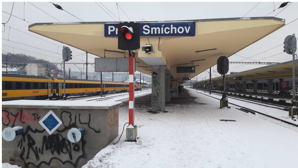
(obr. 1.3) Demolice zastřešení nástupiště č. 3 (kolize s novým kolejovým řešením)
