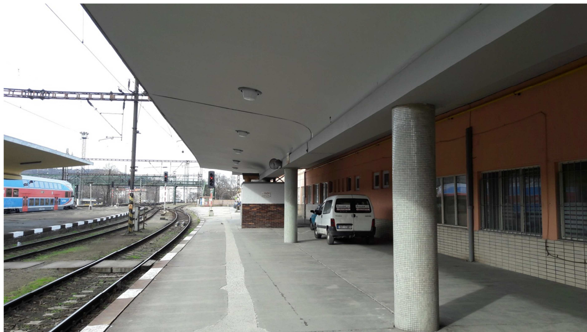
(obr. 1.4) Demolice zastřešení nástupiště č. 1 (kolize s budoucí lávkou)
