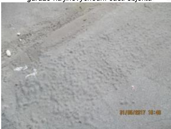
Obr. 98: Detail degradované asfaltové krytiny
