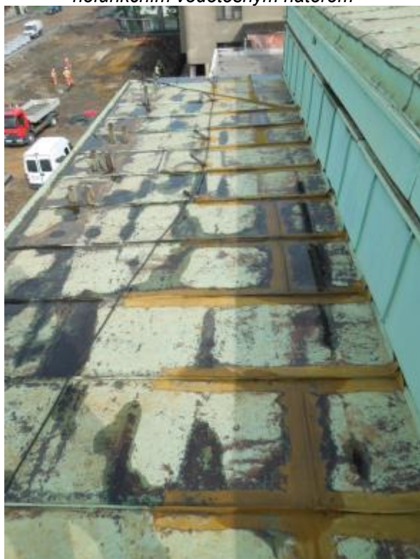
Obr. 120: Téměř nulový sklon malé stříšky s falcovanými měděnými plechy – tvorba kaluží
