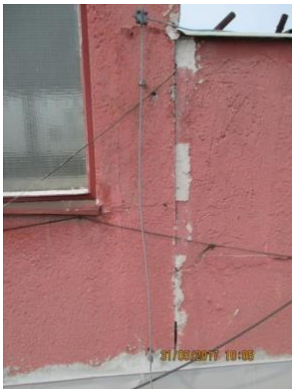
Obr. 192: Dilatace na dvou výškových úrovních odbavovací haly
