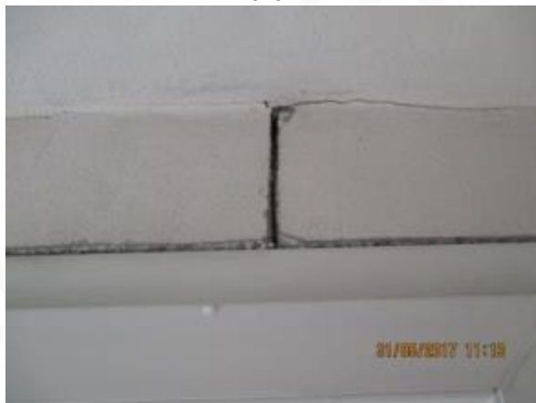
Obr. 252: Tepelný most v nadpraží rohového okna – nevhodné vnitřní částečné zateplení
