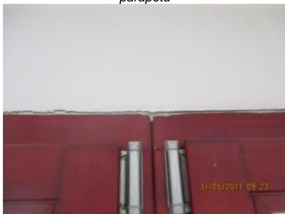
Obr. 184: Prasklina v interiéru v oblasti nadpraží
