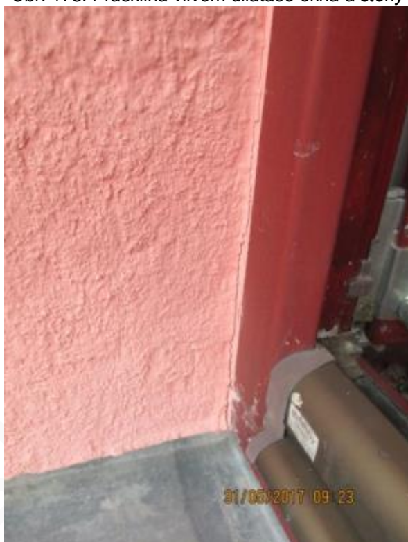
Obr. 180: Prasklina vlivem dilatace okna a stěny
