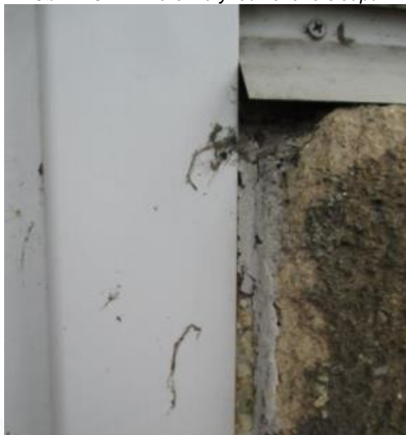
Obr. 247: Absence vnějšího uzávěru připojovací spáry- riziko zatečení (pozn. Jedná se o krytý prostor lodžie – pouze při silném větrem hnaném dešti)
