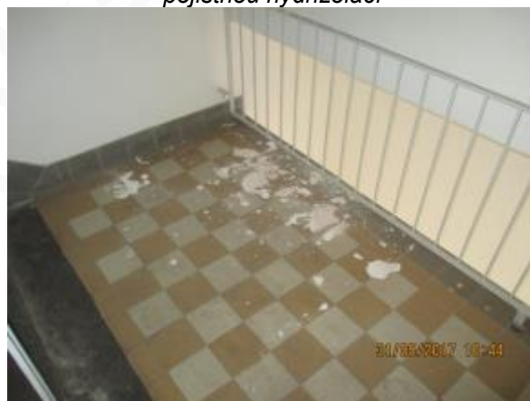
Obr. 127: : Omítka na schodišti na půdou signalizující zátoky před výměnou krytiny
