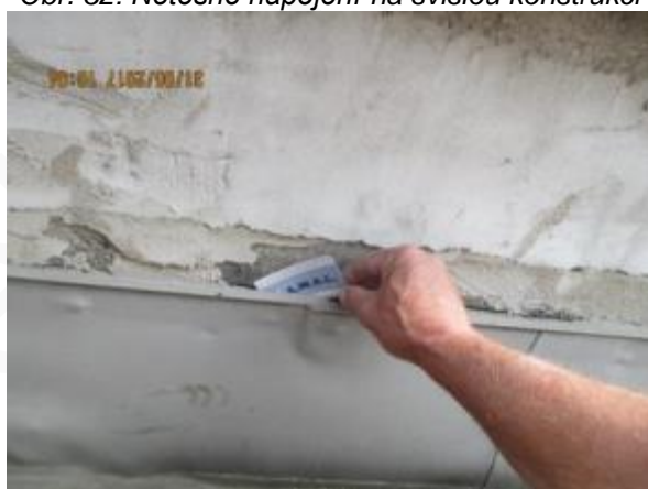
Obr. 34: Netěsné napojení na svislou konstrukci
