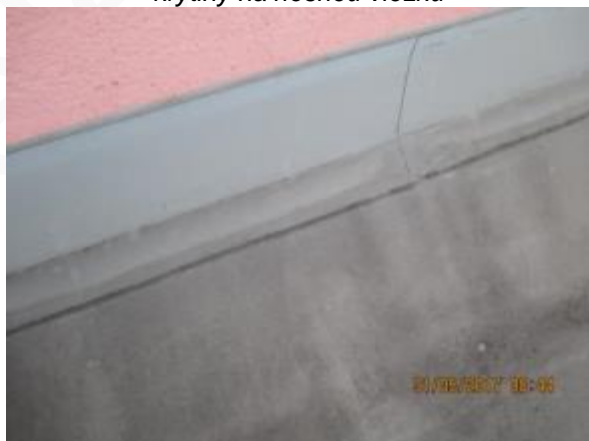
Obr. 16: Stávající PVC-P krytina – degradace krytiny na nosnou vložku
