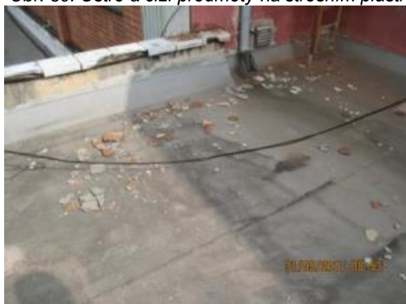
Obr. 62: Ostré a cizí předměty na střešním plášti
