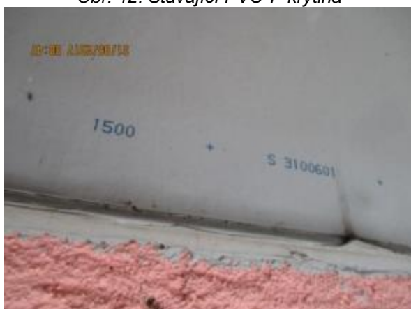
Obr. 14: Stávající PVC-P krytina
