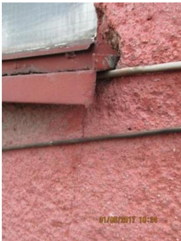
Obr. 158: Praskliny omítky v místě parapetu
