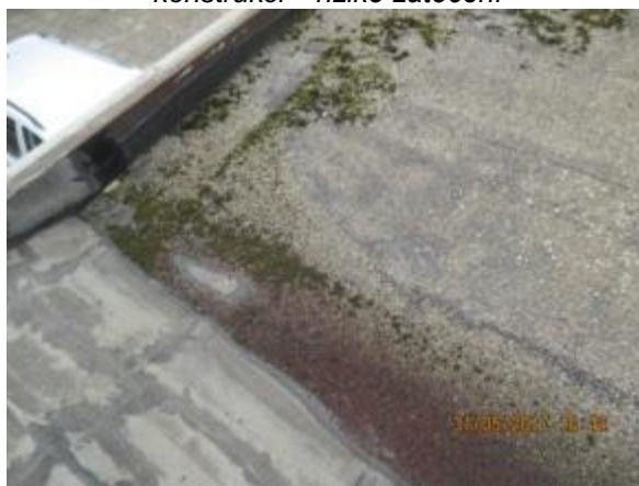
Obr. 99: Detail degradované asfaltové krytiny
