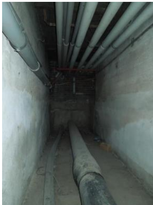
Obr. 262: Degradované omítky v suterénu předávací stanice
