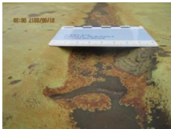
Obr. 113: Degradace krytiny z falcovaných měděných plechů
