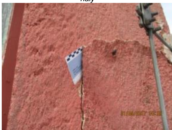
Obr. 193: Degradovaná omítka s trhlinami
