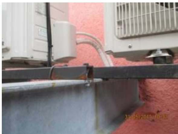
Obr. 78: Rzí degradované ocelové prvky VZT zařízení
