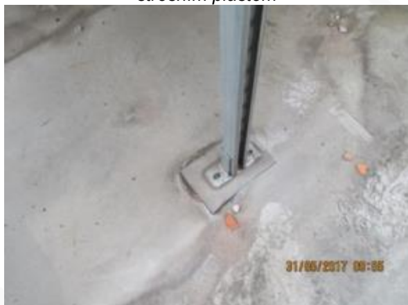
Obr. 46: Absence pryžové podložky – deformace krytiny
