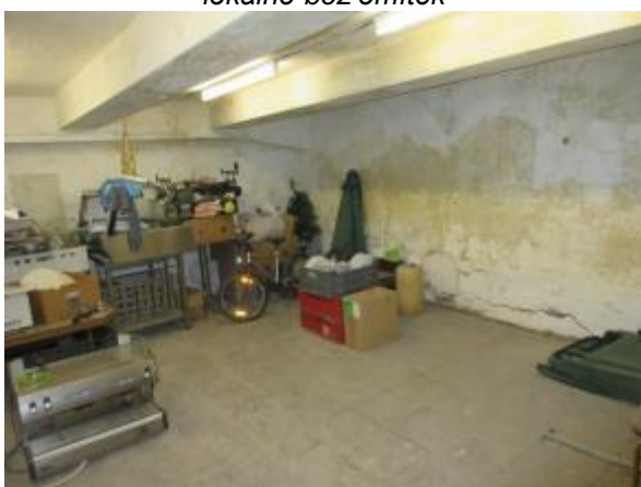
Obr. 284: Degradované omítky v suterénních prostorách
