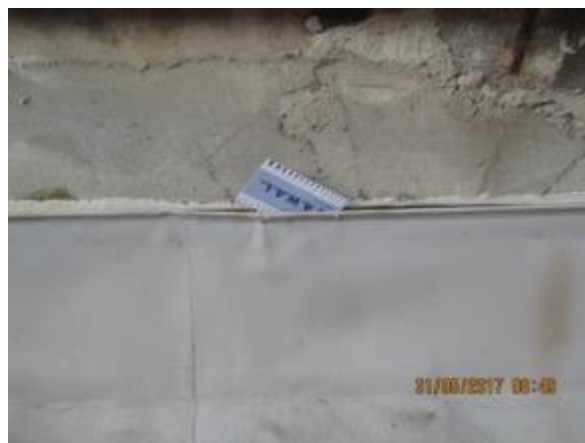
Obr. 31: Netěsné napojení na svislou konstrukci
