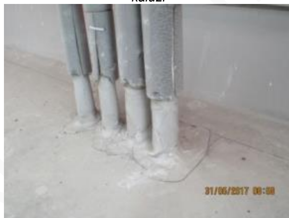
Obr. 45: Nevhodně a netěsně řešené prostupy střešním pláštěm
