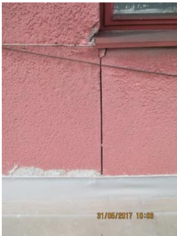
Obr. 191: Dilatace uprostřed vysoké odbavovací haly
