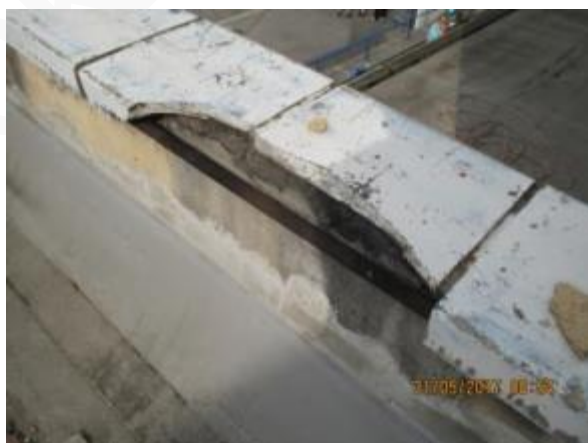
Obr. 27: Netěsná atika a netěsné napojení na svislou konstrukci
