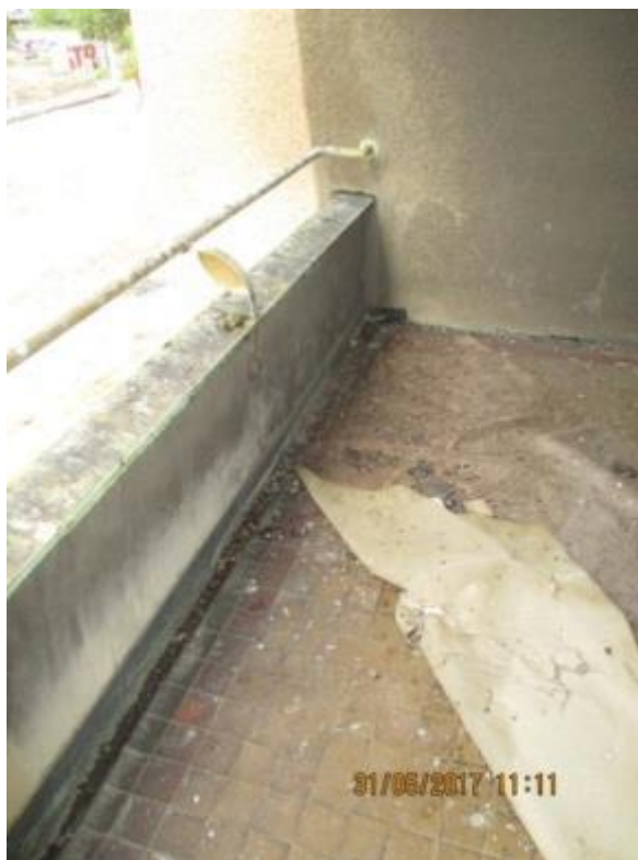
Obr. 240: Nefunkční skladba podlahy lodžii vč. nefunkčního oplechování a zámečnických výrobků
