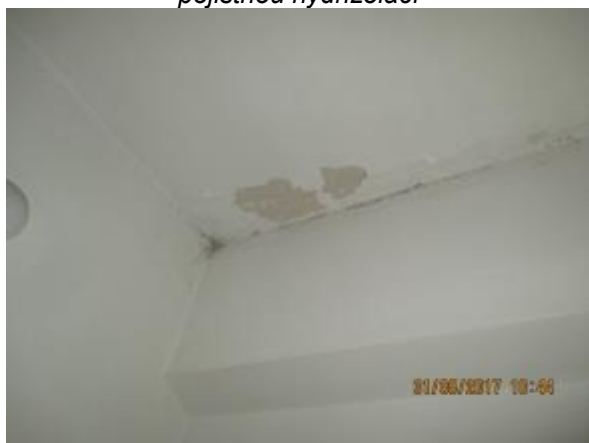
Obr. 126: Omítka na schodišti na půdou signalizující zátoky před výměnou krytiny
