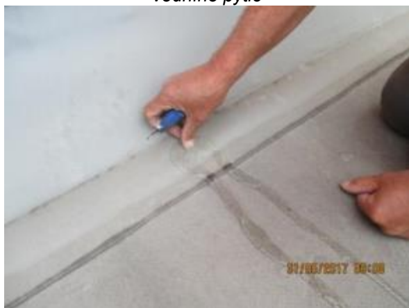
Obr. 20: Perforování a vypuštění vody z vodního pytle
