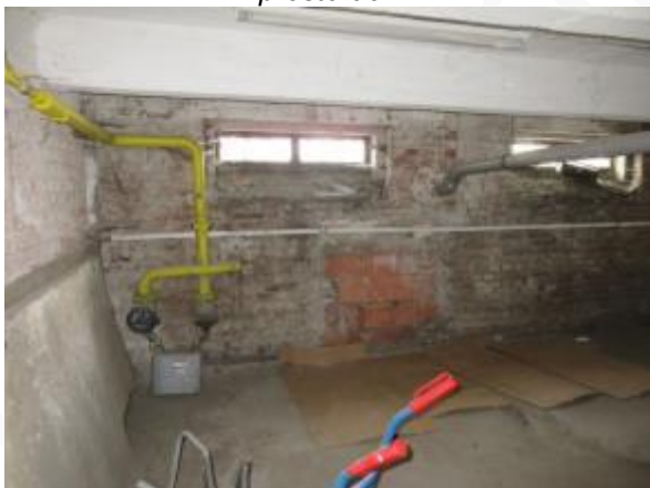
Obr. 286: Svislé konstrukce suterénu jsou lokálně již bez omítek
