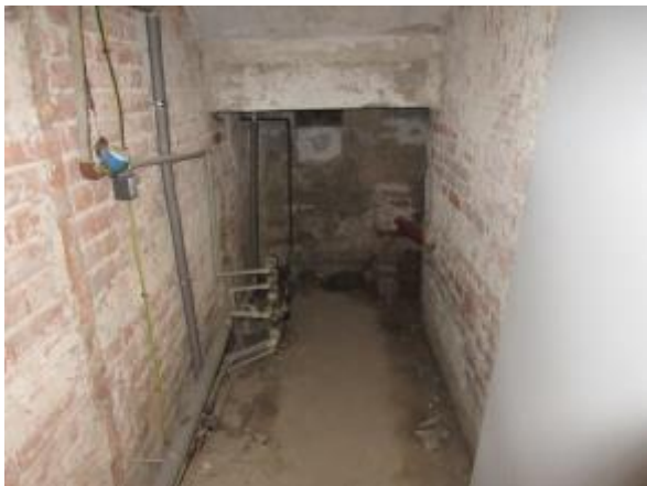
Obr. 282: Svislé konstrukce suterénu jsou již lokálně bez omítek
