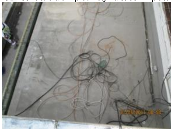
Obr. 65: Ostré a cizí předměty na střešním plášti
