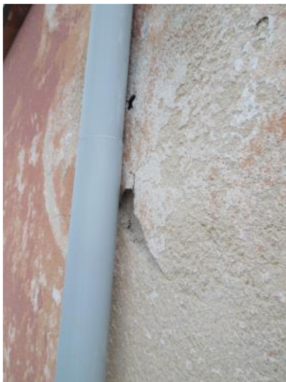
Obr. 202: Vysoce degradovaná omítka haly výpravní budovy (jižní část objektu) - detail
