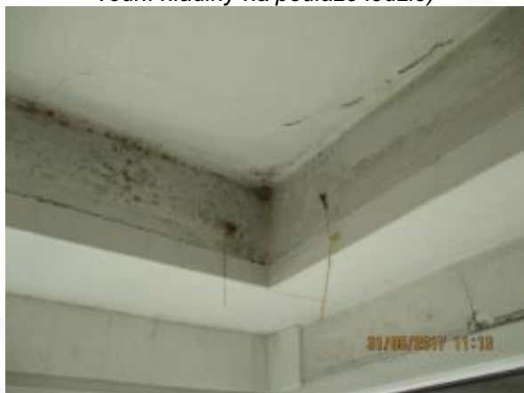
Obr. 253: Tepelný most v nadpraží rohového okna – nevhodné vnitřní částečné zateplení
