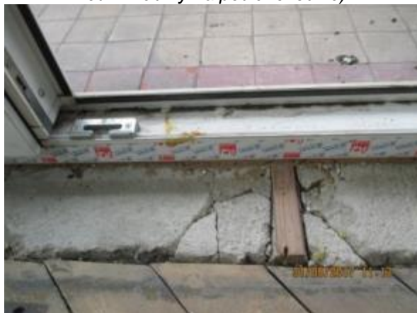
Obr. 251: Absence vnějšího uzávěru připojovací spáry- riziko zatečení (pozn. v případě zvýšení vodní hladiny na podlaze ložie)
