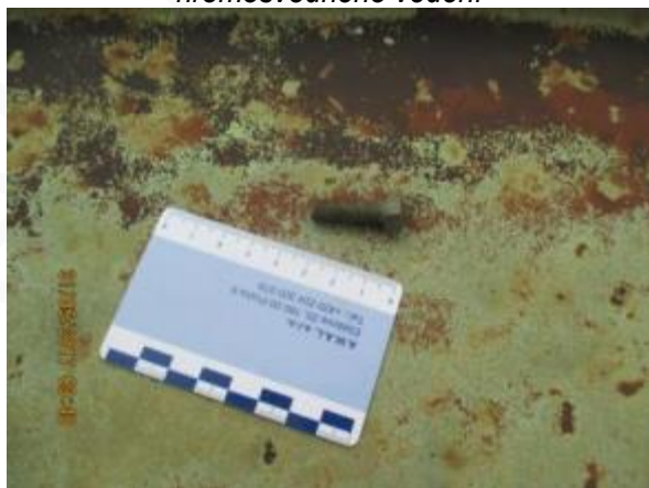
Obr. 116: Degradovaný měděný plech a volné šrouby
