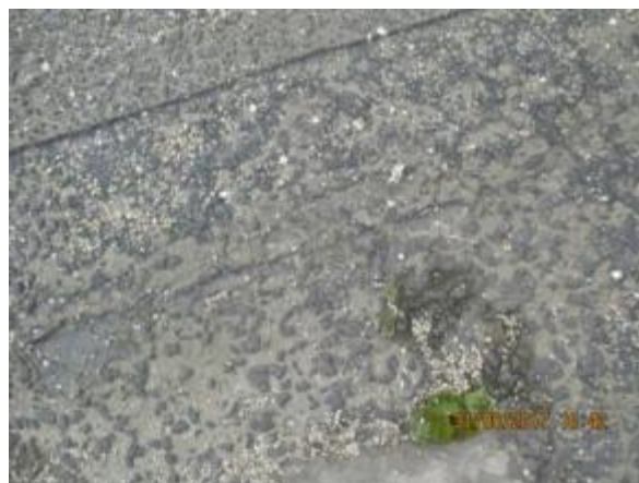
Obr. 101: Detail degradované asfaltové krytiny
