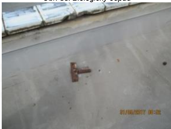
Obr. 58: Ostré a cizí předměty na střešním plášti
