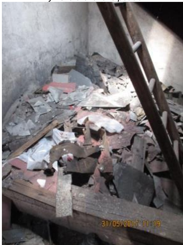
Obr. 141: Půda administrativní budovy – odpad střešních tvarovek
