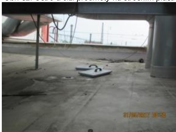
Obr. 64: Ostré a cizí předměty na střešním plášti
