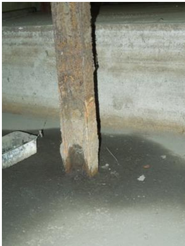
Obr. 279: Havarijní stav ocelové konstrukce v předávací stanici
