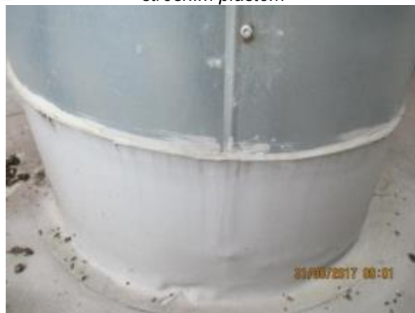
Obr. 47: Nevhodně a netěsně řešené prostupy střešním pláštěm – absence svěrné pásky
