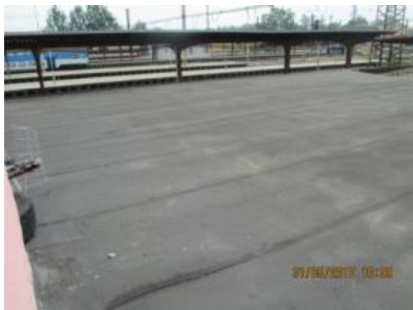
Obr. 95: Pohled na střechu s asfaltovou krytinou – garáže na jihovýchodní části objektu
