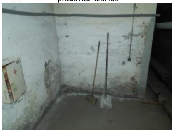
Obr. 264: Degradované omítky v suterénu předávací stanice
