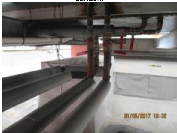
Obr. 80: Rzí degradované ocelové prvky VZT zařízení
