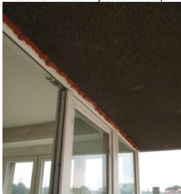
Obr. 248: Absence vnějšího uzávěru připojovací spáry- montážní pěna není chráněna vůči UV-záření
