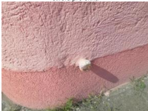
Obr. 216: Soklová část omítky s výškovým bodem státní nivelace
