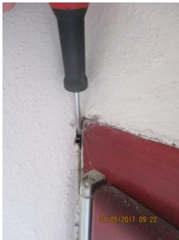
Obr. 179: Sonda do připojovací spáry okna
