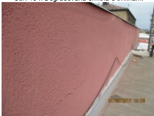
Obr. 196: Degradovaná omítka s trhlinami
