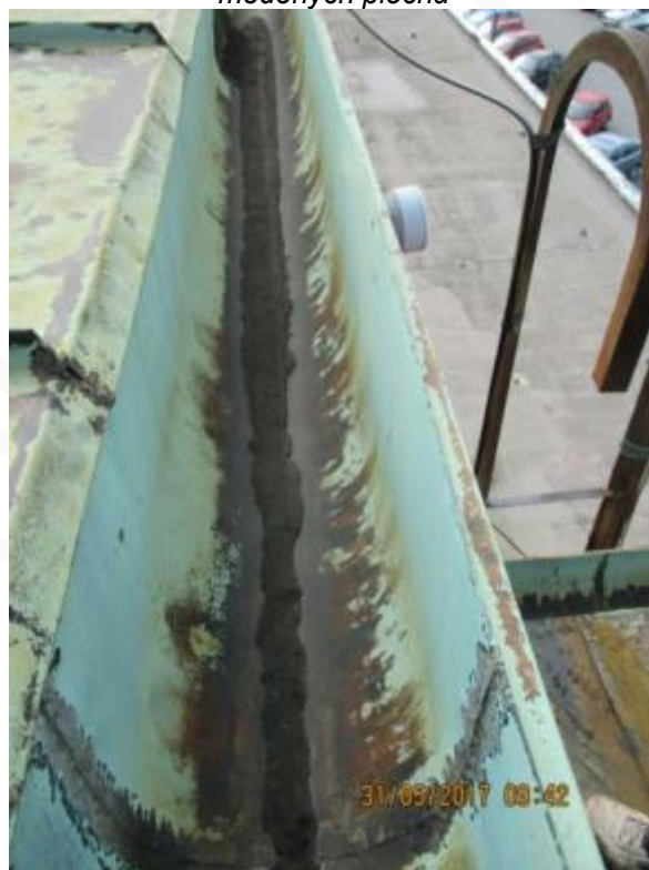
Obr. 115: Okap střechy vyspravován asfaltovým nátěrem
