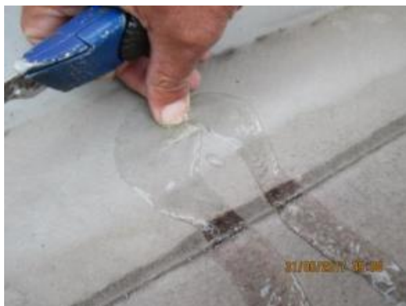
Obr. 21: Perforování a vypuštění vody z vodního pytle
