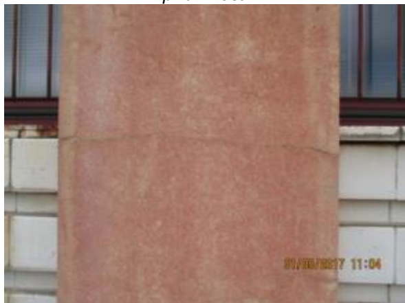
Obr. 227: Vodorovná trhlinka omítky sloupu
