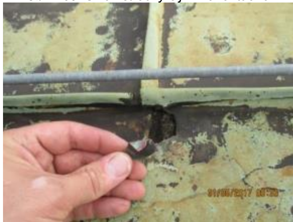
Obr. 111: Praskliny a netěsnosti krytiny z falcovaných měděných plechů
