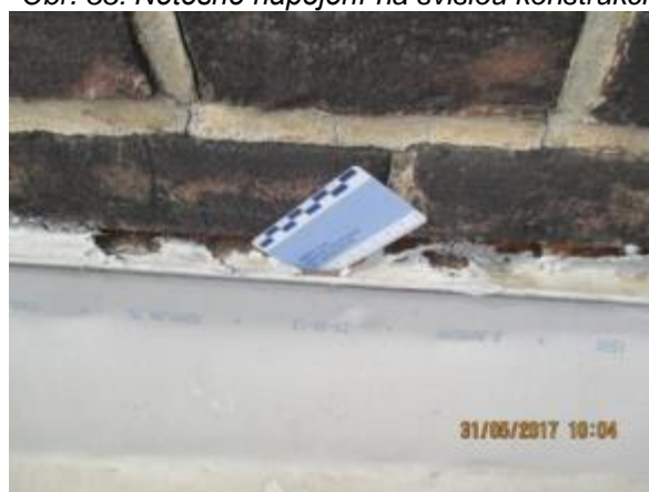
Obr. 35: Netěsné napojení na svislou konstrukci
