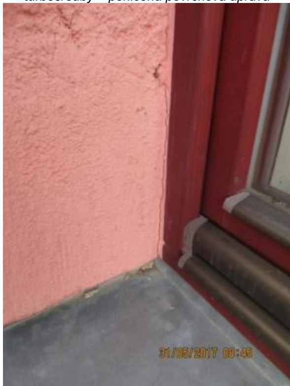
Obr. 177: Prasklina vlivem dilatace okna a stěny
