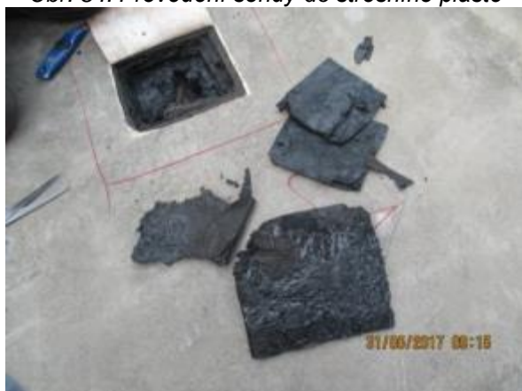
Obr. 86: Provedení sondy do střešního pláště
