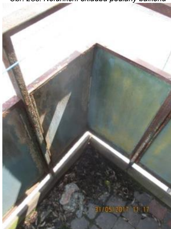
Obr. 258: Nefunkční skladba podlahy balkónu - degradace zábradlí rzi
