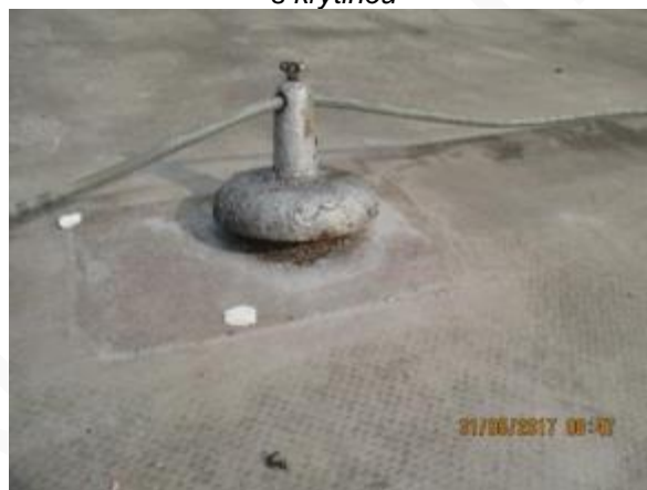
Obr. 69: Absence podložek na hromosvodném vedením
