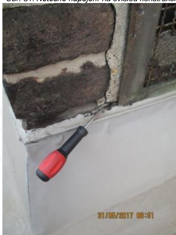
Obr. 33: Netěsné napojení na svislou konstrukci
