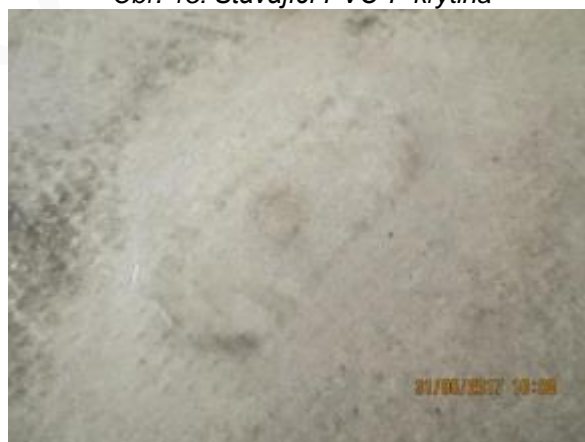
Obr. 17: Stávající PVC-P krytina – degradace krytiny na nosnou vložku s uvolněnou kotvou
