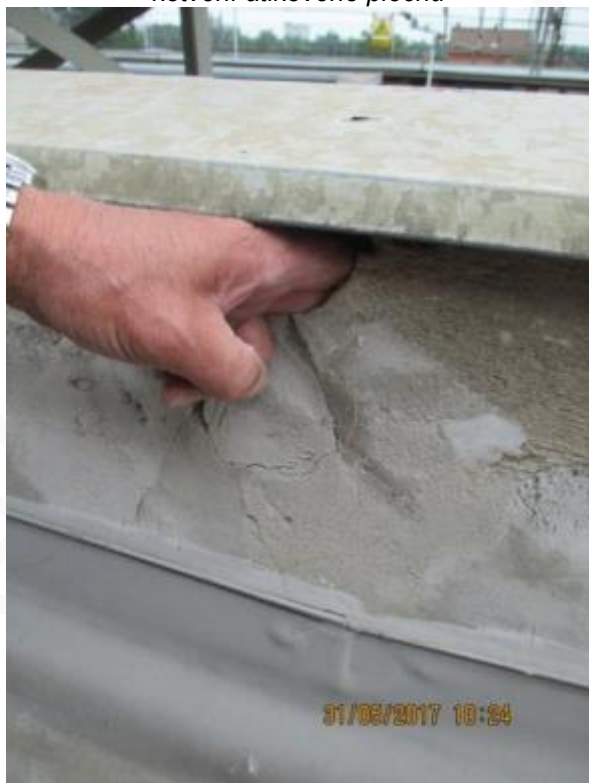
Obr. 76: Netěsná a nefunkční atika – nesoudržná svislá omítka – riziko zatečení
