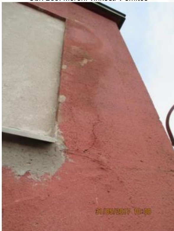
Obr. 211: Praskliny a degradace omítky
