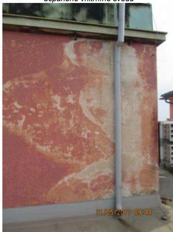
Obr. 200: Vlhkostí degradovaná omítka vlivem ucpaného vnitřního svodu – již provedená oprava
