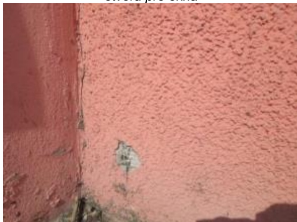
Obr. 215: Porušená výztužná vrstva soklové části omítky
