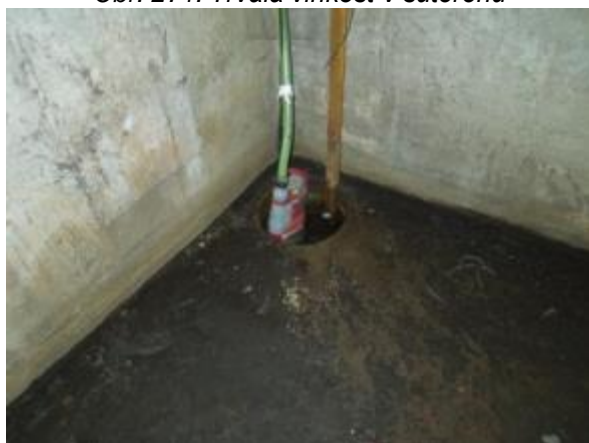
Obr. 273: Trvalá vlhkost v suterénu
