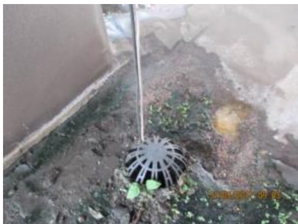
Obr. 48: Zanesená vpust + kabeláž vedoucí vpustí
