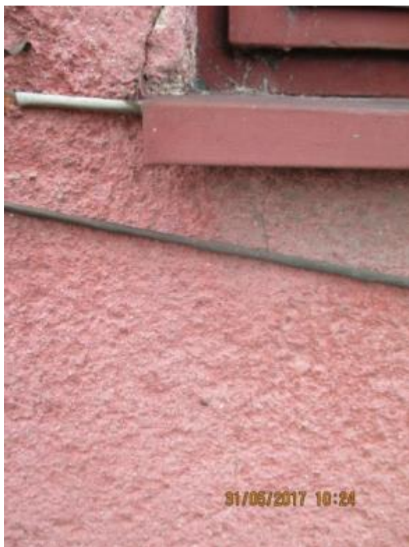
Obr. 159: Praskliny omítky v místě parapetu
