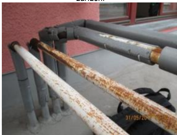
Obr. 81: Rzí degradované ocelové prvky VZT zařízení
