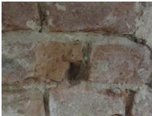
Obr. 289: Odběr vzorku pro laboratorní rozbor
