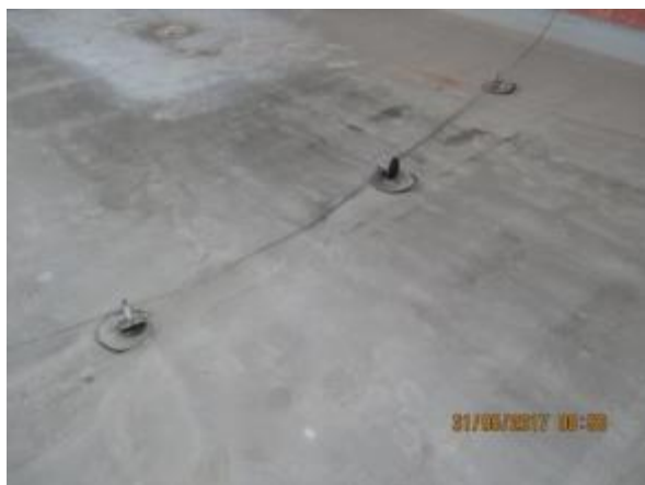
Obr. 66: Hromosvodné vedení v kontaktu s krytinou
