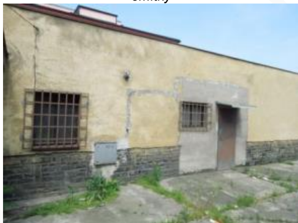
Obr. 217: Degradovaná omítka jednopatrových budov na jihovýchodní části (garáže)
