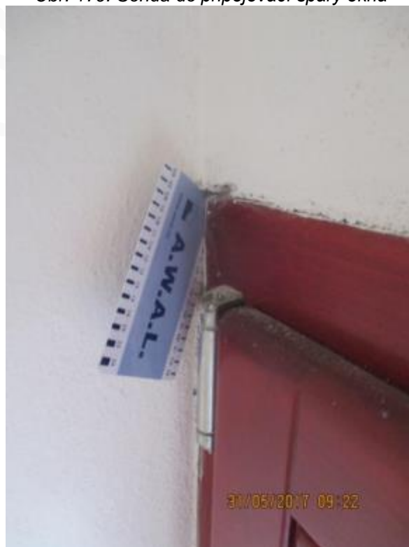
Obr. 181: Sonda do připojovací spáry okna
