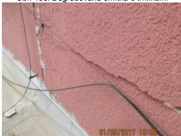
Obr. 195: Degradovaná omítka s trhlinami
