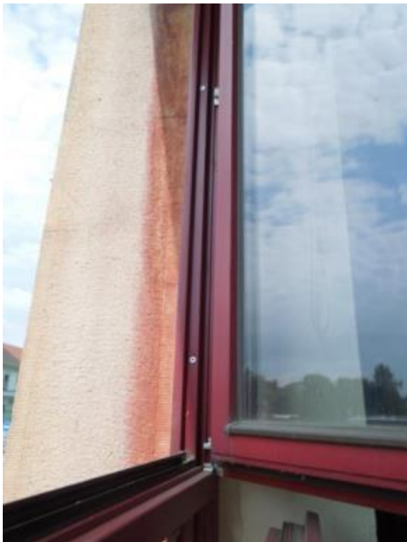
Obr. 174: Lokálně jsou okna kotvena na tzv. turbošrouby – poničená povrchová úprava
