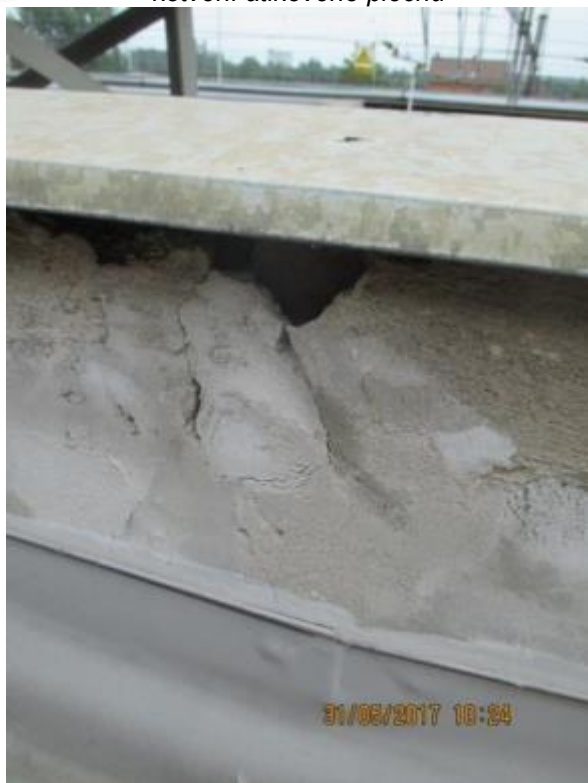
Obr. 77: Netěsná a nefunkční atika – nesoudržná svislá omítka – riziko zatečení
