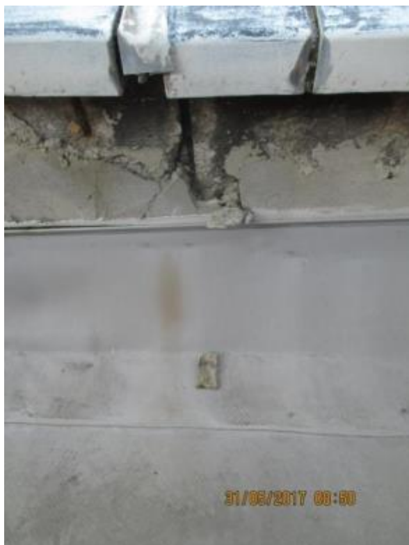
Obr. 25: Netěsná atika a netěsné napojení na svislou konstrukci
