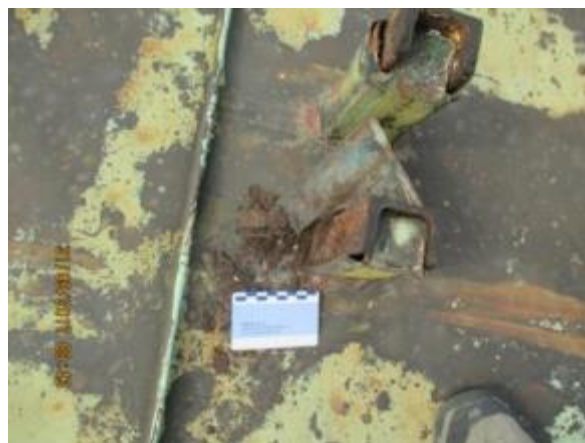
Obr. 119: Netěsné prostupy ocelové konstrukce napadené rží
