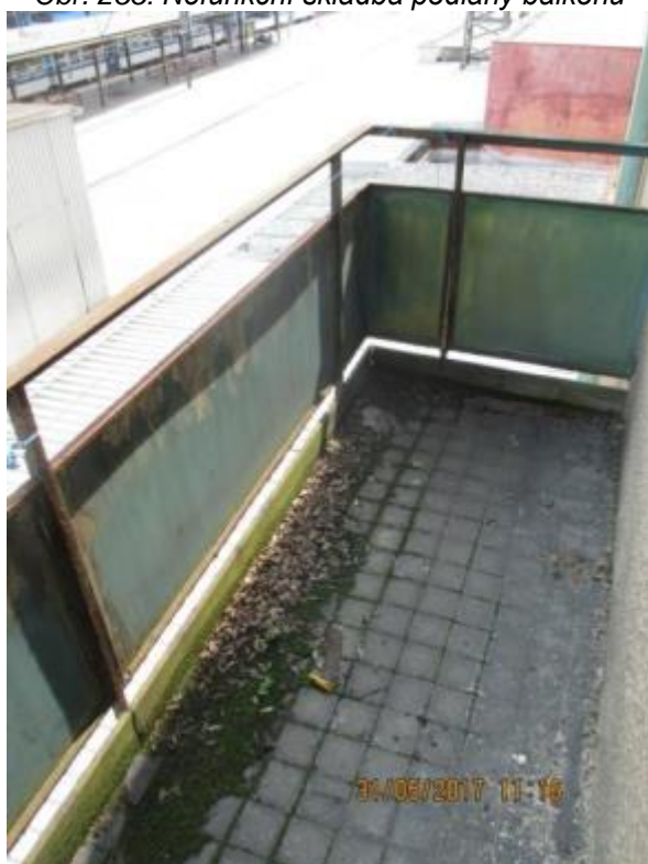
Obr. 257: Nefunkční skladba podlahy balkónu – degradace zábradlí rzi
