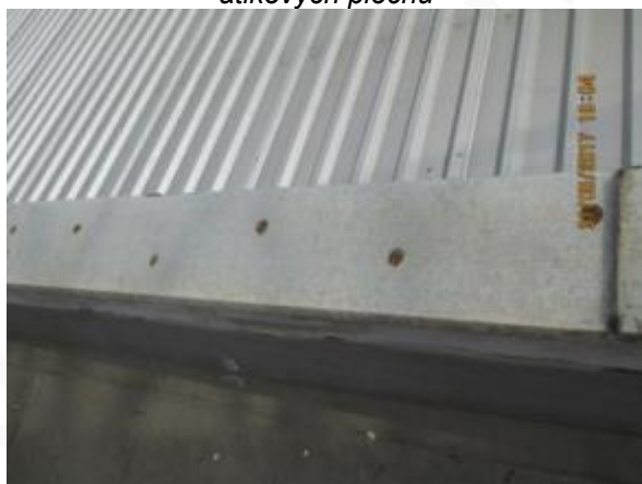
Obr. 75: Netěsná a nefunkční atika – zrezlé kotvení atikového plechu
