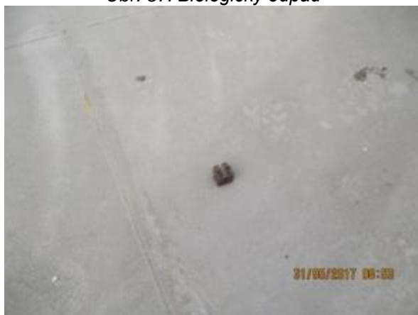
Obr. 59: Ostré a cizí předměty na střešním plášti
