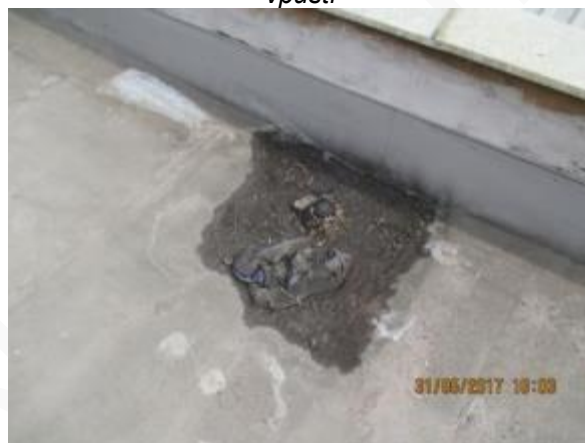
Obr. 51: Zanesená vpust
