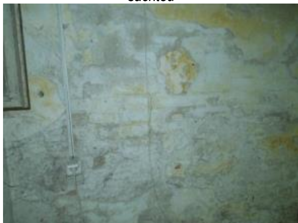
Obr. 267: Degradované omítky v suterénu předávací stanice
