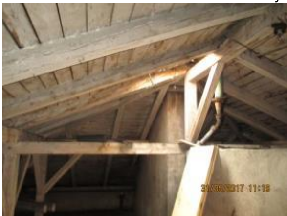
Obr. 138: Půda administrativní budovy s viditelným podbitím tvarovek krytiny
