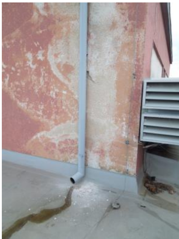
Obr. 201: Vysoce degradovaná omítka haly výpravní budovy (jižní část objektu)
