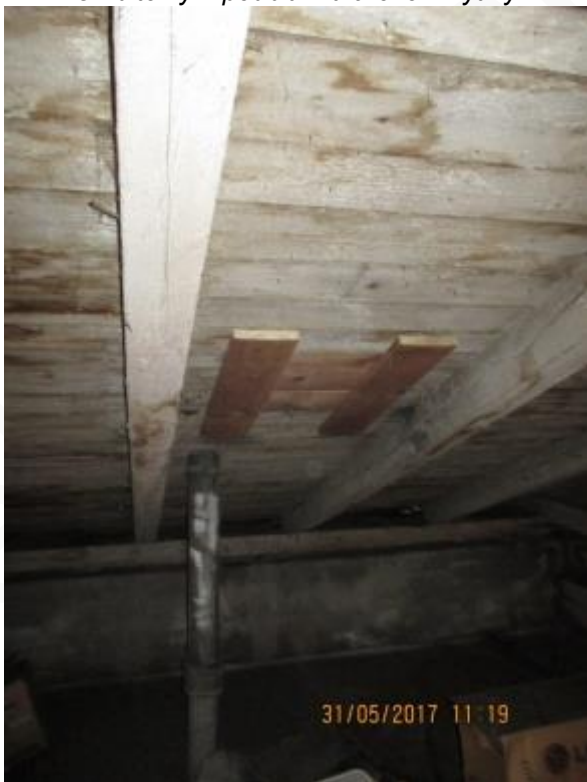
Obr. 140: Půda administrativní budovy – lokální opravy dřevěného podbití
