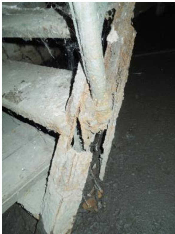
Obr. 280: Havarijní stav ocelové konstrukce v předávací stanici
