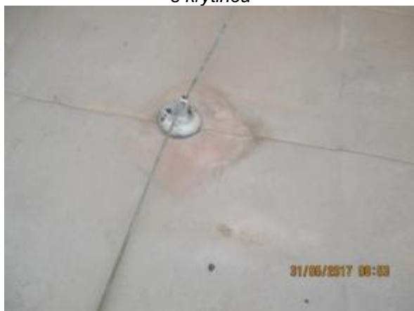
Obr. 68: Absence podložek na hromosvodném vedením – porušená krytina
