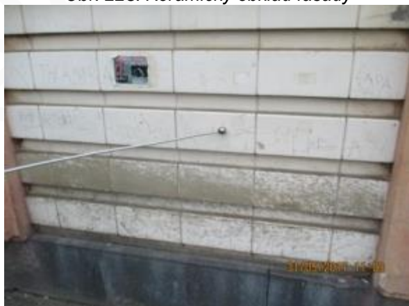
Obr. 223: Keramický obklad fasády
