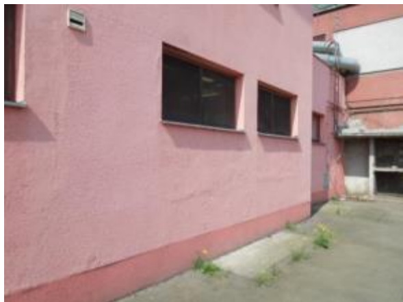
Obr. 213: Různá zrnitost omítky po zazdění části otvoru pro okna
