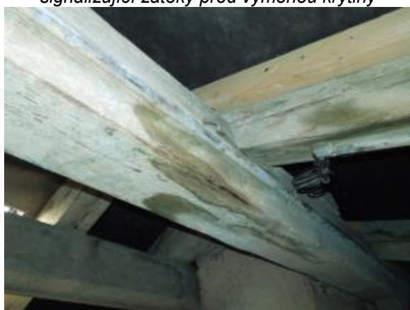
Obr. 128: Půda výpravní budovy – místo měření vlhkosti na jižní části budovy
