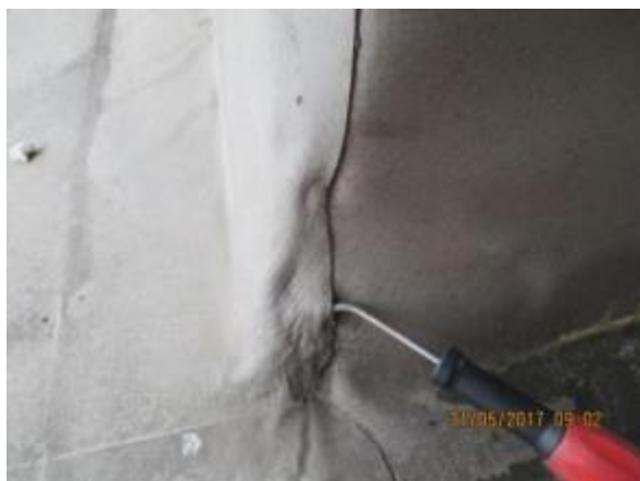
Obr. 36: Netěsné spoje
