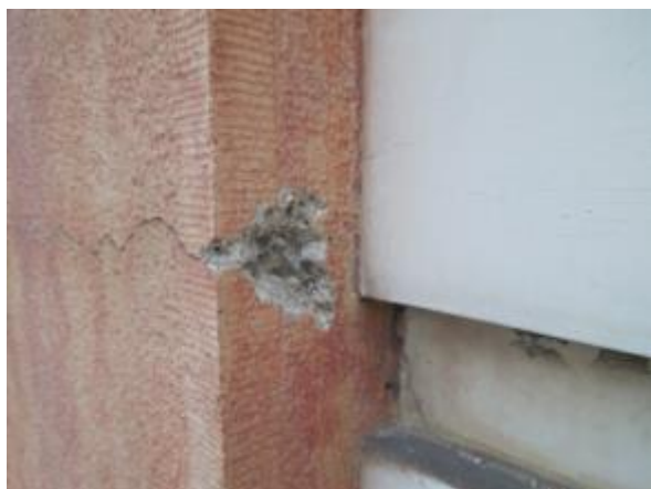
Obr. 233: Sonda do omítky fasády v jižní části (uliční) výpravní budovy
