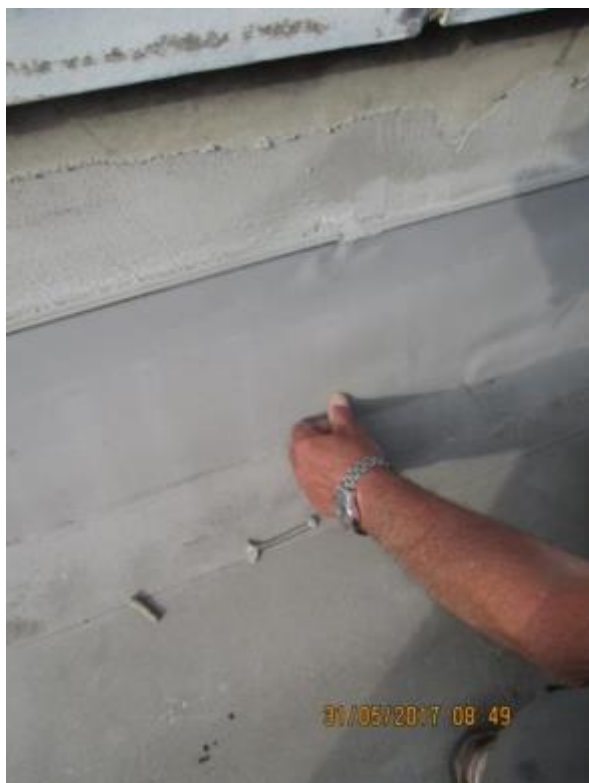
Obr. 24: Chybně kotvená koutová lišta – PVC-P fólie není řádně kotvená a vzniká tvarová deformace
