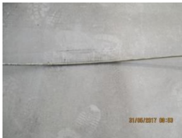
Obr. 67: Hromosvodné vedení v kontaktu s krytinou
