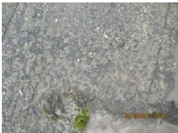
Obr. 100: Detail degradované asfaltové krytiny
