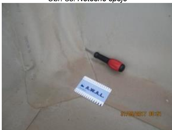
Obr. 38: Netěsné spoje
