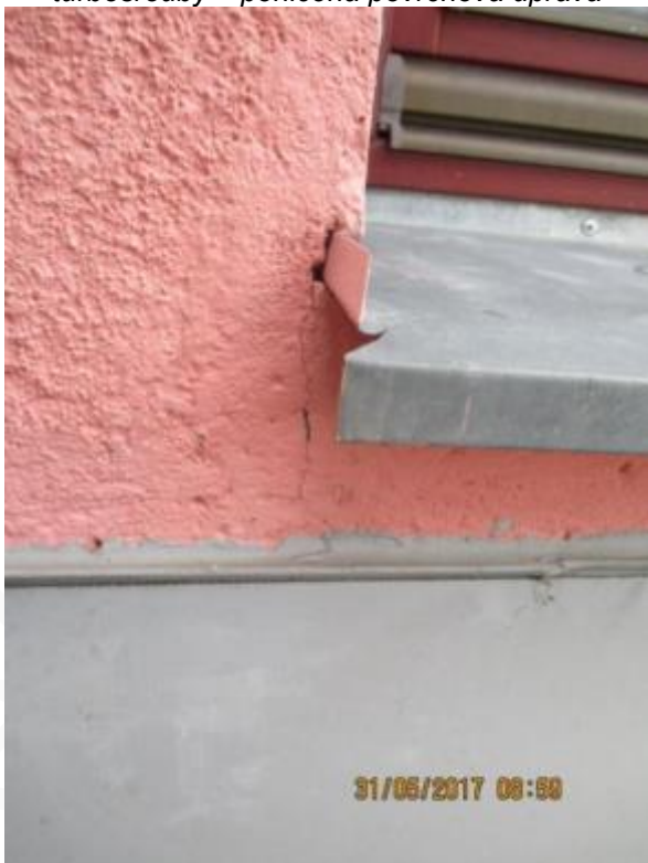
Obr. 176: Prasklina vlivem nevhodného osazení parapetu
