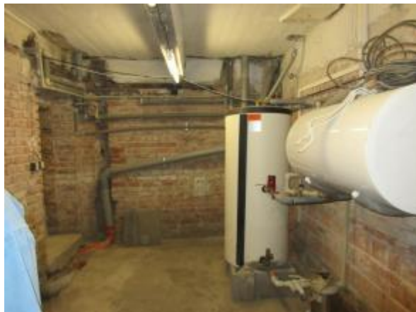
Obr. 283: Svislé konstrukce suterénu jsou lokálně již bez omítek
