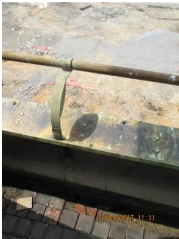
Obr. 239: Nefunkční oplechování a zámečnické výrobky
