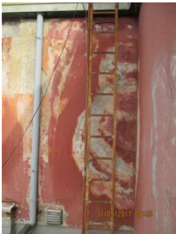
Obr. 197: Vlhkostí degradovaná omítka vlivem ucpaného vnitřního svodu
