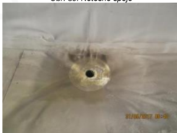
Obr. 41: Nevhodný typ vpusti
