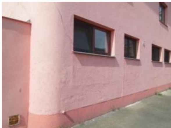
Obr. 214: Různá zrnitost omítky po zazdění části otvoru pro okna
