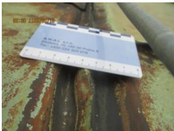
Obr. 112: Degradace krytiny z falcovaných měděných plechů
