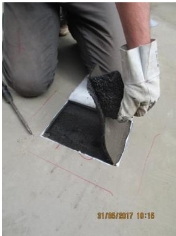
Obr. 91: Provedení sondy do střešního pláště
