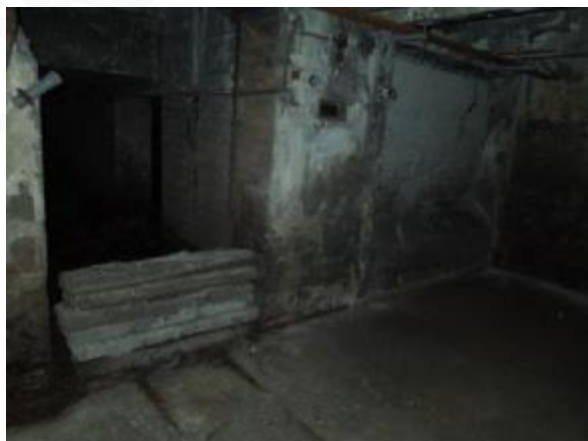
Obr. 268: Degradované omítky v suterénu předávací stanice
