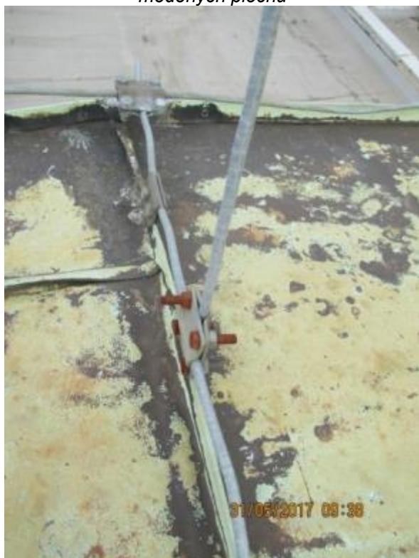
Obr. 114: Rzí degradovaný šroubový spoj hromosvodného vedení
