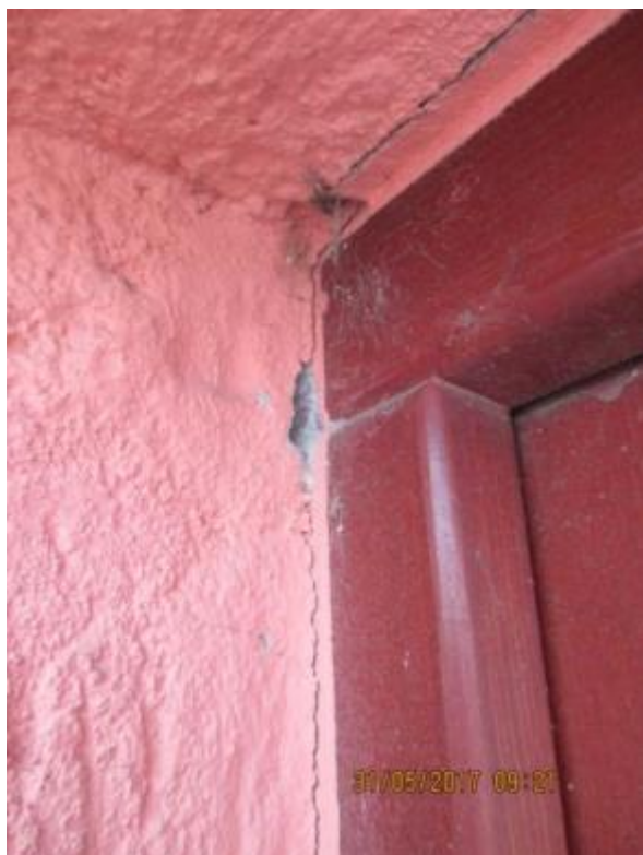
Obr. 178: Prasklina vlivem dilatace okna a stěny
