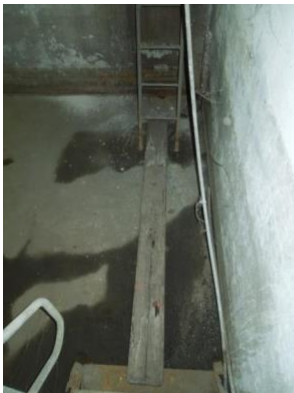
Obr. 271: Trvalá vlhkost v suterénu
