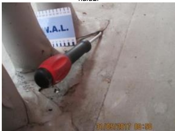
Obr. 44: Nevhodně a netěsně řešené prostupy střešním pláštěm
