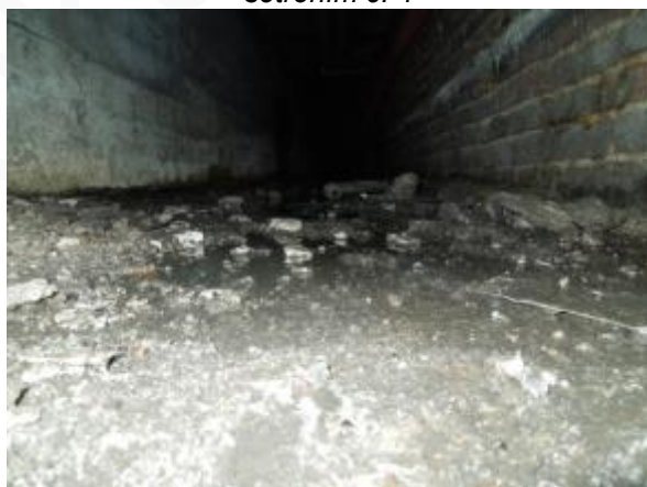
Obr. 278: Nový zátok při deštích před místním šetřením č. 4 – kolektor v severní části objektu – podél nástupiště č.1
