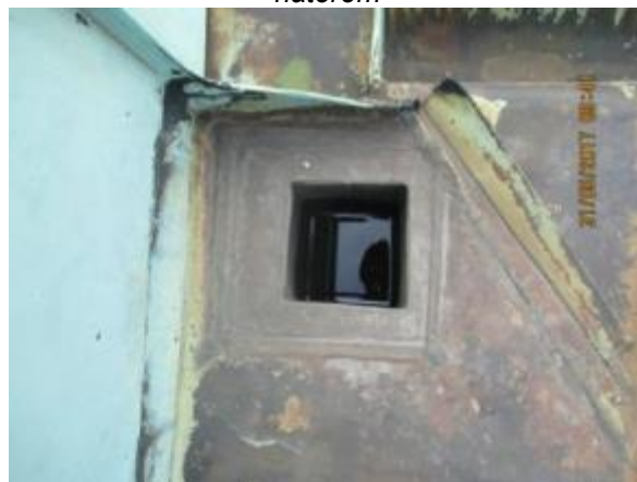
Obr. 117: Ucpaný vnitřní svod – způsobuje poruchy omítek v interiéru i exteriéru
