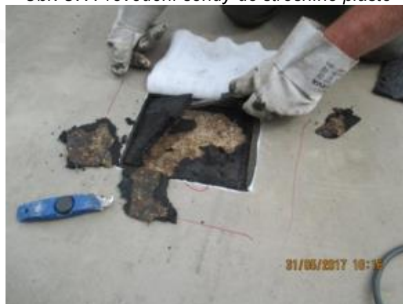
Obr. 89: Provedení sondy do střešního pláště
