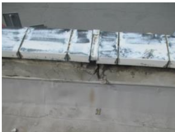
Obr. 72: Netěsná a nefunkční atika
