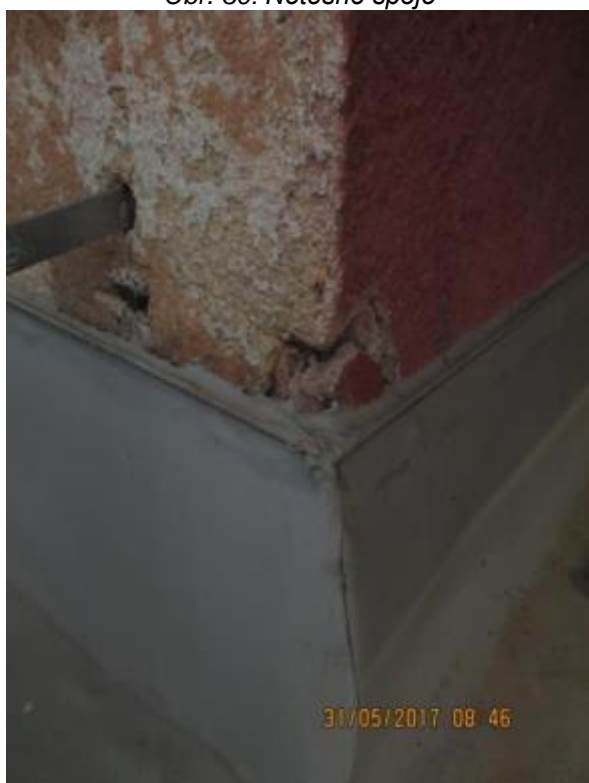
Obr. 32: Netěsné napojení na svislou konstrukci
