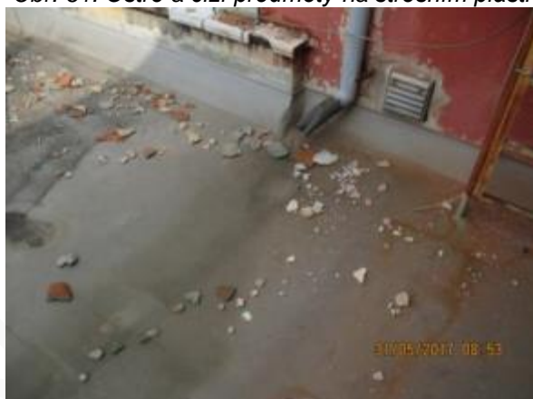
Obr. 63: Ostré a cizí předměty na střešním plášti
