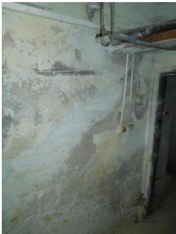
Obr. 261: Degradované omítky v suterénu předávací stanice
