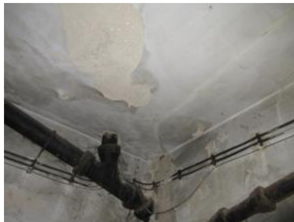
Obr. 301: Nesoudržná suterénní omítka na stropních konstrukcích
