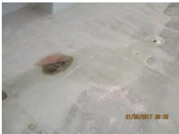
Obr. 42: Nerovný podklad spádování – tvorba kaluží
