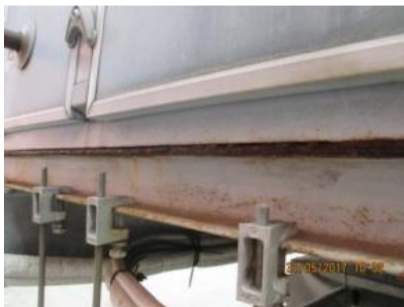
Obr. 79: Rzí degradované ocelové prvky VZT zařízení
