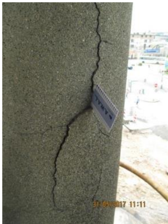
Obr. 246: Trhlina omítky lodžiového sloupu
