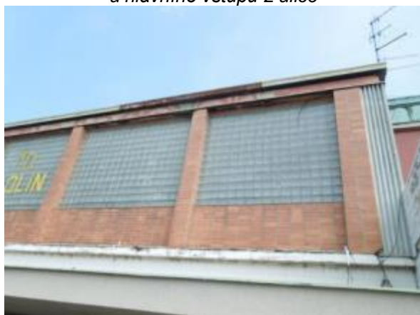
Obr. 221: Prosvětlení haly z tzv. luxferů
