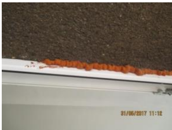
Obr. 250: Absence vnějšího uzávěru připojovací spáry- montážní pěna není chráněna vůči UV-záření
