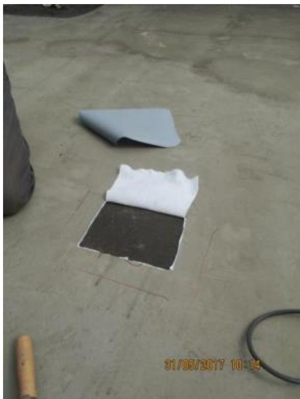
Obr. 90: Provedení sondy do střešního pláště
