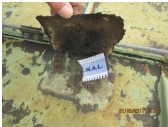
Obr. 107: Praskliny a netěsnosti krytiny z falcovaných měděných plechů
