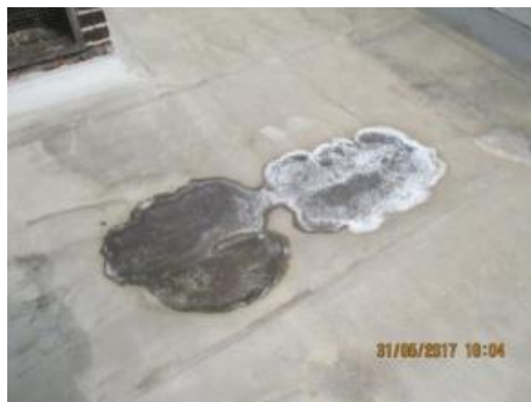
Obr. 43: Nerovný podklad spádování – tvorba kaluží
