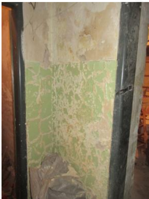
Obr. 292: Omítka do výše 1,5 m je opatřena neprodyšným nátěrem – celková degradace
