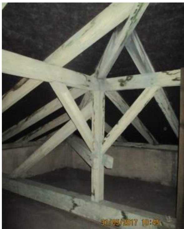
Obr. 124: Krov výpravní budovy s viditelnou pojistnou hydrizolací
