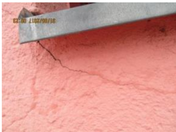
Obr. 182: Prasklina vlivem nevhodného osazení parapetu
