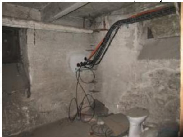
Obr. 298: Nesoudržná suterénní omítka na svislých konstrukcích
