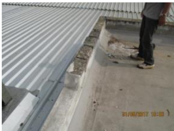
Obr. 73: Netěsná a nefunkční atika – absence atikových plechů
