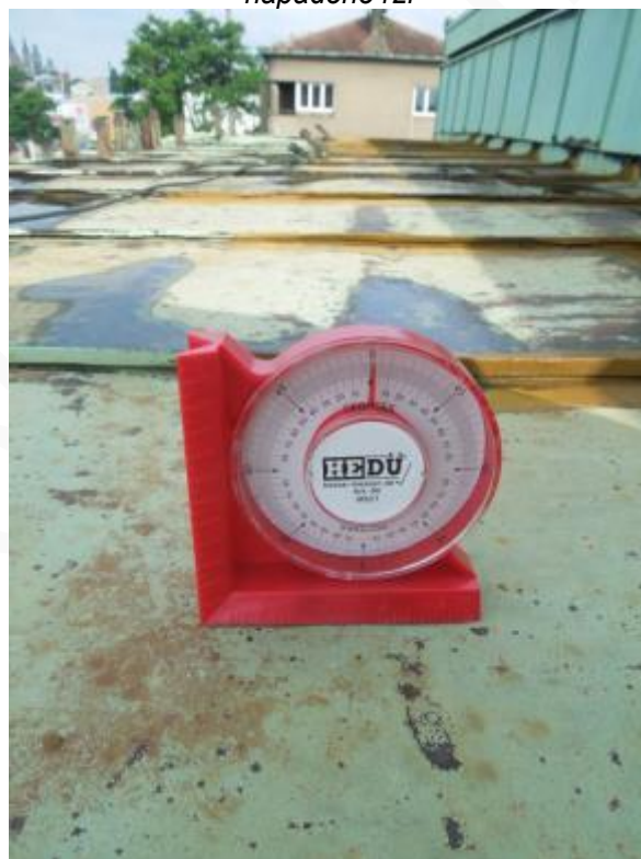
Obr. 121: Téměř nulový sklon malé stříšky s falcovanými měděnými plechy – tvorba kaluží
