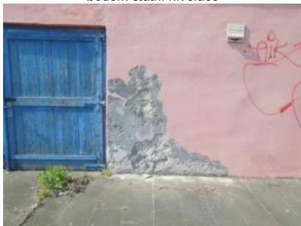
Obr. 218: Degradovaná omítka jednopatrových budov na jihovýchodní části (garáže)
