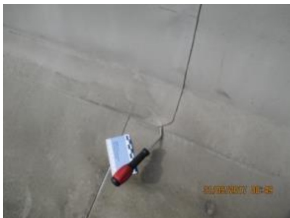
Obr. 30: Netěsné spoje
