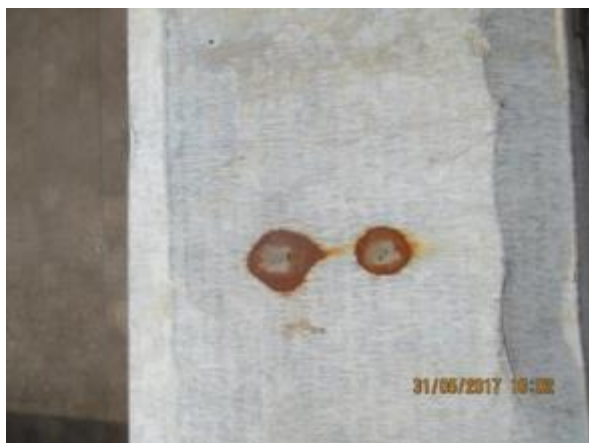
Obr. 74: Netěsná a nefunkční atika – zrezlé kotvení atikového plechu
