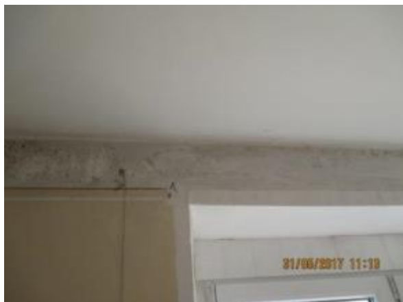
Obr. 254: Tepelný most v nadpraží rohového okna – nevhodné vnitřní částečné zateplení
