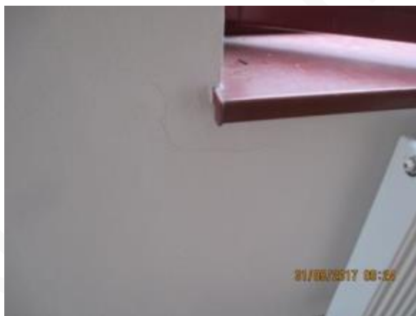
Obr. 185: Prasklina v interiéru oblasti parapetu
