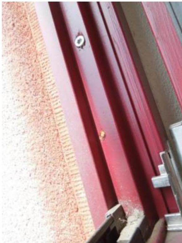
Obr. 175: Lokálně jsou okna kotvena na tzv. turbošrouby – poničená povrchová úprava
