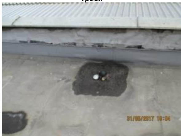
Obr. 50: Zanesená vpustí
