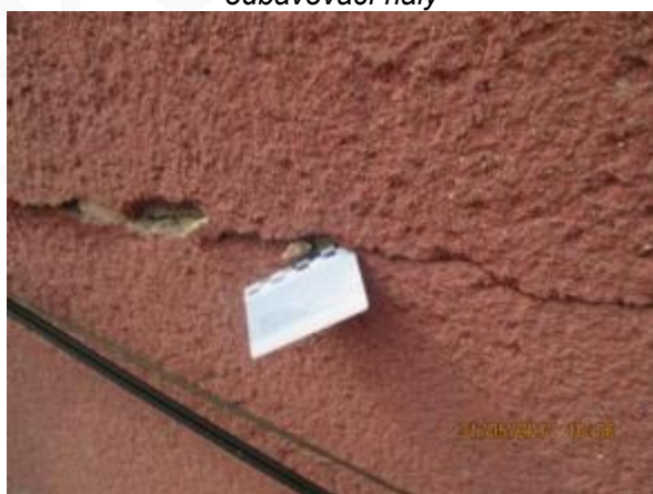
Obr. 194: Degradovaná omítka s trhlinami
