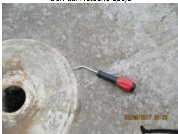
Obr. 40: Nevhodný typ vpusti a netěsné spoje
