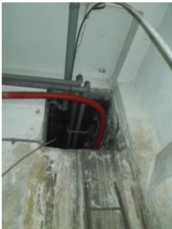
Obr. 265: Degradované omítky v suterénu předávací stanice – předpokládaný zátok šachtou
