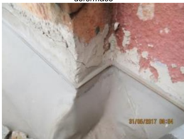
Obr. 26: Chybně kotvená koutová lišta – PVC-P fólie není řádně kotvená a vzniká tvarová deformace
