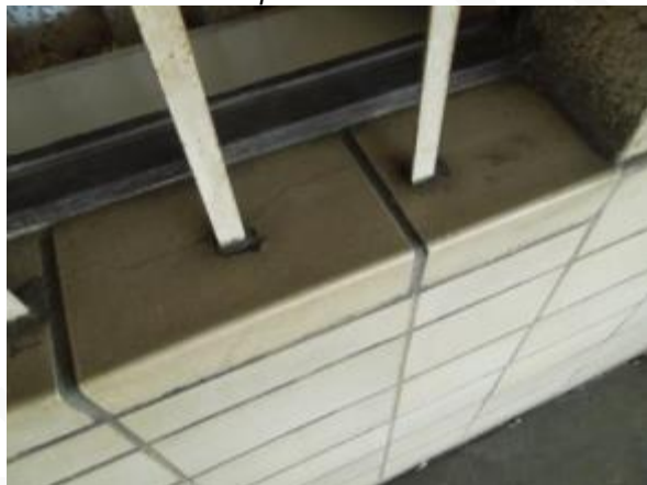
Obr. 231: Praskliny obkladu v místě napojení mříže
