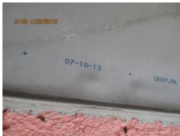
Obr. 13: Stávající PVC-P krytina
