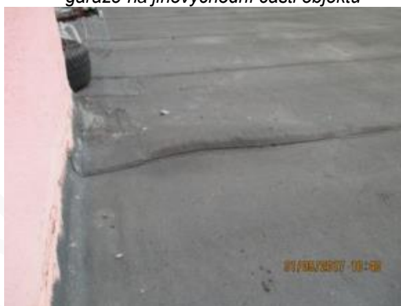
Obr. 97: Nevhodně řešené napojení na svislou konstrukci – riziko zatečení
