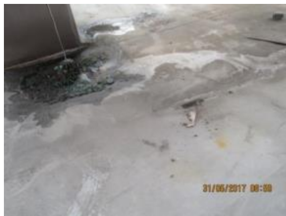
Obr. 49: Zanesená vpust + kabeláž vedoucí vpustí
