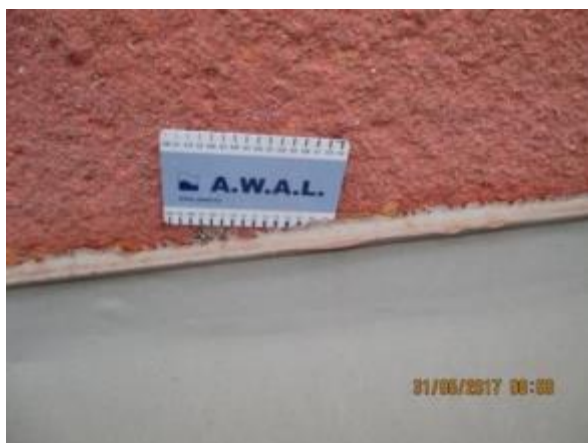
Obr. 29: Netěsné napojení na svislou konstrukci
