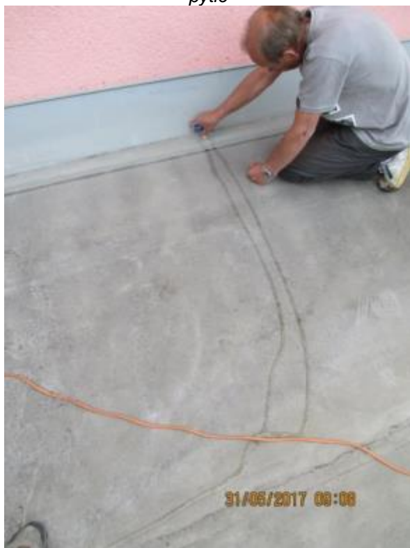
Obr. 22: Perforování a vypuštění vody z vodního pytle
