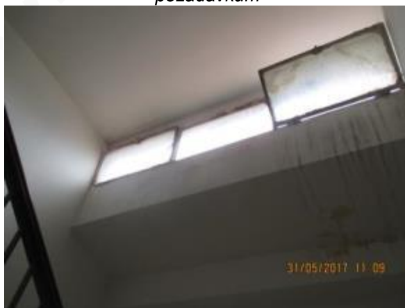
Obr. 173: Stávající okna a dveře jsou morálně zastaralá a neodpovídají současným požadavkům
