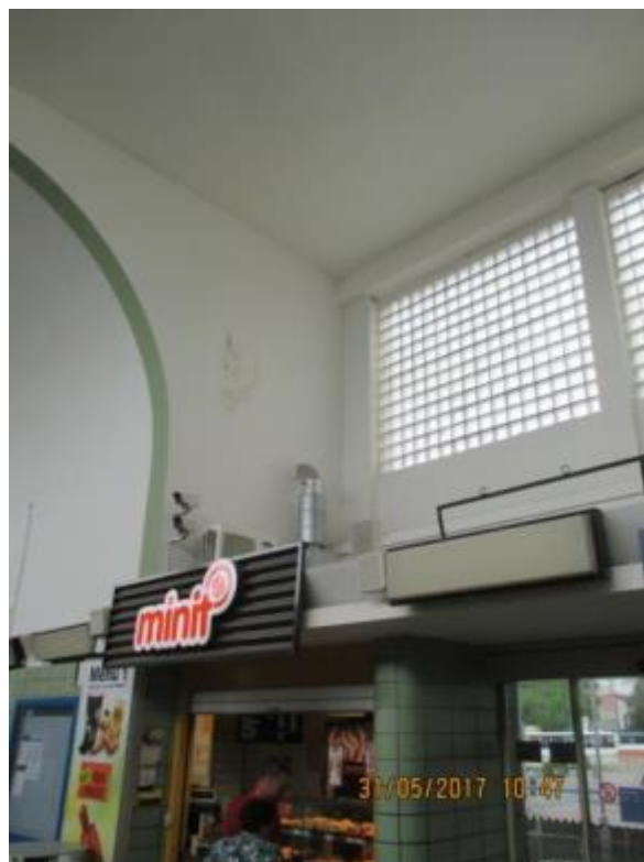
Obr. 198: Vlhkostí degradovaná omítka vlivem ucpaného vnitřního svodu
