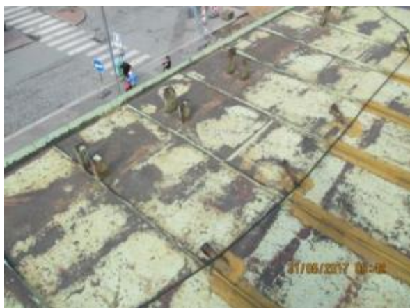
Obr. 118: Spojce falcované krytiny vyspravovány nefunkčním vodotěsným nátěrem
