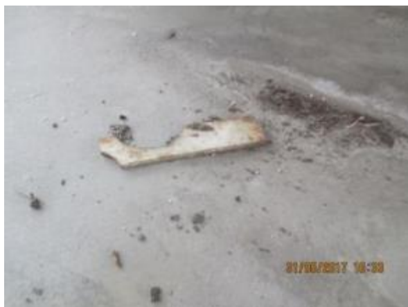
Obr. 60: Ostré a cizí předměty na střešním plášti
