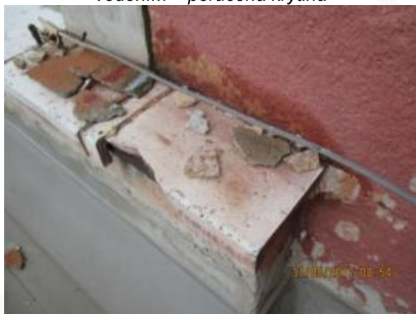
Obr. 70: Přerušené hromosvodné vedení
