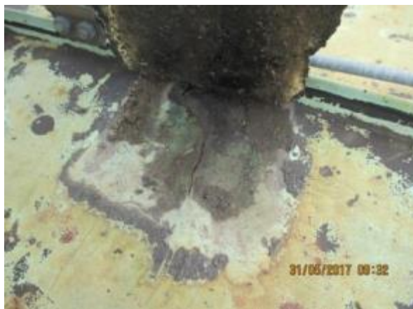
Obr. 106: Praskliny a netěsnosti krytiny z falcovaných měděných plechů
