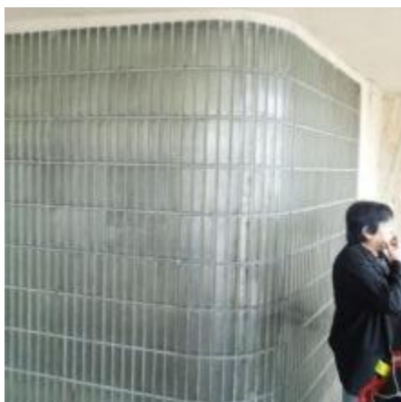
Obr. 219: Prosklená stěna z tzv. luxferů u hlavního vstupu z ulice
