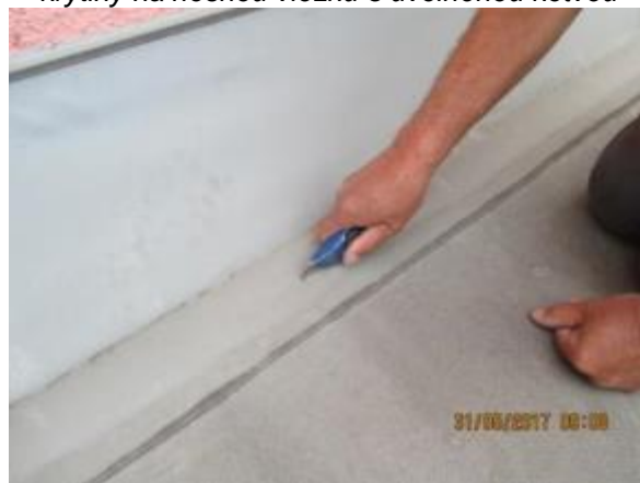
Obr. 17: Stávající PVC-P krytina – degradace krytiny na nosnou vložku s uvolněnou kotvou
