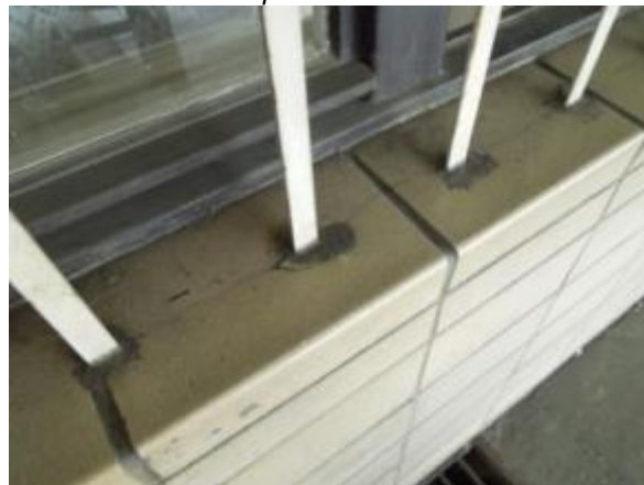
Obr. 232: Praskliny obkladu v místě napojení mříže
