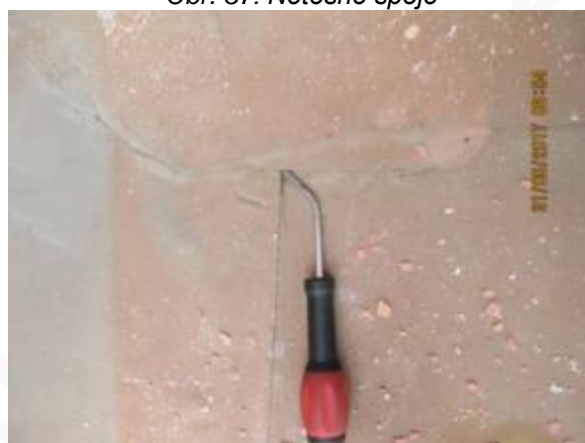
Obr. 39: Netěsné spoje
