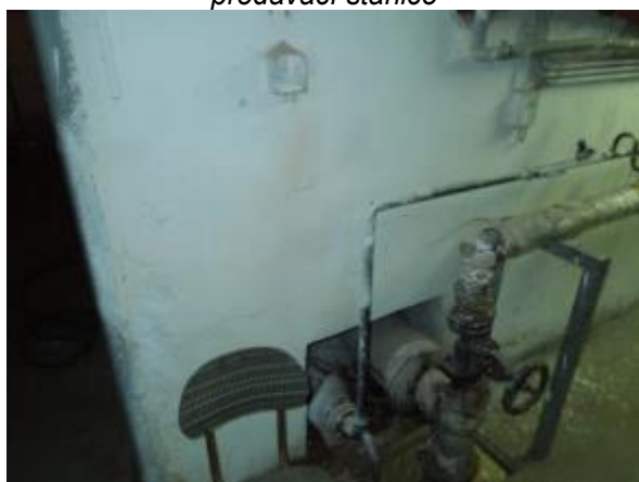
Obr. 263: Degradované omítky v suterénu předávací stanice
