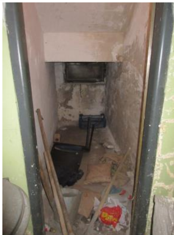
Obr. 293: Degradovaná omítka v suterénu
