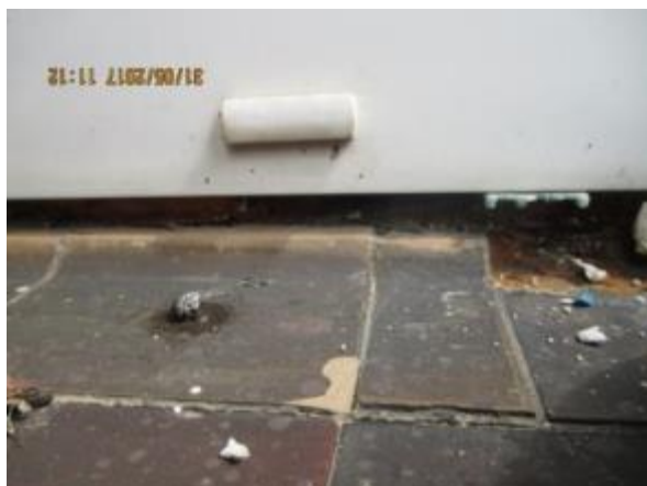
Obr. 249: Absence vnějšího uzávěru připojovací spáry- riziko zatečení (pozn. v případě zvýšení vodní hladiny na podlaze ložie)
