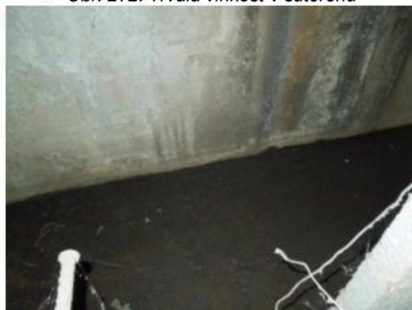
Obr. 274: Trvalá vlhkost v suterénu
