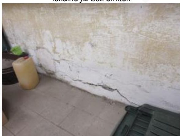
Obr. 285: Degradované omítky
