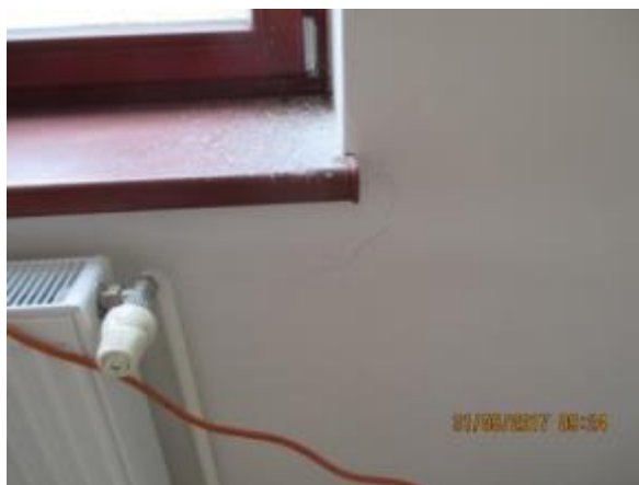
Obr. 183: Prasklina v interiéru oblasti parapetu
