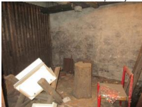
Obr. 299: Nesoudržná suterénní omítka na svislých konstrukcích
