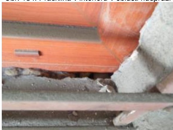
Obr. 186: Absence parapetu a vnějšího uzávěru připojovací spáry (pozn. Jedná se o místo na krytém nástupišti č. 1)
