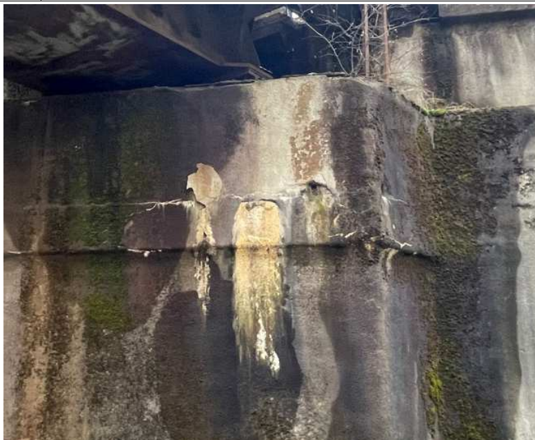
Opěra O 01 – vzduť a degradace úprav povrchů
