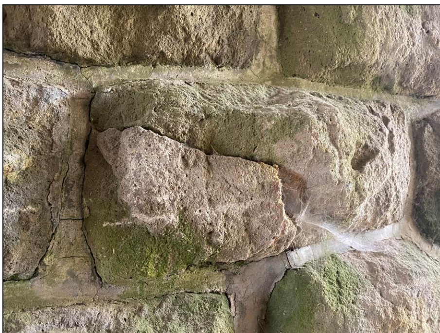
Obr. č. 21 - detail na zvětralé a zdegradované kamenné zdivo
