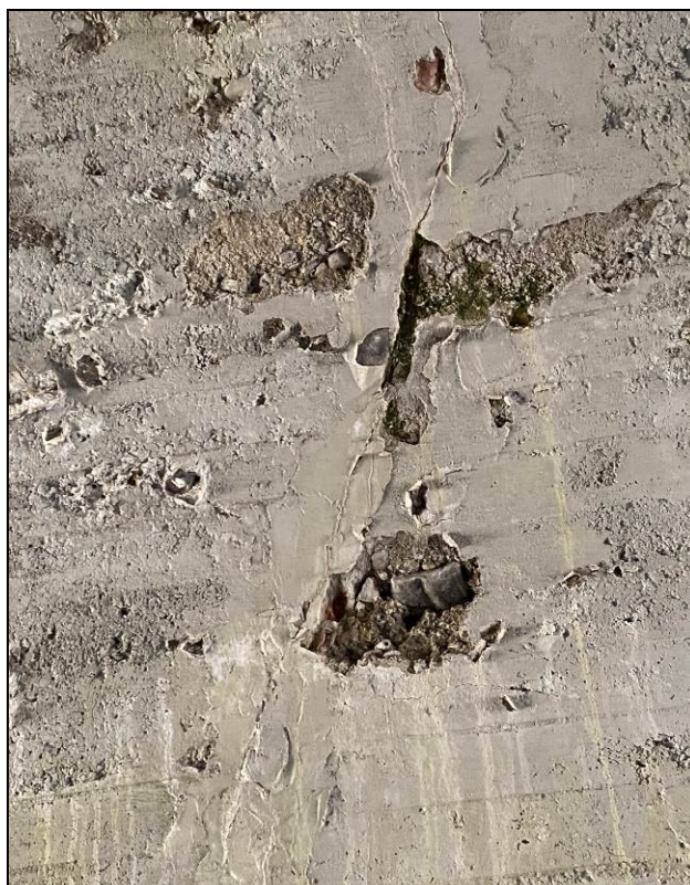
Obr. č. 23 - klenba v líci lokálně degradovaná vlivem dlouhodobých průsaků a nedostatečně zhuštěného betonu
