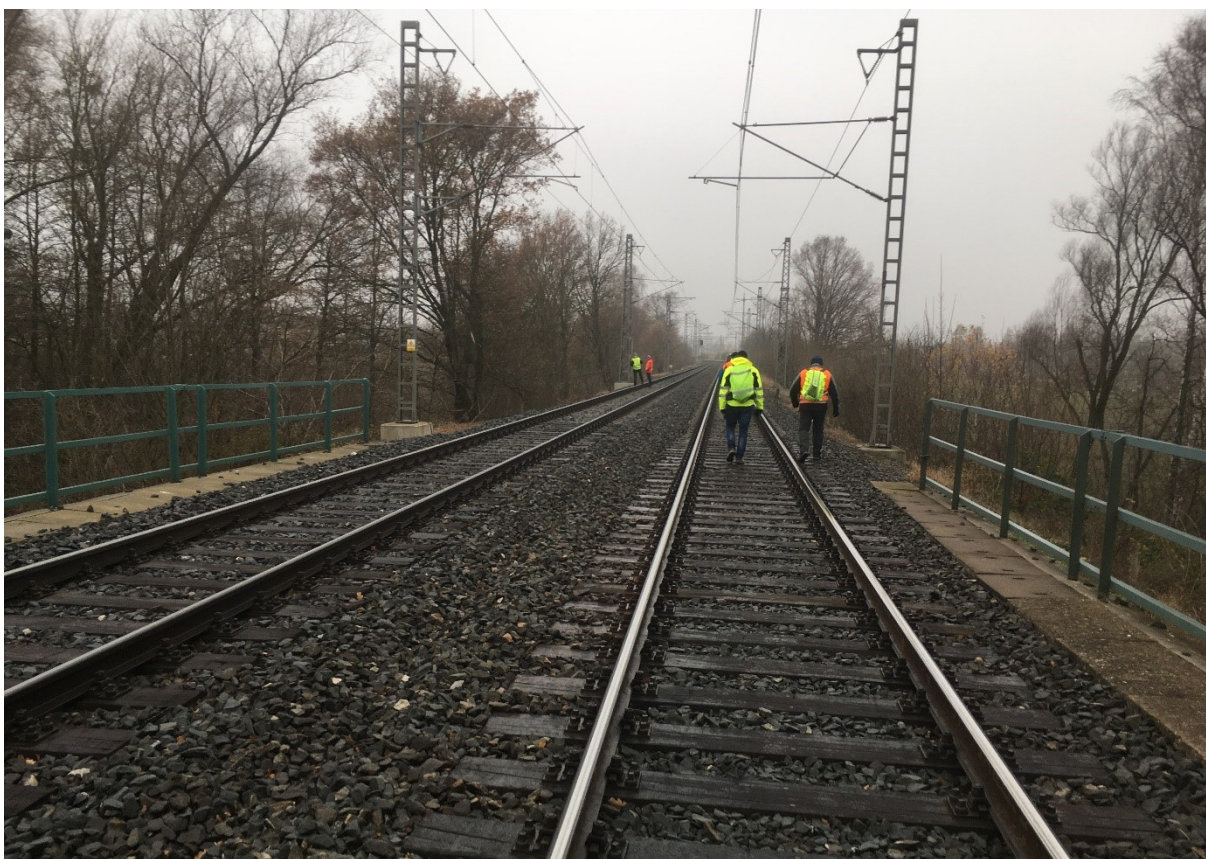
Obr. 10 Nad téměř všemi mosty jsou z důvodu nízké tloušťky kolejového lože dřevěné prachce
