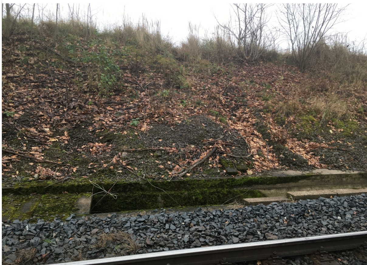
Obr. 4 Ve velké části úseku chybí poklopy příkopových zídek a je znatelná degradace svahu, který se sesouvá do odvodnění
