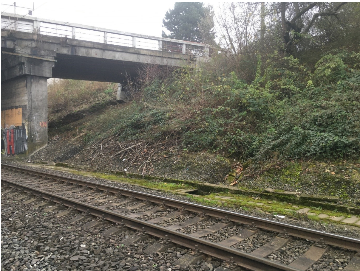
Obr. 13 Nadjezd v km 15,810 a pohled na odvodnění včetně skluzu
