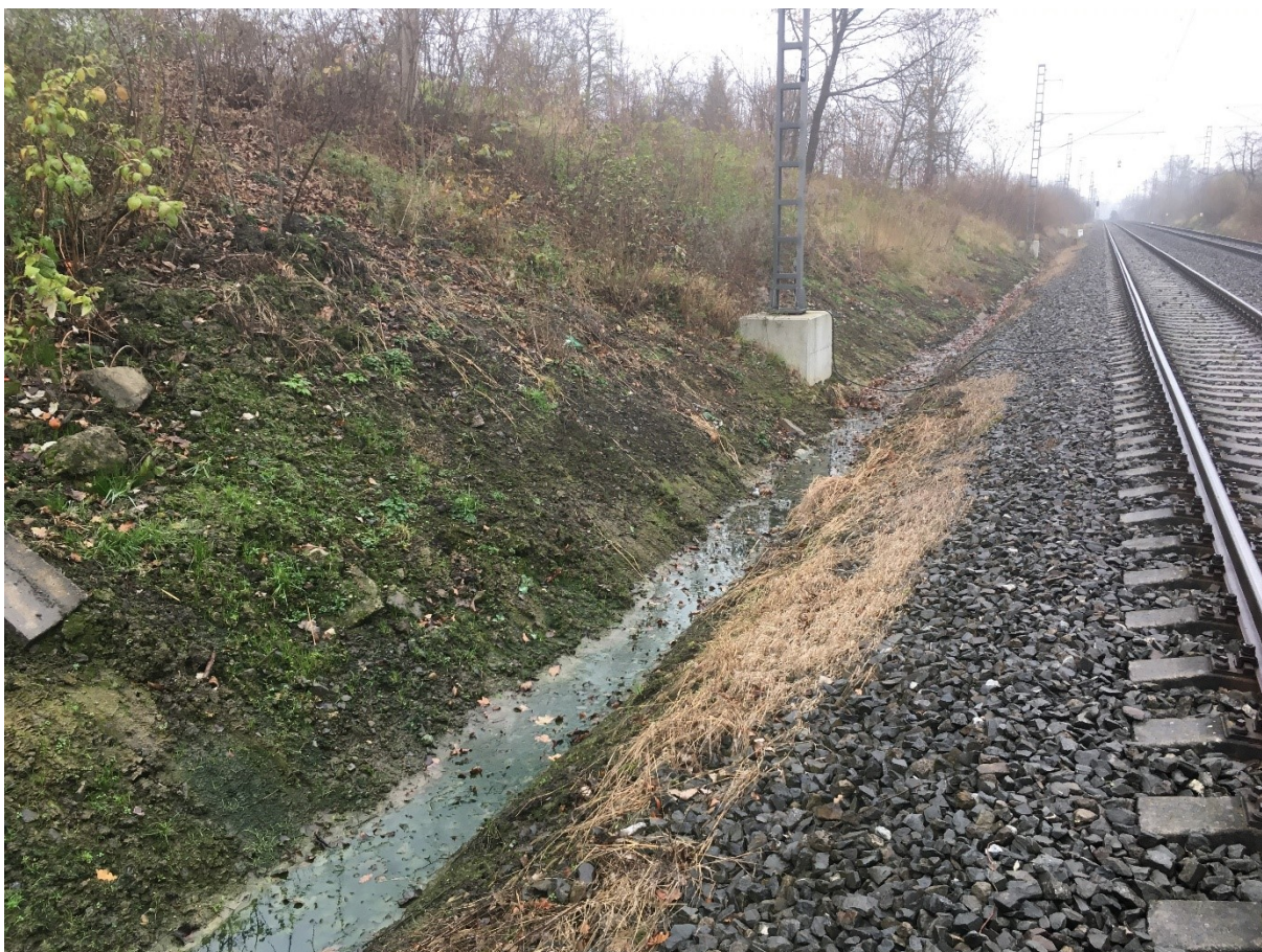
Obr. 7 Nefunkční otevřený příkop
