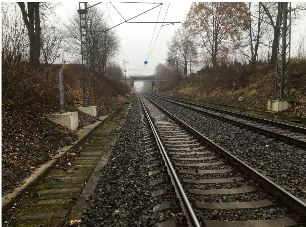
Obr. 3 Pohled na nově realizované trakční stožáry za stávajícím odvodněním
