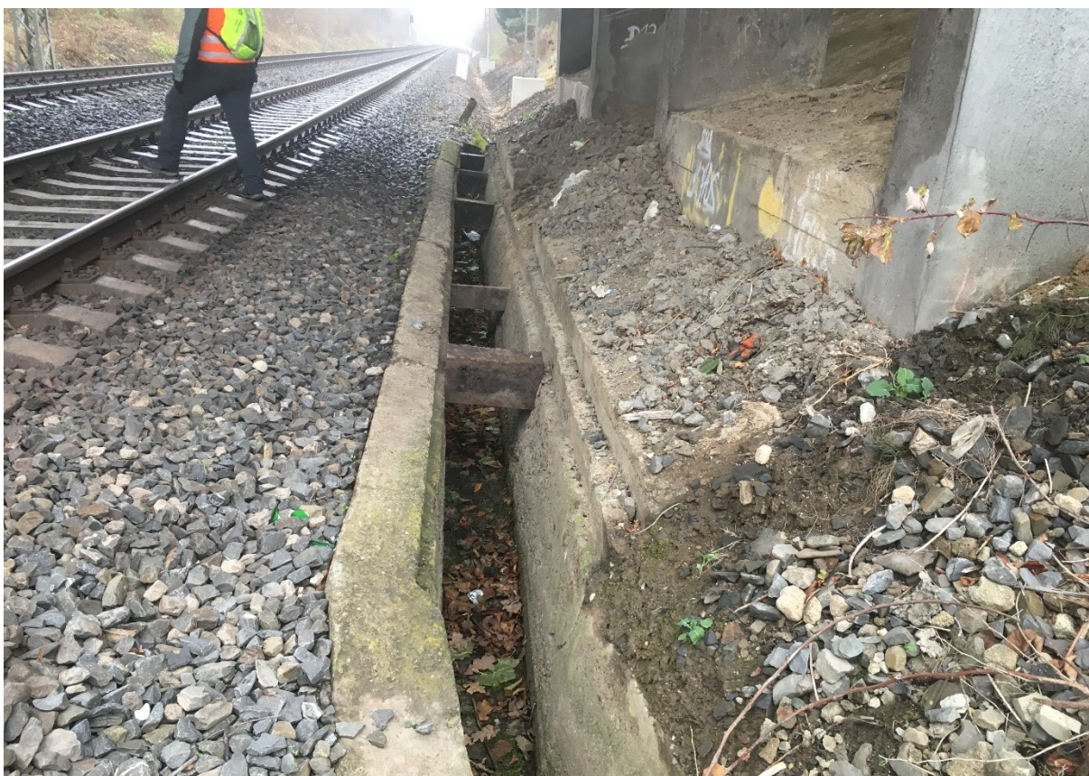
Obr. 8 Pod nadjezdy jsou příkopové zídky rozevřeny pomocí výďřev
