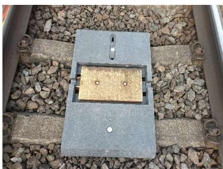
Obrázek 12 – Umístění nosiče balíz
