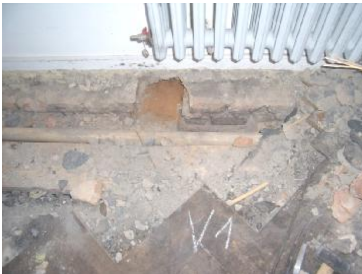
Sonda VI, zhlaví trámu poškozené hnilobou a hmyzem
